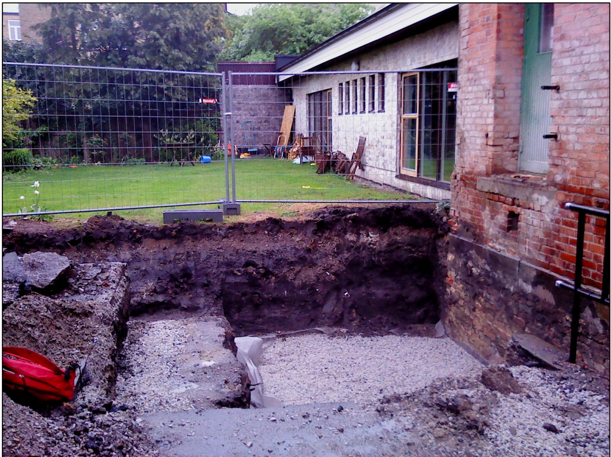
Figur 2. Hissgroppen på kv Winstrup 10 med geotextil och singel ovanpå botten (Kulturens arkiv).
