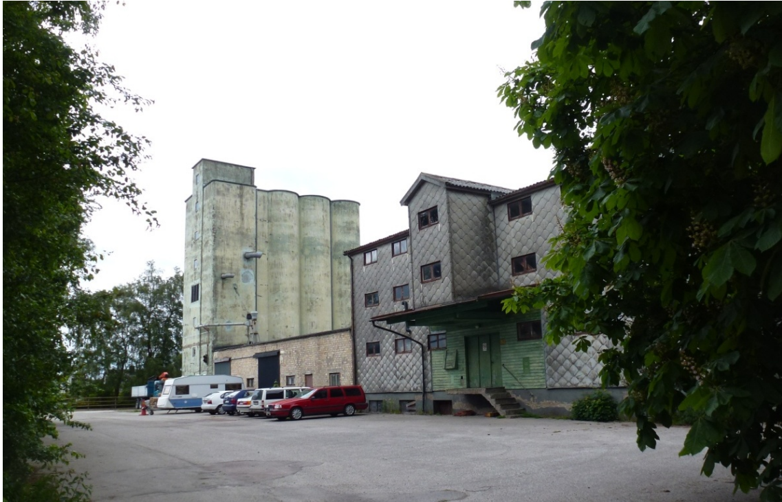
Foto Kulturen. Silon och de äldre magasinerna.
