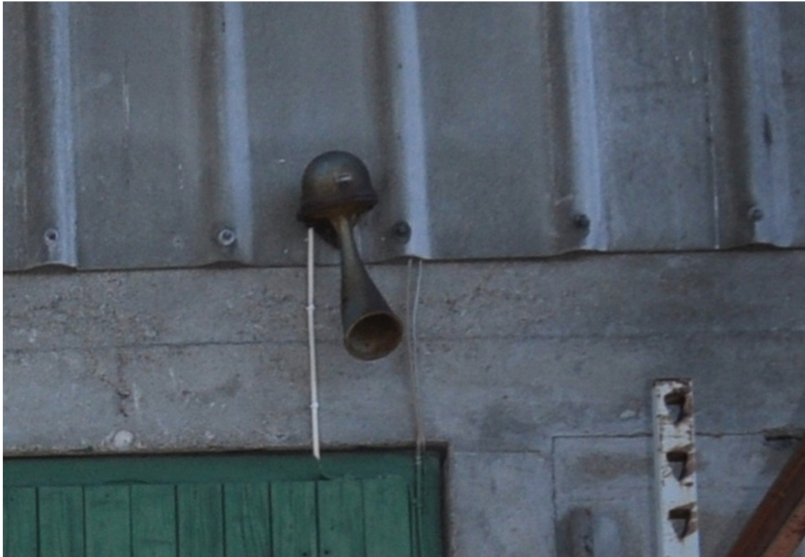
Foto Helen Carlsson, Höörs kommun: Signalhornet, intill en av portarna till silon, berättar om tiden då byggnaden ännu hade en aktiv funktion.
