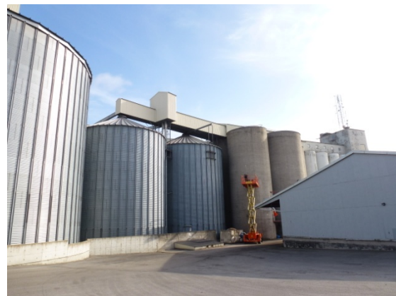
Foto Kulturen. Tork i plåt, intag, maskintorn och betongsilor samt stålsilor och planmagasin.
