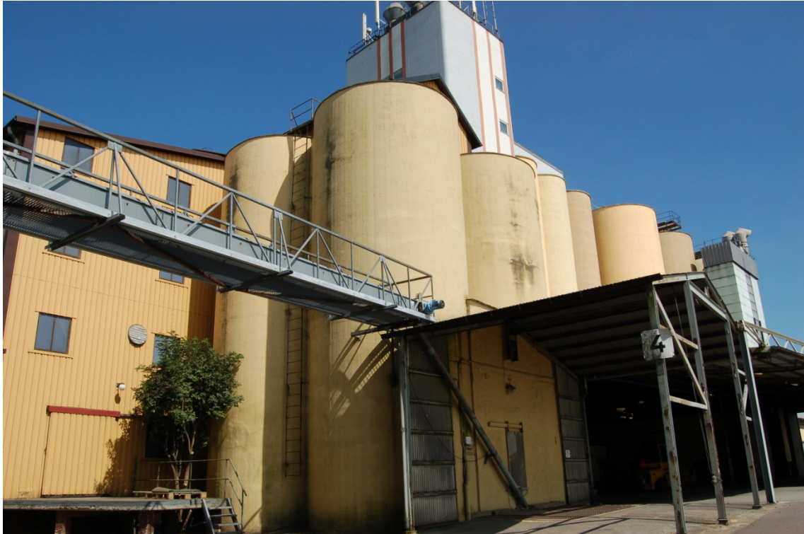
Foto Malmö Museer. Trä och betongsilor.
