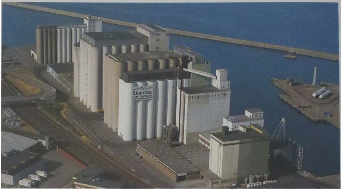
Foto: Lantmännen. Vy mot söder. På bilden är silorna ännu inte färgsatta i gula och beige nyanser.
