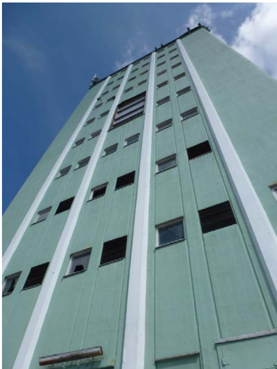
Foto Kulturen. Maskintornet är "Lantmännengrönt" med vita dekorativa listverk. Botten av silor i gjuten betong, silorna står på pelare, maskineriet är utrivet.
