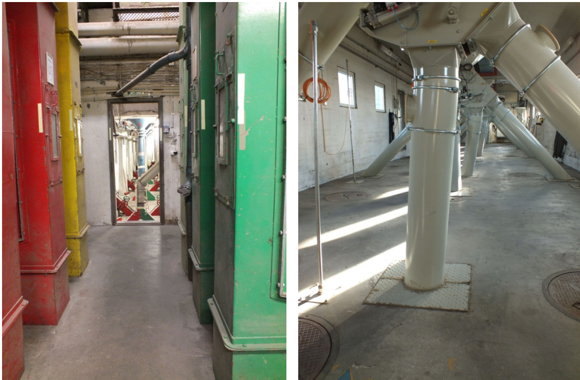
Foto Regionmuseet Kristianstad: Till vänster elevatorer från 1950-talet, dock har innanmätet moderniserats efter hand. Till höger transportanordning som fördelar fraktionerna i rätt siloceller.
