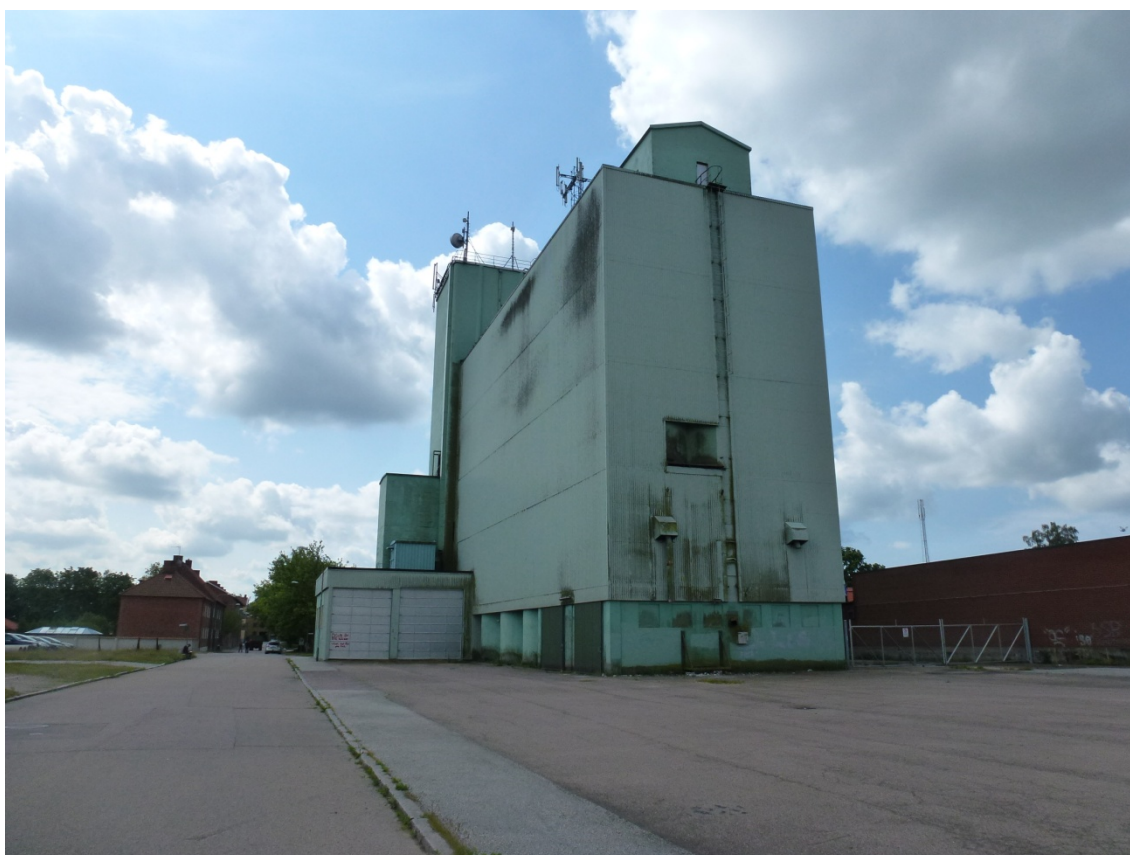
Foto Kulturen. Vy från norr. Silotornen är inklädda med plåt men de cylindriska silotornen skymtas i den nedre delen. Intaget ligger i bild vänster om tornen.
