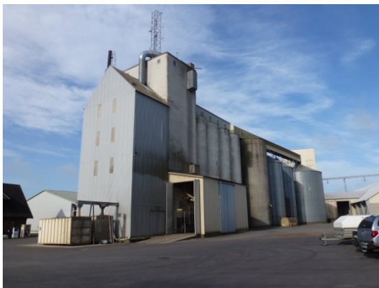
Foto Kulturen. Tork i plåt, intag, maskintorn och betongsilor samt stålsilor och planmagasin.
