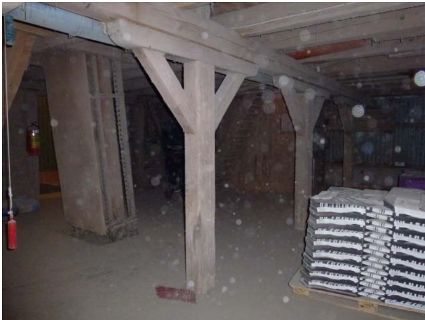
Foto Kulturen. Äldre träsilos med säckelevator. Träsilos används inte längre för spannmålslagring.
