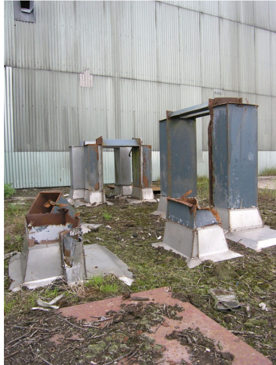
Foto Regionmuseet Kristianstad: Till vänster vattenfyllt hål som skapats efter att två stora siloceller revs. Till höger stålfundament som blivit kvar då silorna demonterades.
