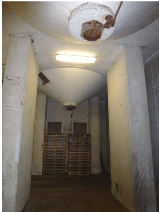
Foto Kulturen. Maskintornet är "Lantmännengrönt" med vita dekorativa listverk. Botten av silor i gjuten betong, silorna står på pelare, maskineriet är utrivet.
