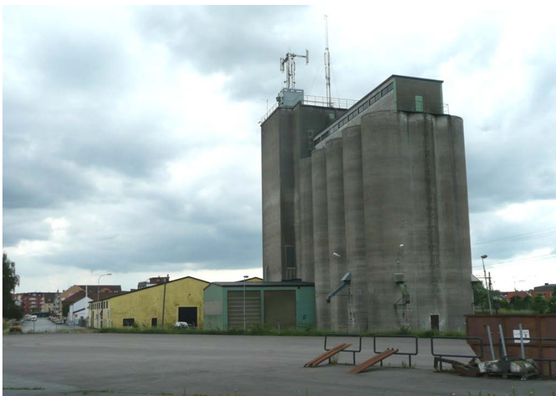
Foto Kulturen. Silon sett från norr, järnvägen ligger till höger i bild.
