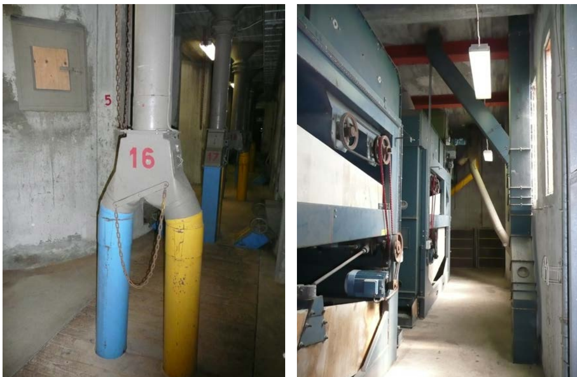
Foto Kulturen. Vid botten av silorna. Luckor i rundcellerna. Tvåvägsfördelare, rör, från stjärnceller leder spannmålet till transportören under golvet för utlastning. Höger: Rens från CIMBRIA i maskintornet på övre plan.
