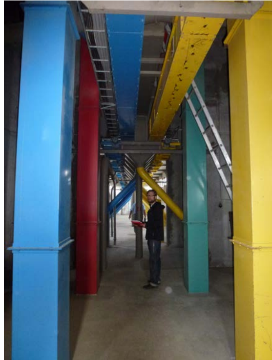
Foto Kulturen. Verkstad på första våningen under en silocell. Till vänster i bild går man in till pannrummet och till höger står maskintornet. Under brädorna i golvet går transportbandet för utlastning på järnväg. Höger: Systemet med elevatorer och transportband är markerat med färg för olika silor. Våningsplanen är höga och miljön är alltid välstädad och ren.
