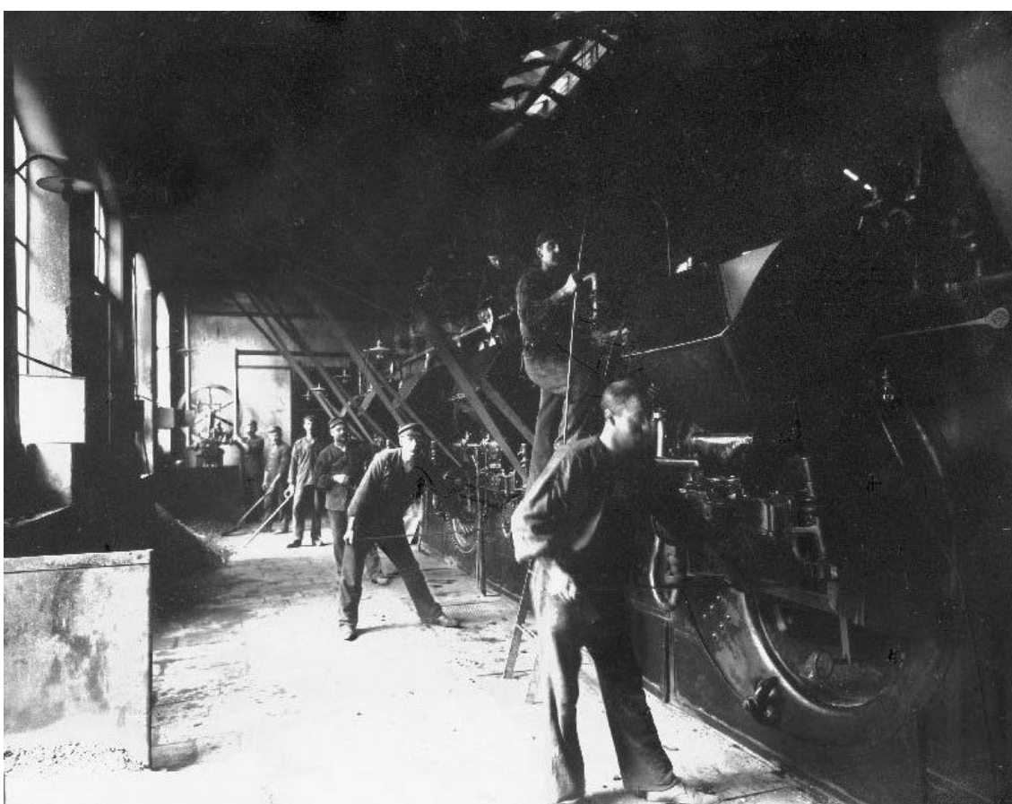
Malmö Stora Valskvarn från norr 1904 och interiör från Malmö Stora Valskvarn i början av 1900-talet.
