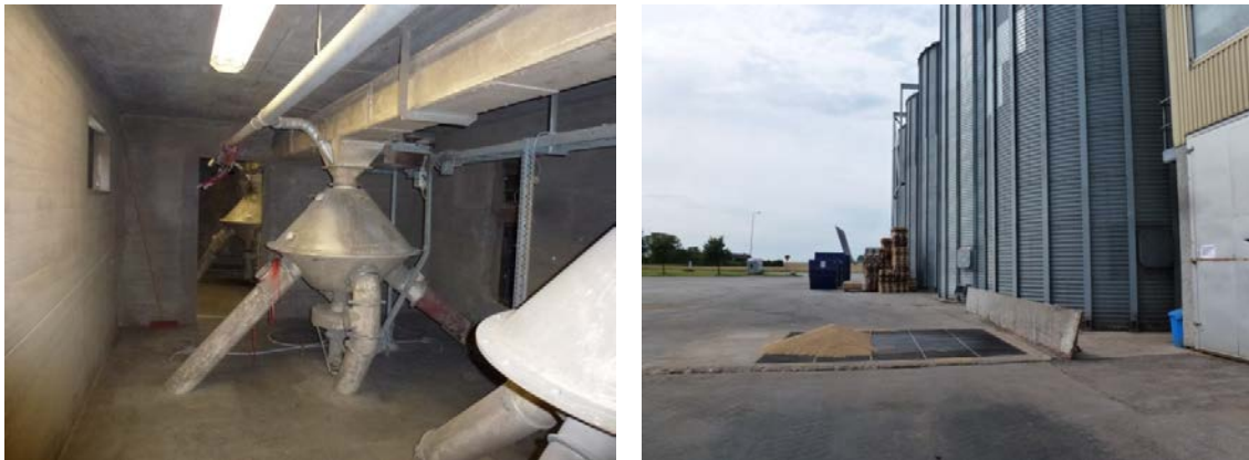
Foto Kulturen. Fyrvägsdelare på toppen av silorna i betong fördelar spannmål till cellerna. Intaget består av grop i marken försett med galler. På gallret ligger kvar lite spannmål som precis tippats av.
