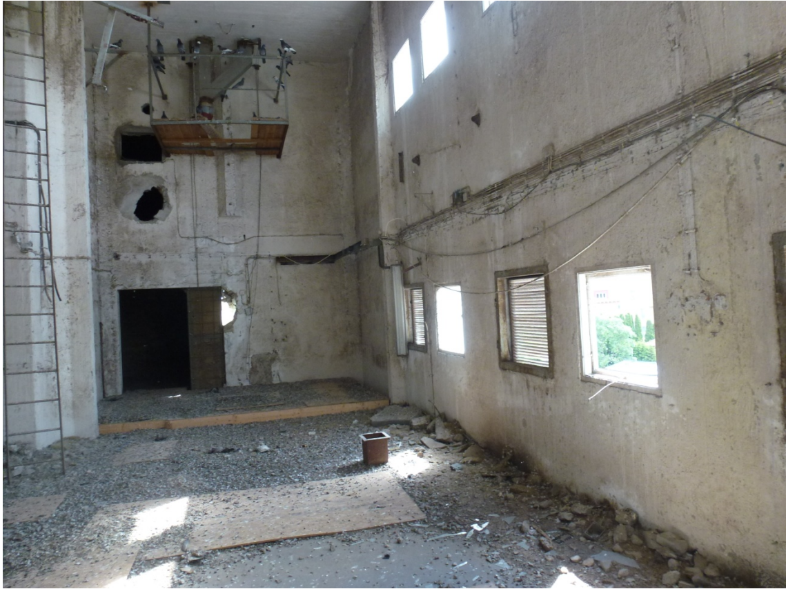
I den nedlagda silon är maskineriet utrivet. På grund av trasiga fönster har fåglar tagit sig in och smutsat ner.
