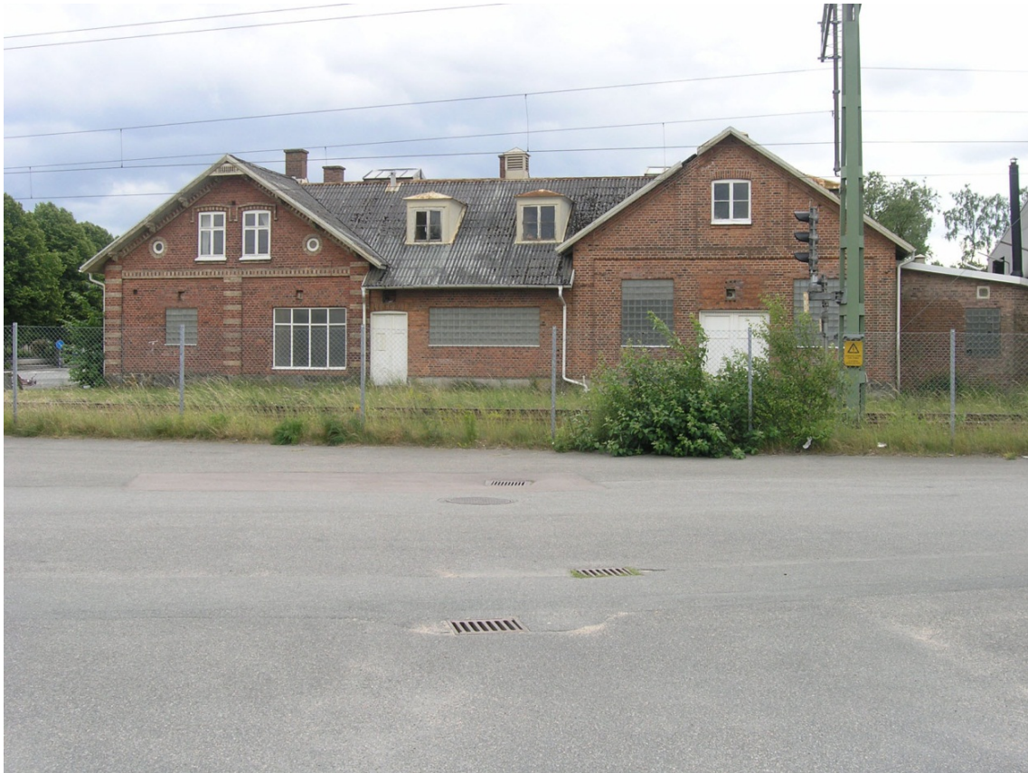
Foto Regionmuseet Kristianstad: Lantmännens anläggning i Vinslöv omfattar förutom silobyggnader även ett före detta mejeri.
