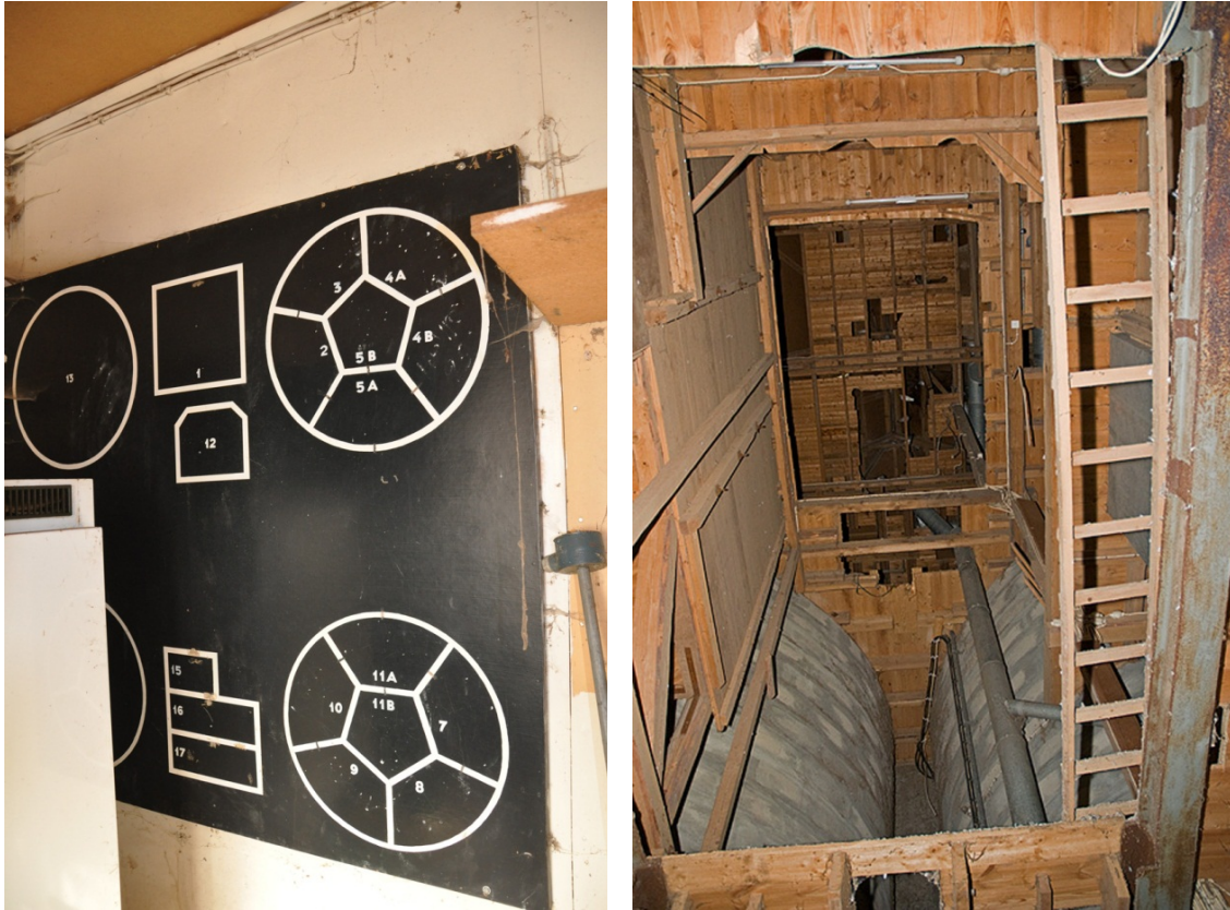
Foto Helen Carlsson, Höörs kommun: Till vänster tavla med silocellernas fraktionsindelning. Till höger interiörbild från tork- och maskintornet, tagen nerifrån och upp.
