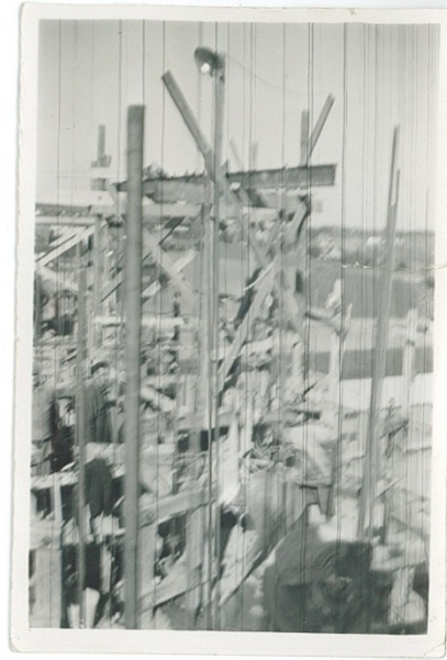
Silon underuppförande i glidgjuten betong. Källa: Privat fotografi Kenth Mårtensson
