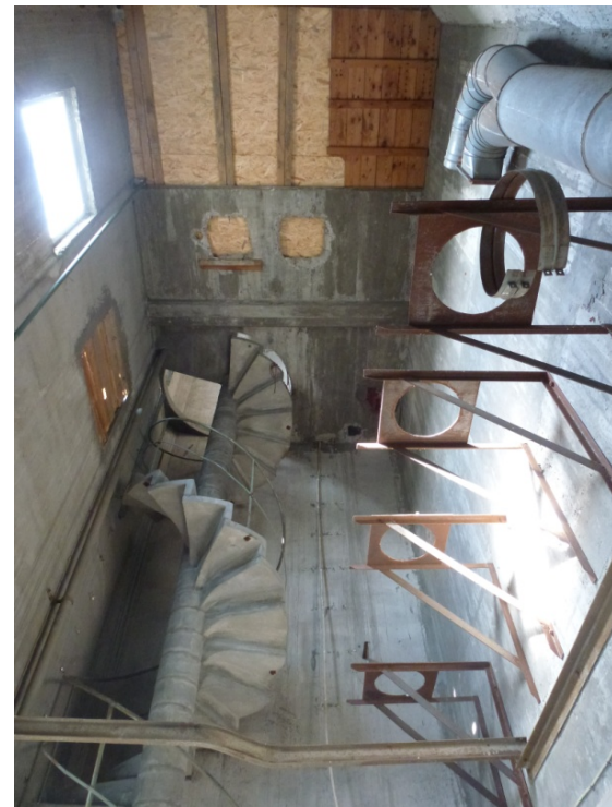
Foto Kulturen. Gången mellan botten av silocellerna med luckor till transportbandet under golvet. Höger: Betongtrappan mellan de olika våningsplanen och hål efter bortmonterad utrustning.
