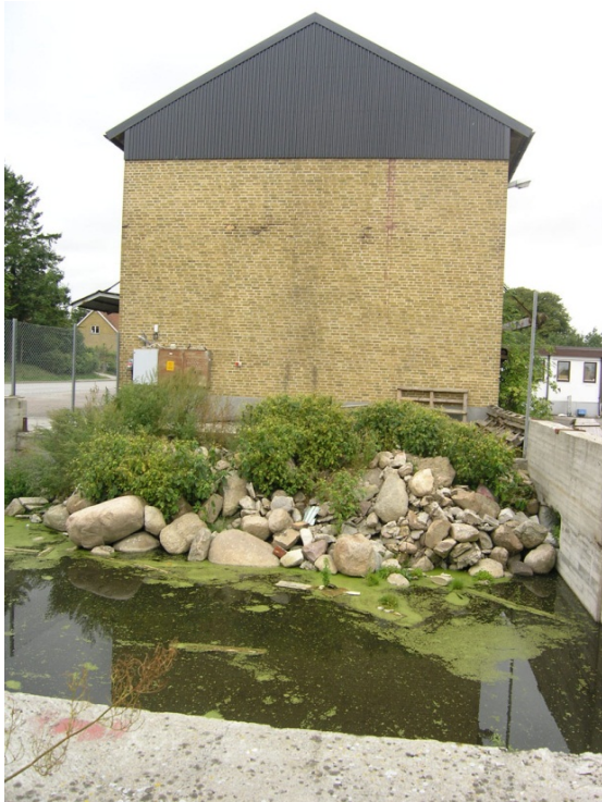
Foto Regionmuseet Kristianstad: Till vänster vattenfyllt hål som skapats efter att två stora siloceller revs. Till höger stålfundament som blivit kvar då silorna demonterades.
