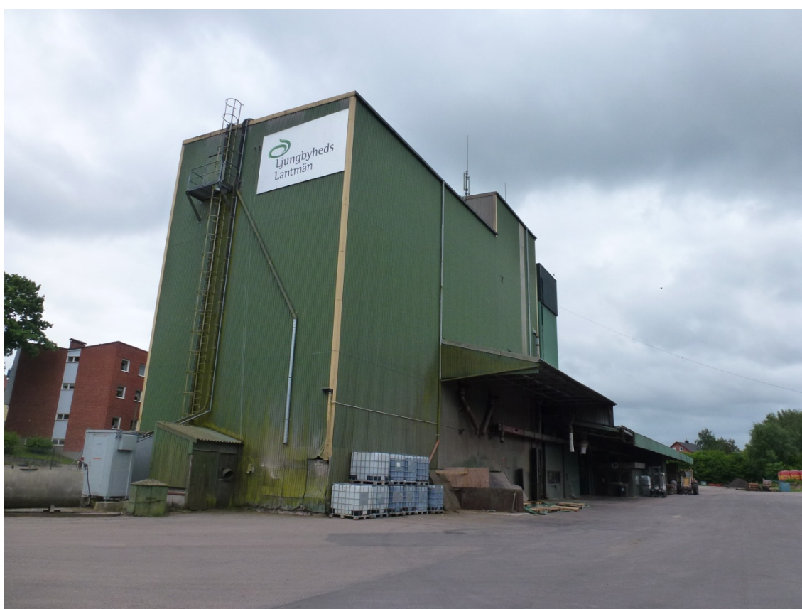
Foto Kulturen. Vy från norr. Silorna och foderfabriken är inbyggda i den höga plåtbyggnaden. Järnvägen passerade förr anläggningen i väster vilket är till höger i bild.
