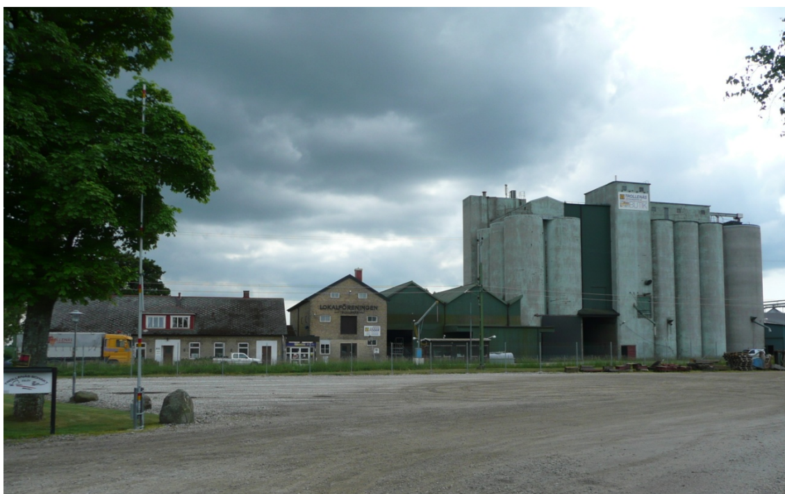
Foto Kulturen. Vy från norr. Från vänster i bild kontor, lokalföreningens gula tegelbyggnad som är utbyggd med gröna plåthallar, silo från 1950-talet, 1960-talet och 1970-talet.
