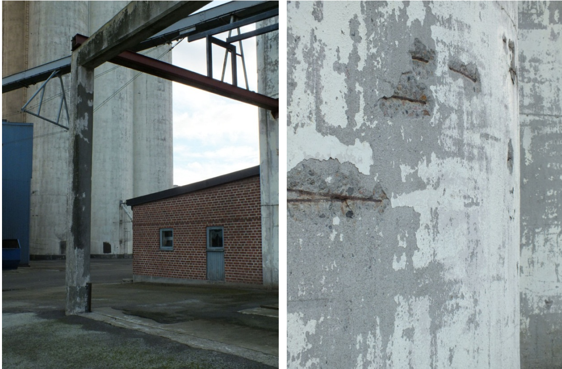
Foto Regionmuseet Kristianstad: Till vänster transportanordningar mellan anläggningens olika delar. Till höger detalj av en silocells betongfasad där armeringsjärnen tittar fram.
