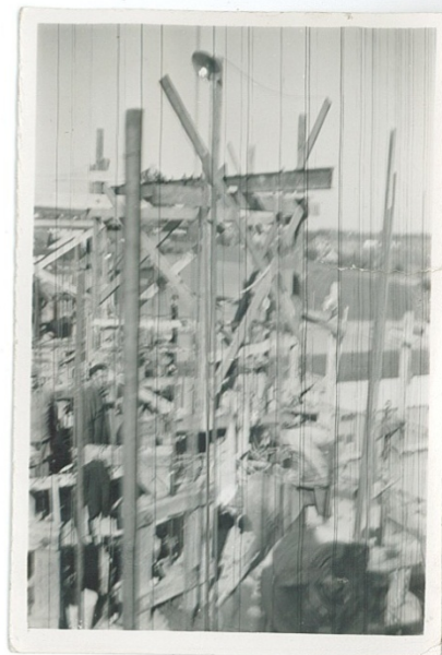
Dalby silor under uppförande i glidjuten betong 1953. (Bild privat fotografi Kenth Mårtensson)
