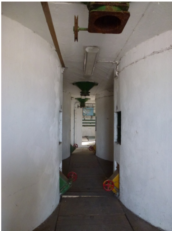
Foto Kulturen. Gången mellan botten av silocellerna med luckor till transportbandet under golvet. Höger: Betongtrappan mellan de olika våningsplanen och hål efter bortmonterad utrustning.
