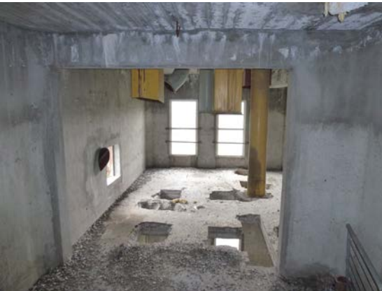
Foto Kulturen. Maskineriet är utrivet vilket orsakat stora hål i bjälklagen. Milsviad utsikt över Kullahalvön från taket.
