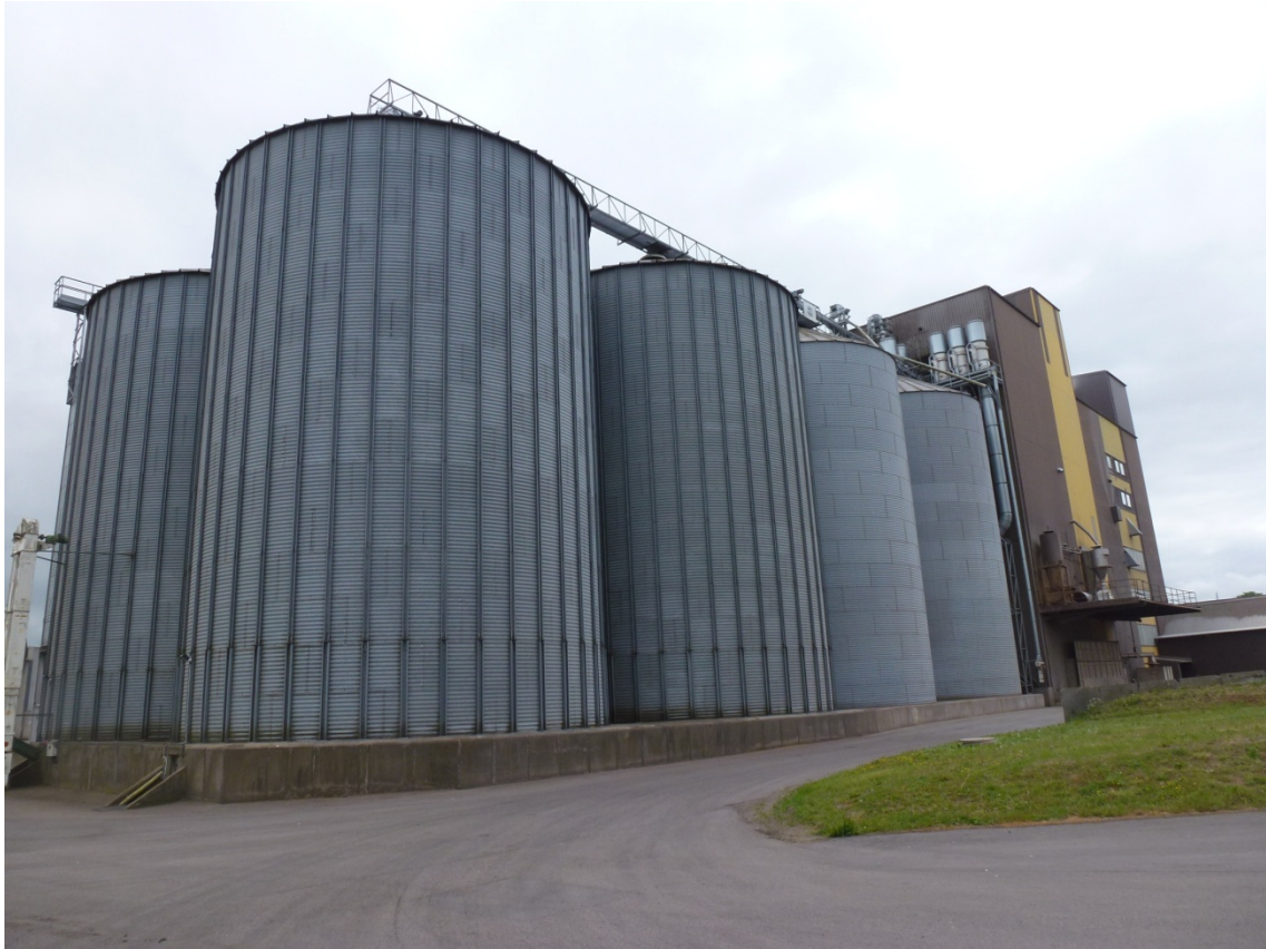
Foto Kulturen. Plåtsilor med olika fasader, kvarn och kontor finns i den gula och bruna byggnaden.
