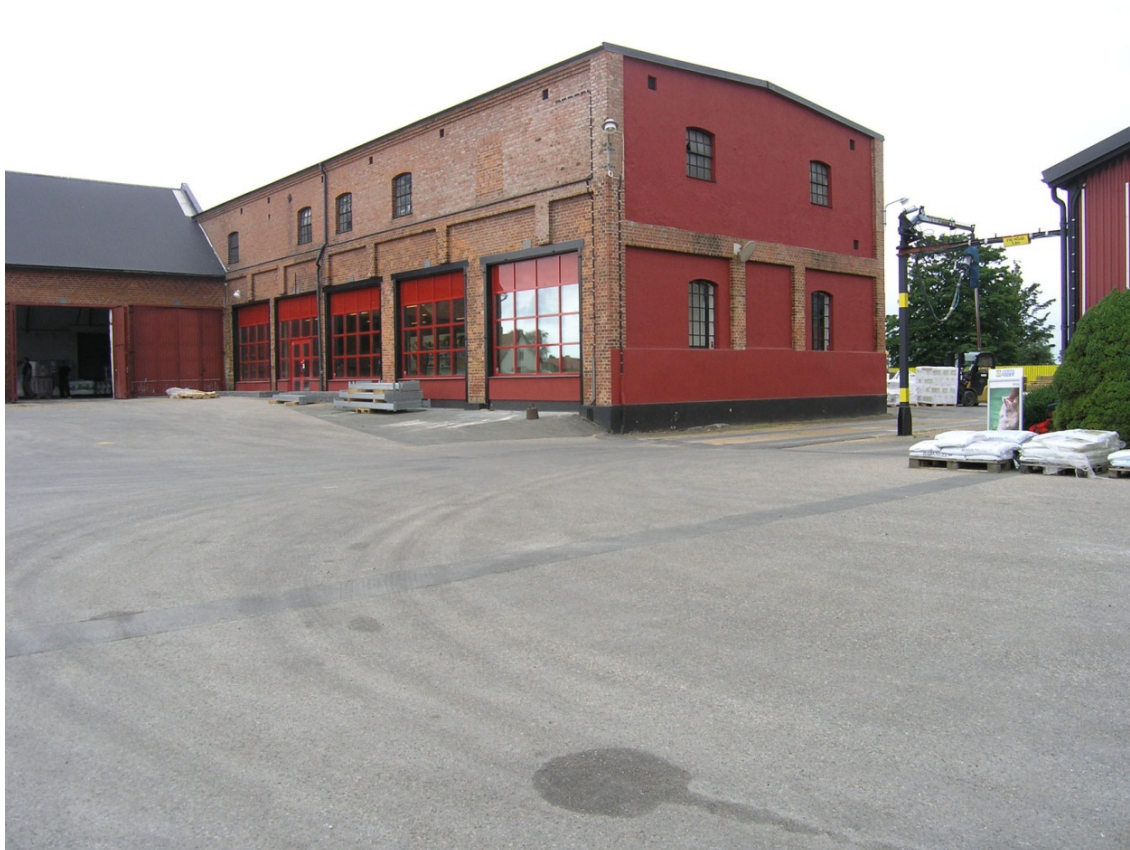
Foto Regionmuseet Kristianstad: Svenska Foder byggde helt nyligen om den gamla stärkelsefabriken till butik.
