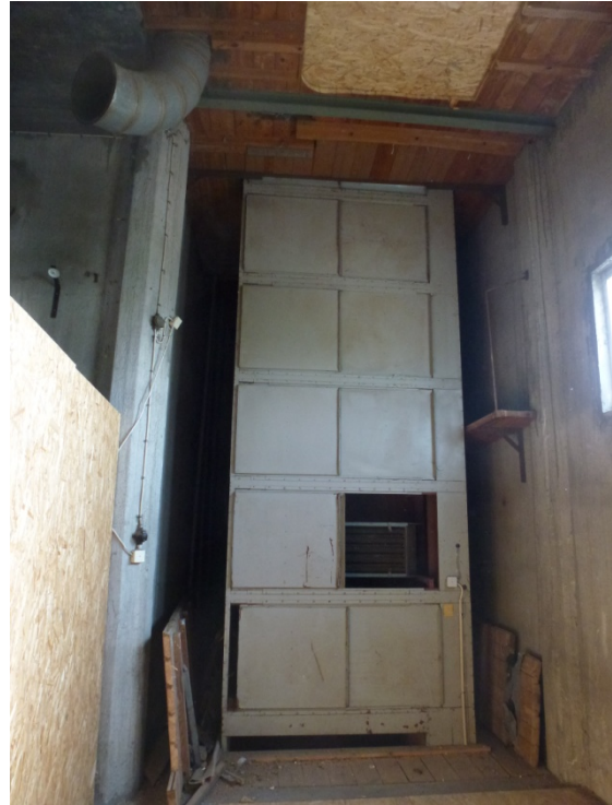
Foto Kulturen. Överst i maskintornet. Torkar och trissorna på golvet för den manuella manövreringen av luckorna mellan tork och silo. Höger: del av torken i maskintornet.
