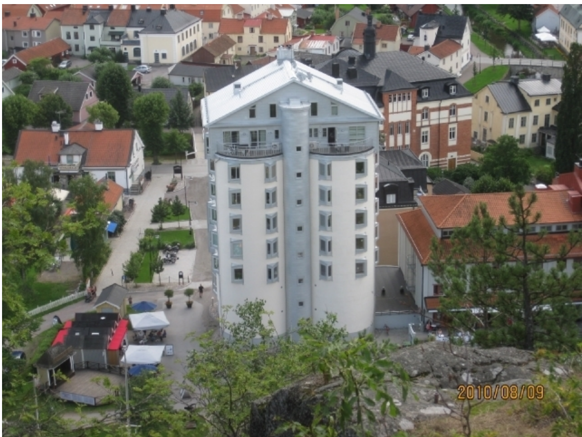
Silon i Söderköping efter ombyggnad.
