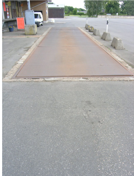
Foto Regionmuseet Kristianstad: Till vänster ingick till maskintorn och torkanläggning med intagningsgallret i förgrunden. Till höger markvåg för last invid planlagret i tegel.
