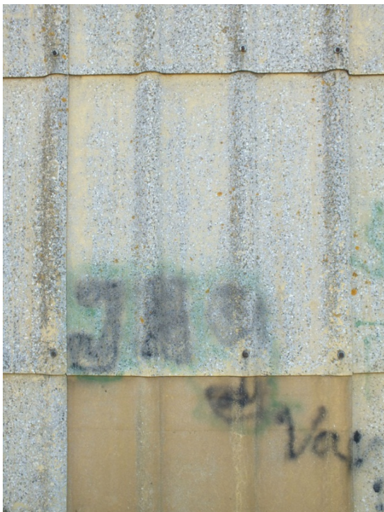
Foto Regionmuseet Kristianstad: Till vänster detalj av skivtäckt eternit i grågult. Till höger sädesmagasinet på Gårdslösavägen intill lanthandeln.
