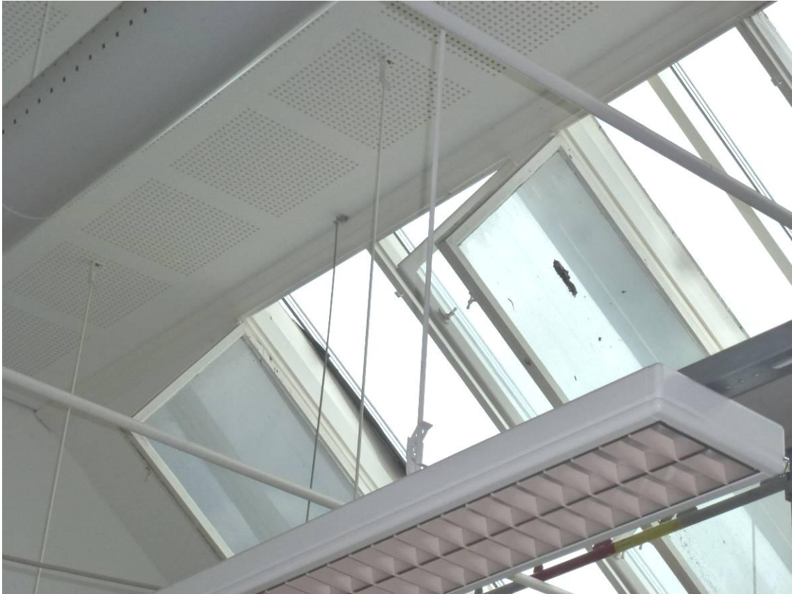
Figur 12. Innerbågarna är smäckra med vred. Innerbågarna behålls. Skadade delar byttes och fönstren målades.
