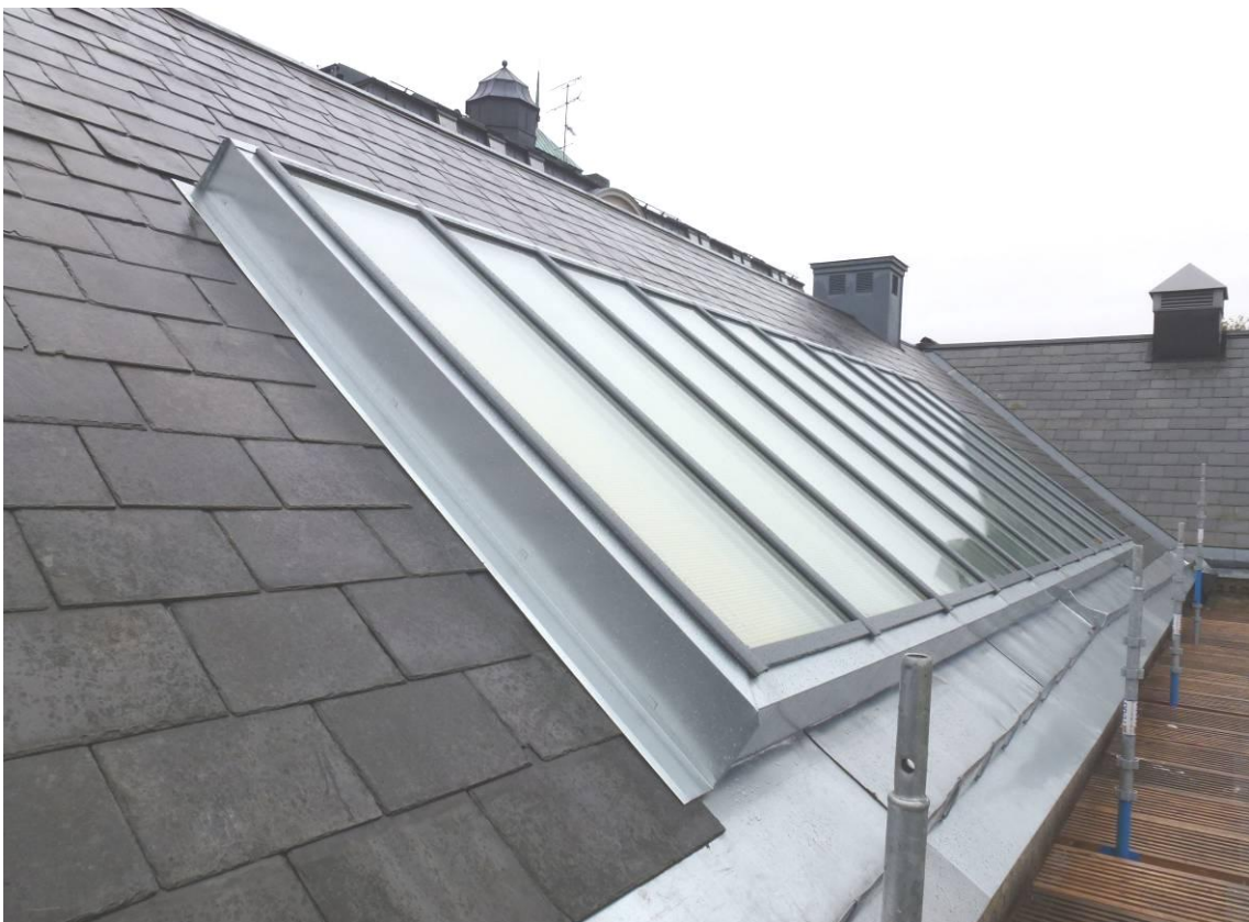
Figur 15. Efter åtgärderna. Plåten i fotrännan och sargen ska målas efter två till tre år med linolfärg och grundas med järnmönja. Spröjsen i aluminium är målad. Fotränna i samma mått som före åtgärderna och med konsoler som ligger tätt mot rännan.
