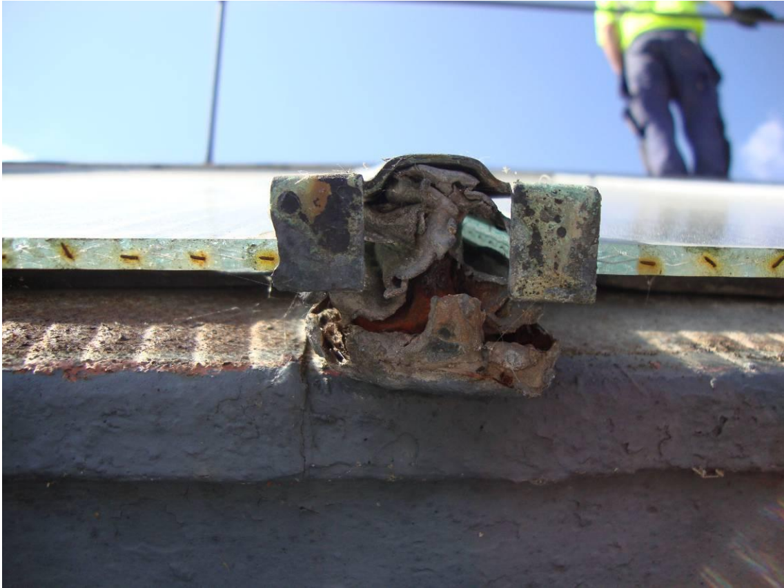
Figur 8. Foto före. Nedre kanten av glaset och spröjsen i bly. Spröjsen är i dåligt skick och plåten rostig.
