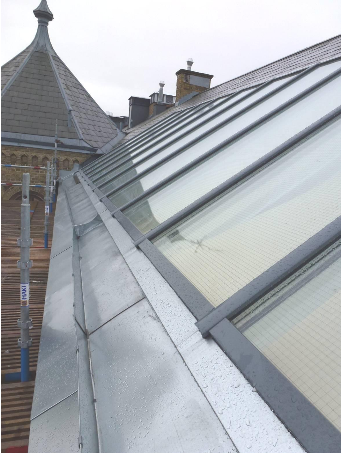
Figur 16. Efter åtgärderna. Plåten i fotrännan är i ungefär samma längd som den gamla.
