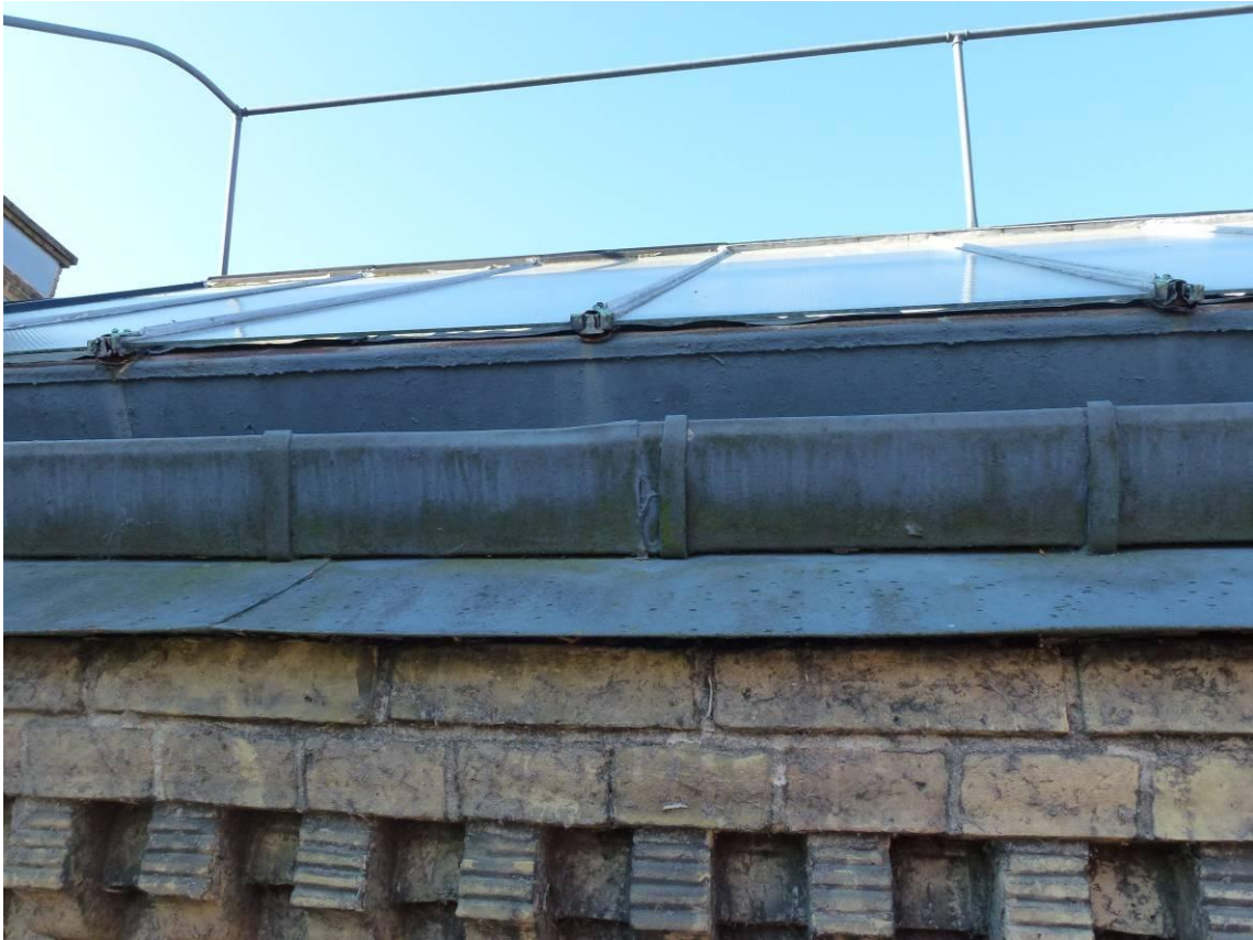
Figur 6. Foto före. Glaset är otätt och plåten rostig.
