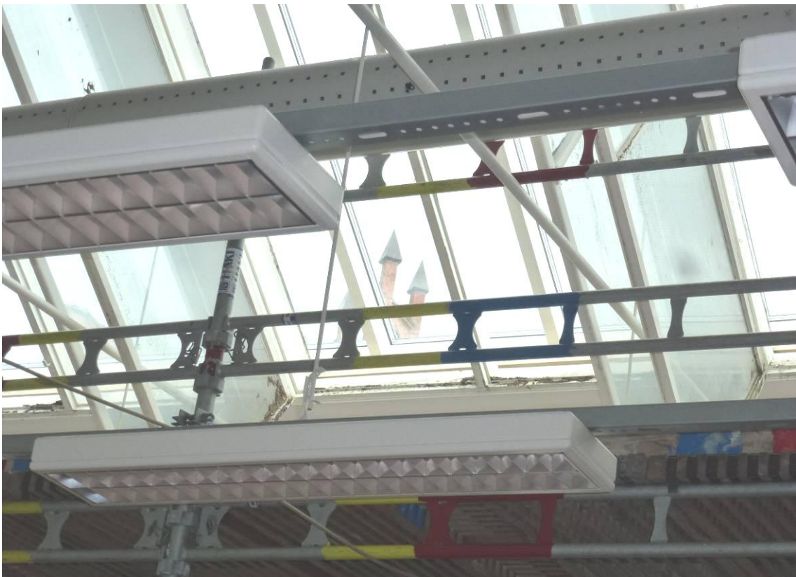
Figur 13. Här syns den nya lanterninens insida med vita bågar och de gamla smäckra innerbågarna före restaurering.
