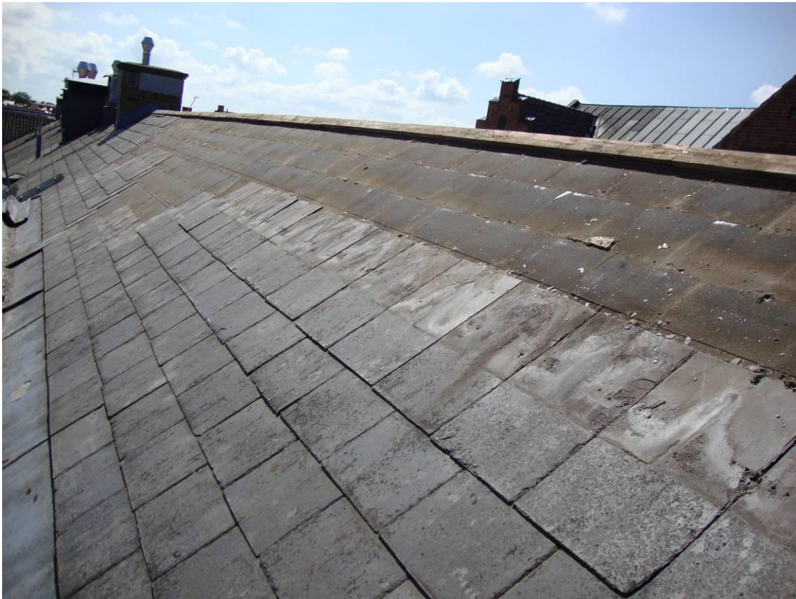
Figur 9. Taksiffer under nedmontering, nockbrädan och takpappen är synlig.
