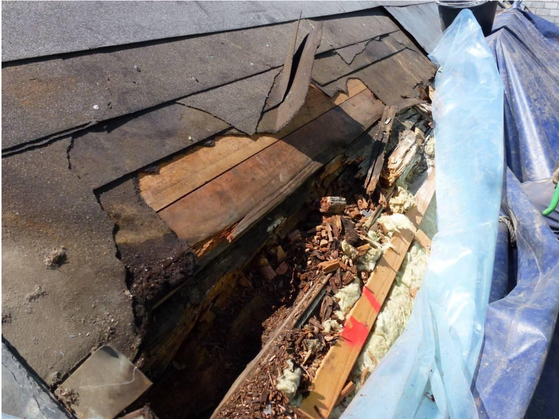
Figur 10. Under arbetet upptäcktes en rötskadad avväxlingsbalk och underlagsbrädor i det östra övre hörnet av lanterninen. Dessa ersattes.
