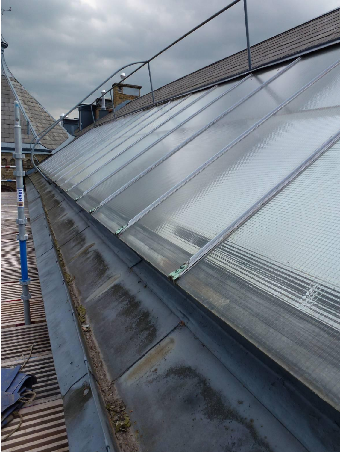
Figur 5. Före åtgärder. Vy från nordväst. Plåtarbeten och fotränna i målad galvaniserad plåt. Lanternin med trådarmerat glas och tunna spröjsar i bly.
