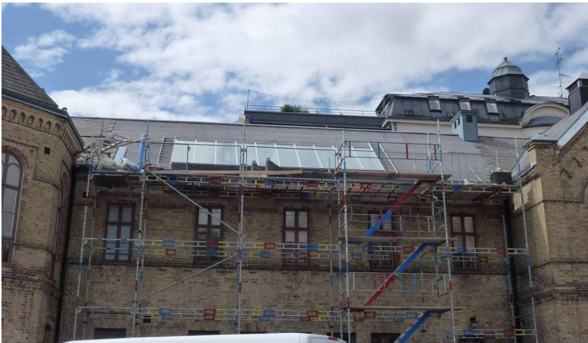
Figur 11. Den nya taklanterninen är uppmonterad och takpappen är ersatt på hela ytan kring lanterninen.
