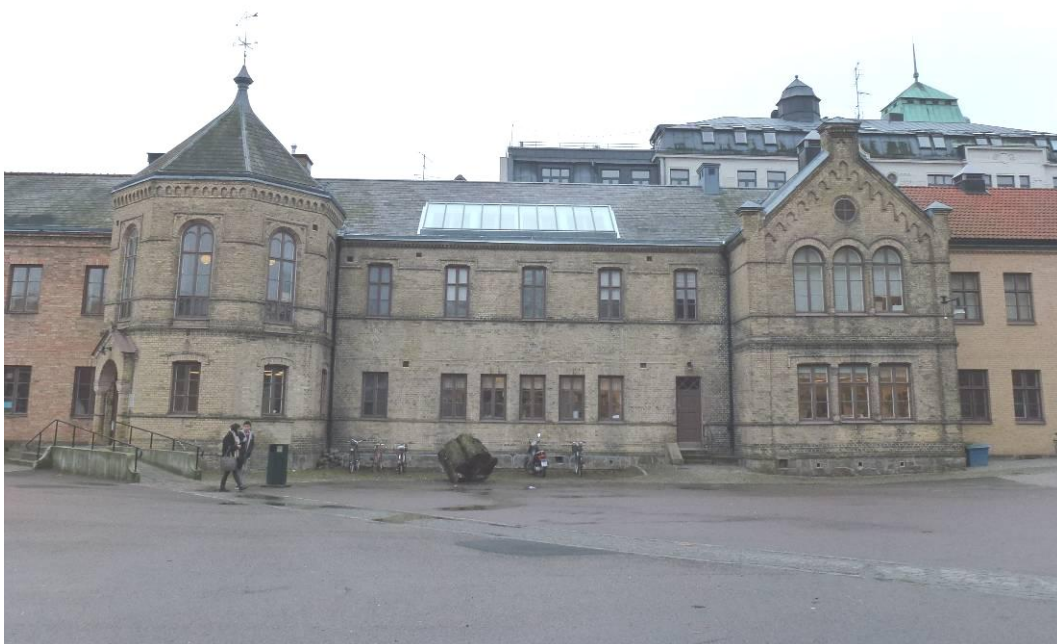
Figur 1-2. Katedralskolans norra sida med taklanternin före, övre bilden, och efter åtgärder, undre bilden.
