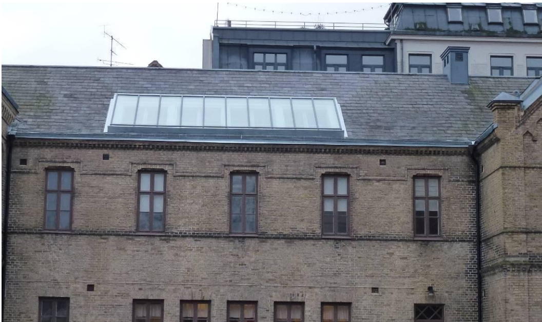
3-4 Lanterninen på det norra takfallet. Övre bilden före åtgärder, nedre bilden efter åtgärder.
