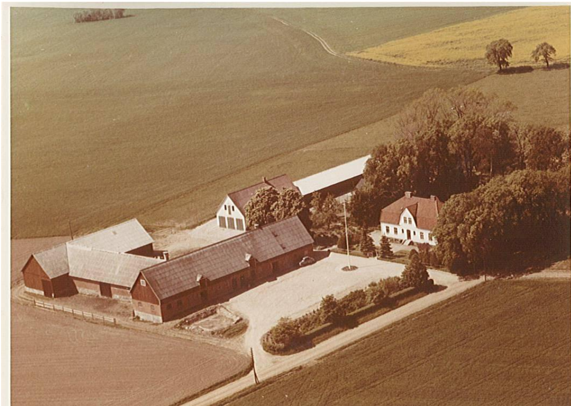
Vy från söder 1950-talet. Byggnaderna är de samma som finns idag. Här är dörrar och portar i ekonomilängorna brunmålade och mangården har två fönster i frontespisen. Källa: Privat fotografi fam. Pihlsgård.
