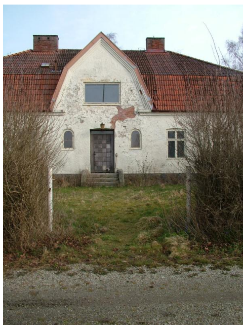
Figur 2. Ingångsparti med Ligusterhäck. Grindstolpar av järn där grinden saknas.
