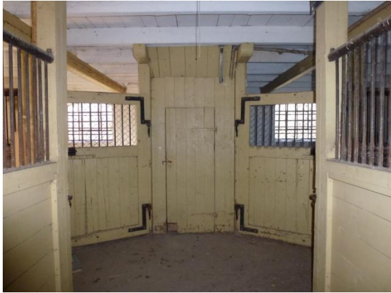
Fölboxarna i häststallet, vy mot norr.
