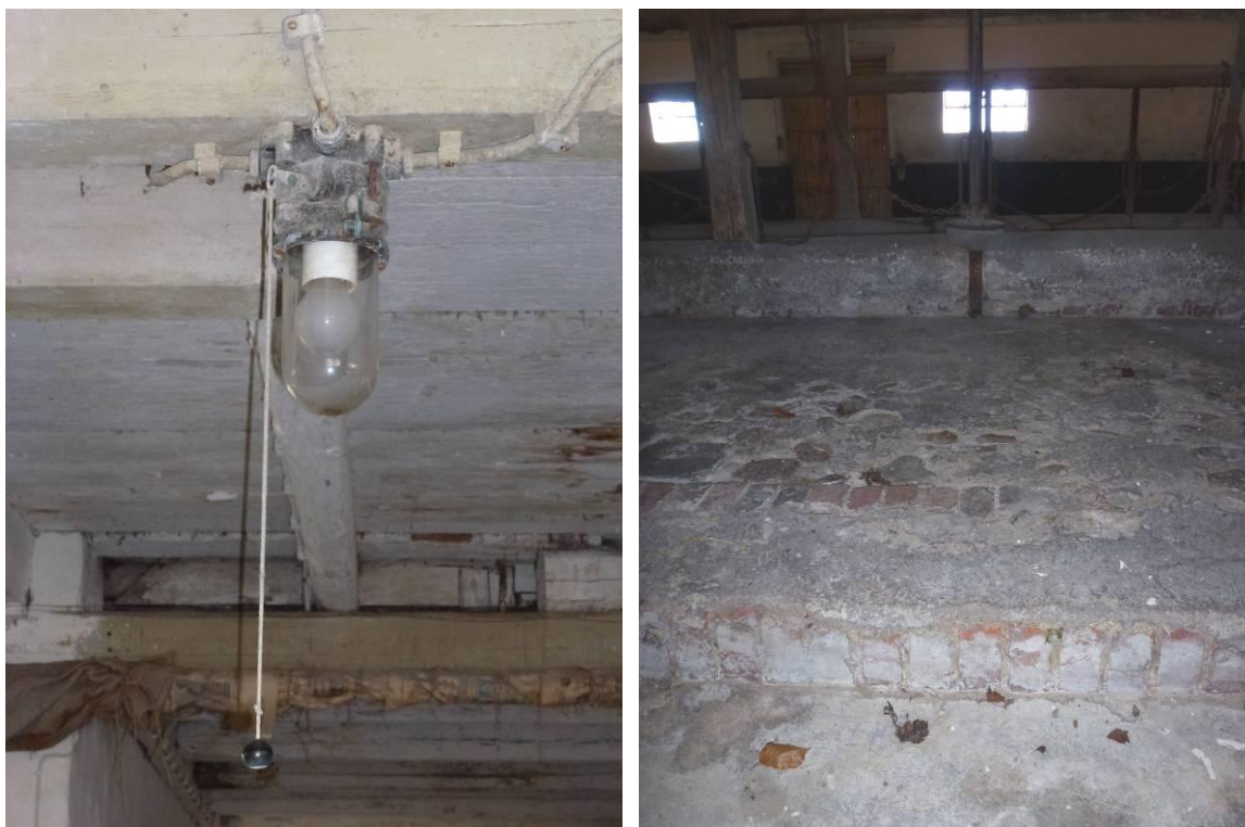
Stallampa. Kobås med det äldre golvet av tegel och kullersten under betonggolvet samt murad ränna av tegel.
