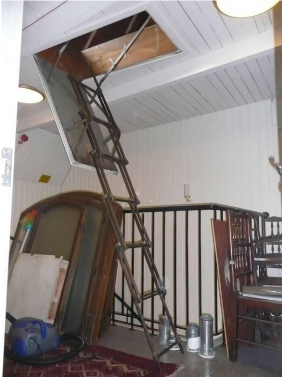
Figur 30-31. Den äldre vindsstegen (vänster) som ersattes med en ny i trä (höger).
