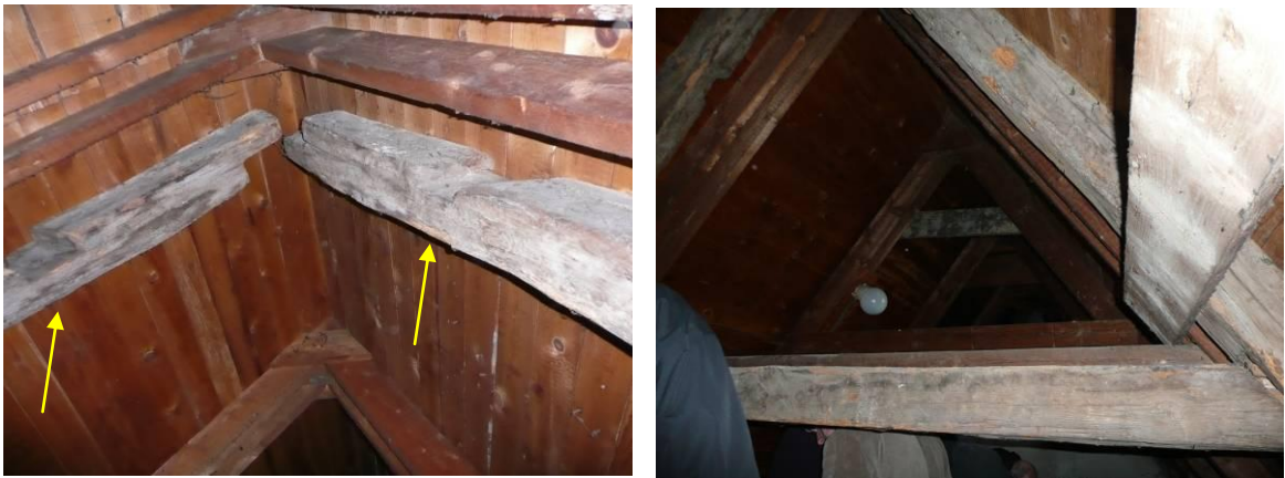
Figur 22. Den äldre bilade takstolen är ur läge i nock, urtag för ev. tidigare hanband (pil). Längre ner på sparrarna finns ett urtag till, för infogning med tapp. Till höger hanband infäst i sparran med tapp.
