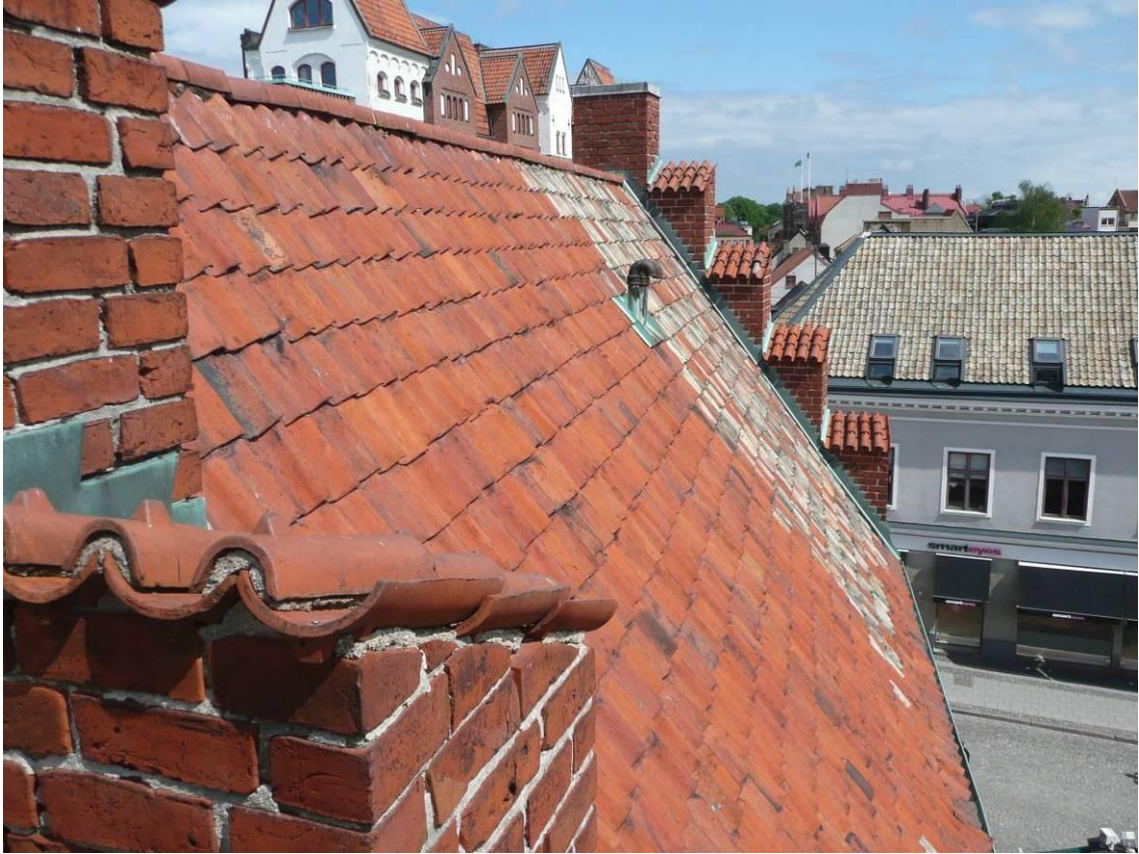
Figur 5. Före åtgärder, södra takfallet. Vittrad fog och lösa tegelpannor på trappstegsgaveln. Tre luftningsrör på takfallet.
