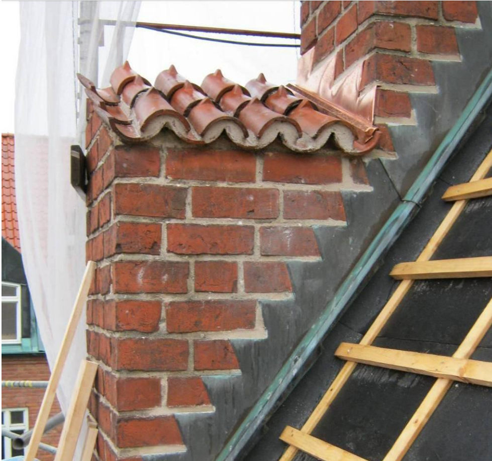
Figur 13. Fästa munk- och nunnetegelpannor, ny kopparplåt i vinkeln. Omfogningar har utförts vid plåtfästningar.
