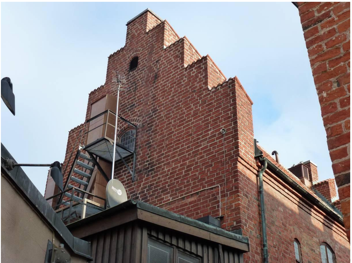
Figur 20. Efter åtgärder. Västra gavelfasaden. Fasaden har tvättats med borste och vatten.
