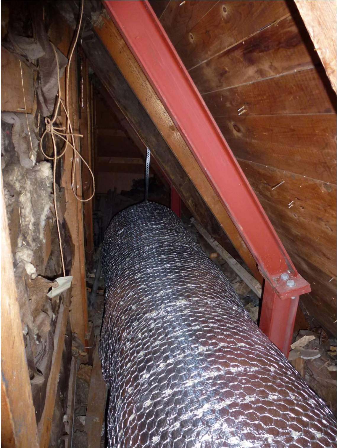
Figur 27. Kattvinden på den norra sidan på plan 3. Vy mot öster. Ny ventilationstrumma. Nya röda stålbalkar som förstärker vindsbjälklaget. Man kan även skymta den äldre bilade takstolen.
