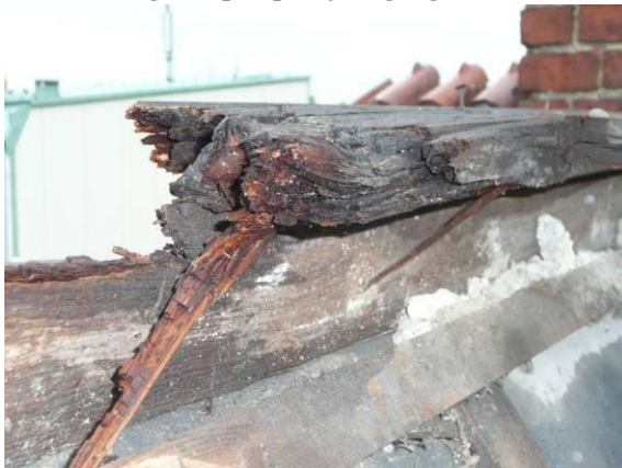
Figur 6. Ovan: Öppen murverkskanal i trappstegsgaveln. Figur 7. Till höger: Igensatt öppning och fästa tegelpannor. Plåten mot trappstegsgaveln har inte monterats ännu. Figur 8-9. Nedan: Nockbrädan var kraftigt rötskadad. Tegelstämplar på befintligt tegel.
