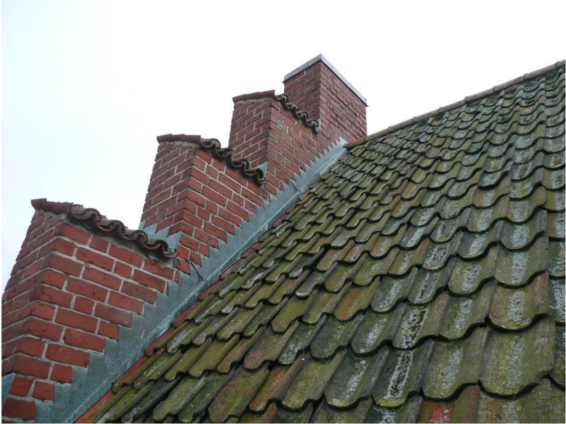
Figur 10. Före åtgärder, norra takfallet och östra trappstegsgaveln.
