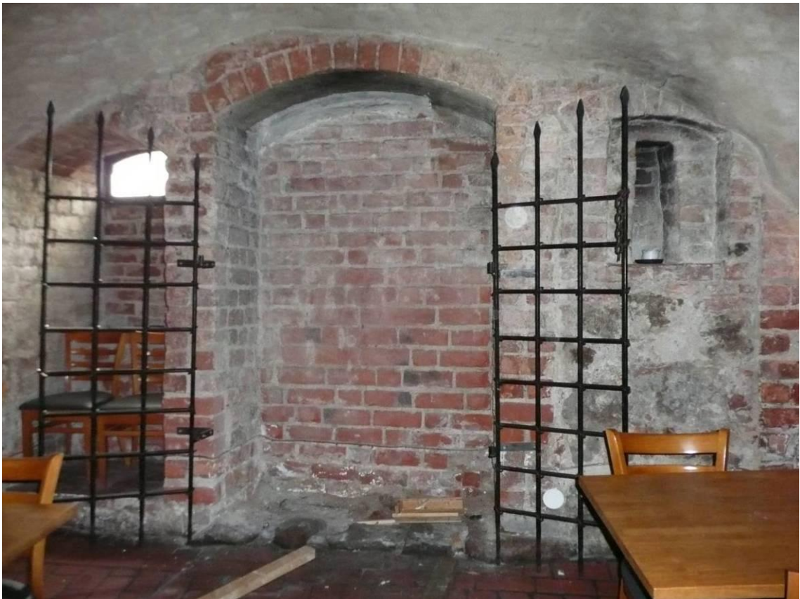
Figur 37. Servering övre källaren. Det gamla aggregatet har tagits ner.
