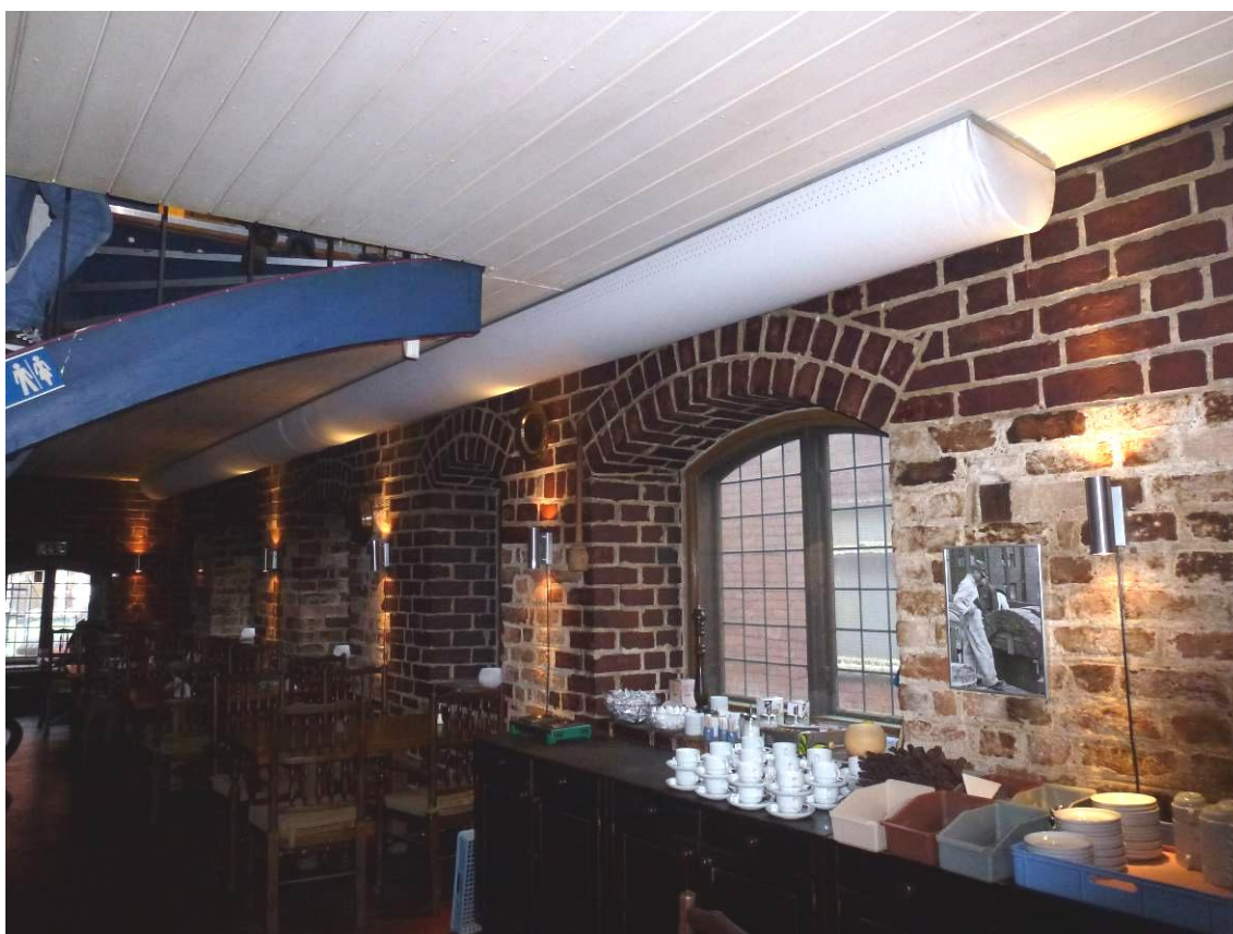
Figur 35. Efter åtgärder. Matsalen på plan 2. Ny textilstrumpa i takvinkeln..
