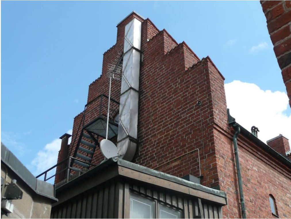
Figur 3. Före åtgärder västra gavelfasaden, gårdssidan.
