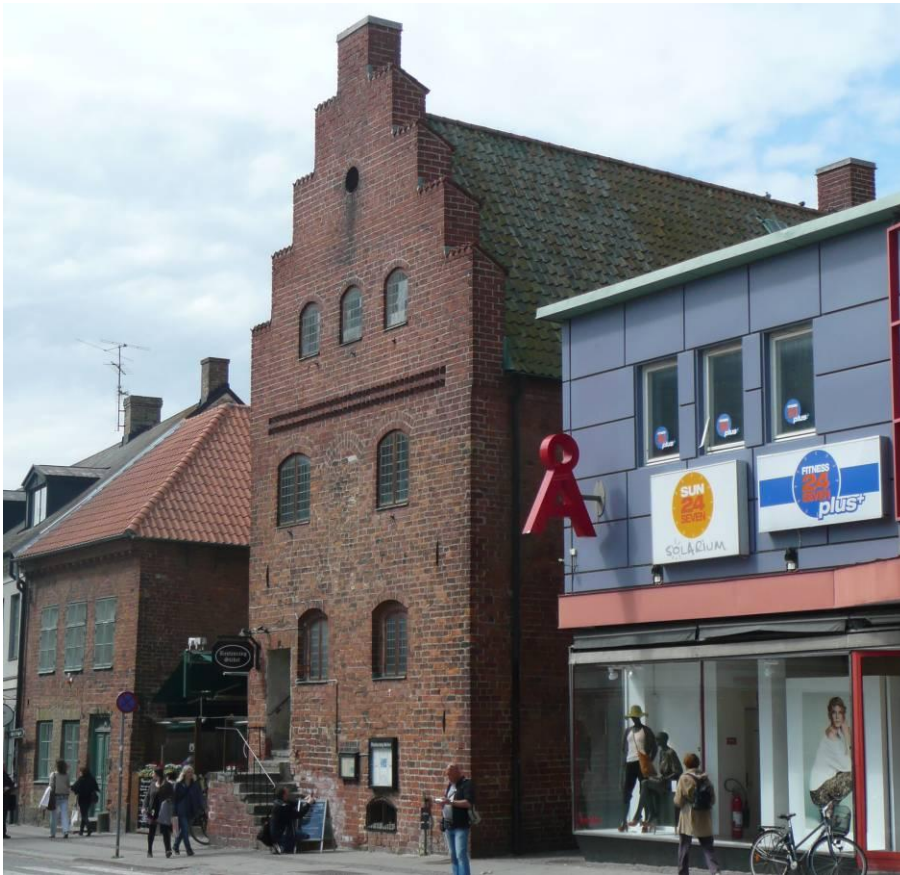
Figur 1. Före åtgärder vy från nordost.
