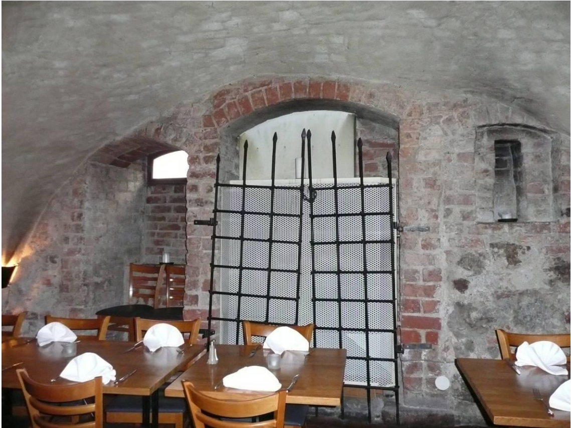
Figur 36. Före åtgärder. Servering övre källaren. Östra gaveln, nisch med ventilationsaggregat.
