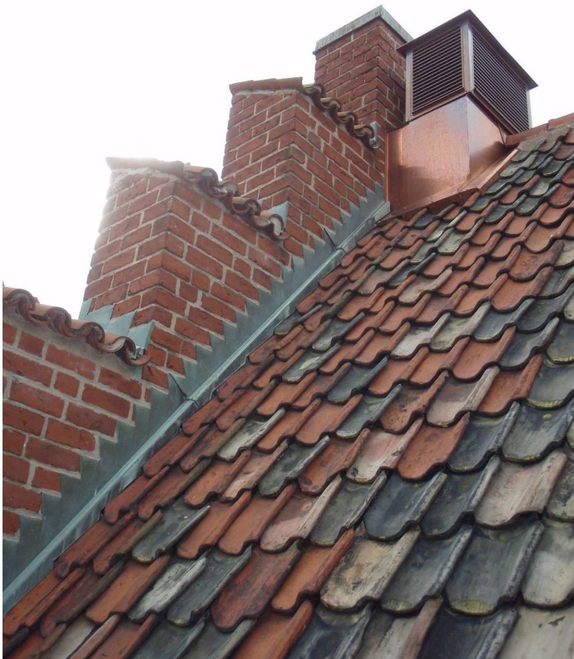
Figur 15. Efter åtgärder, norra takfallet vy mot öster. Tvättat och återplacerat taktegel, omfogningar i murverket och ny kopparinklädd ventilationskanal.
