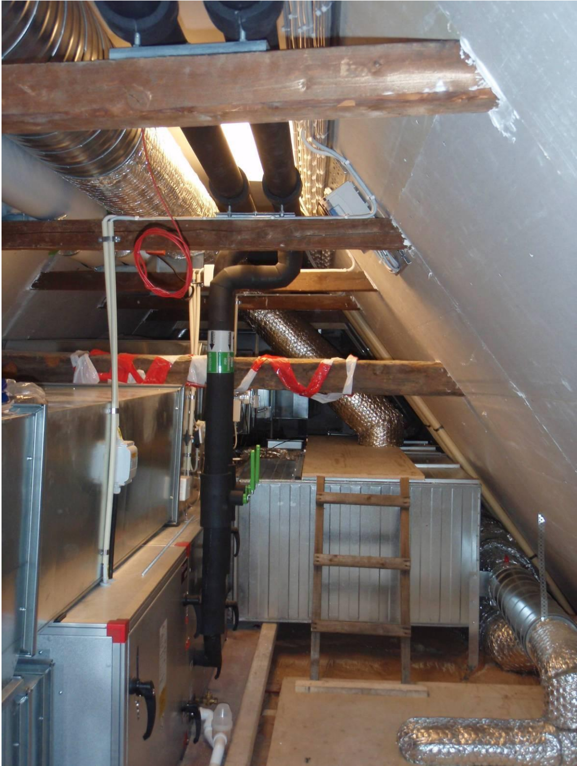
Figur 26. Efter åtgärder. Vinden ry mot väster. De nya aggregaten är anpassade efter den äldre takstolens hanband, vilket är markerat med plastband, övriga hanband flyttades upp 300 mm.
