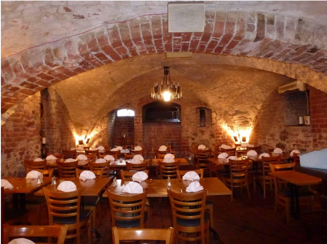
Figur 39. Efter åtgärder. Servering i övre källaren. Nytt ventilationsaggregat i väggnischen.
