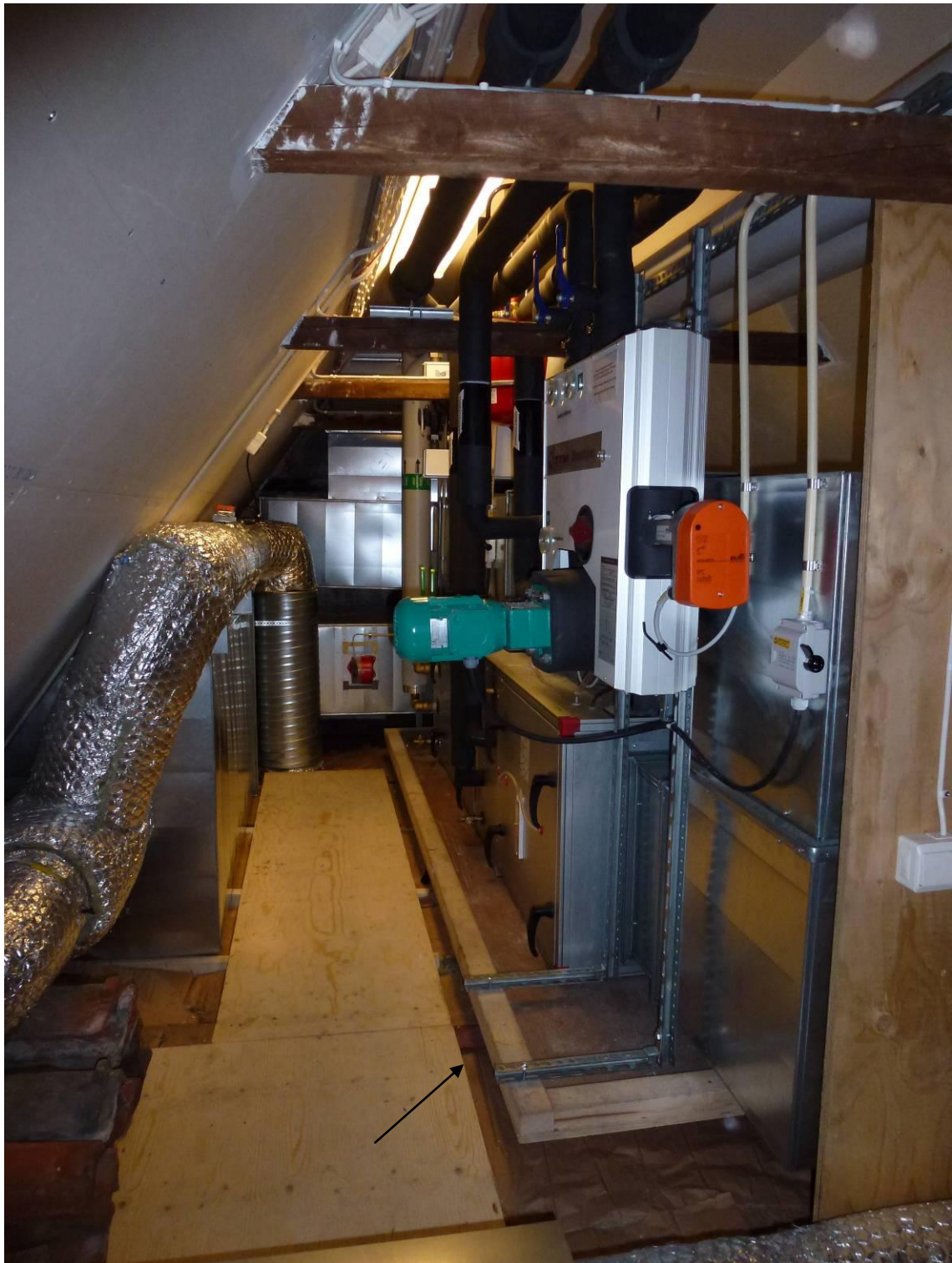
Figur 25. Efter åtgärder. Vinden vy mot öster. Aggregaten vilar på aggregatstativ som i sin tur vilar på de nya röda stålbalkarna (pil). Hanbanden från 1950-talet är synliga. Isolering med gips-skivor i taket. På vinden förvaras vingpannetegel och nockpanna i reserv (till vänster i bild).
