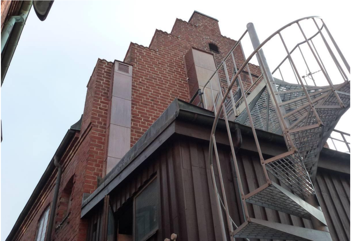
Figur 19. Efter åtgärder. Västra gavelfasaden. Nya plåtinklädda kanaler.
