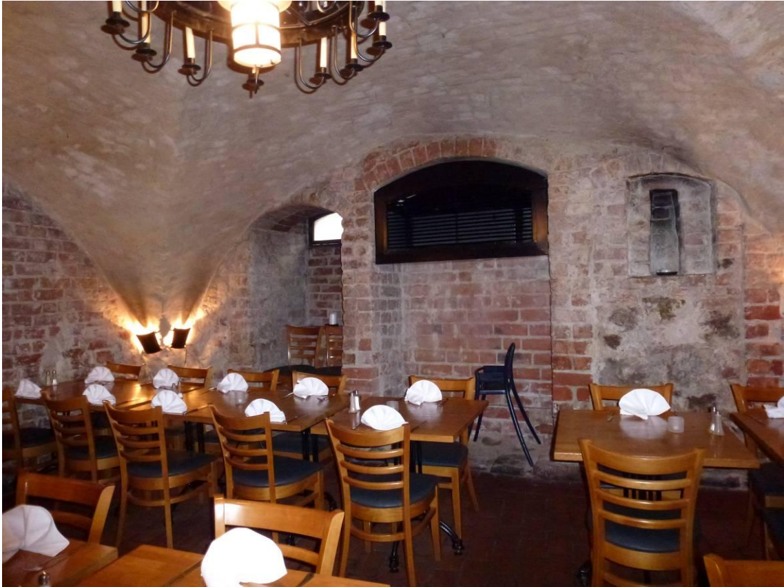
Figur 38. Efter åtgärder. Servering i övre källaren. Nytt ventilationsaggregat i väggnischen.
