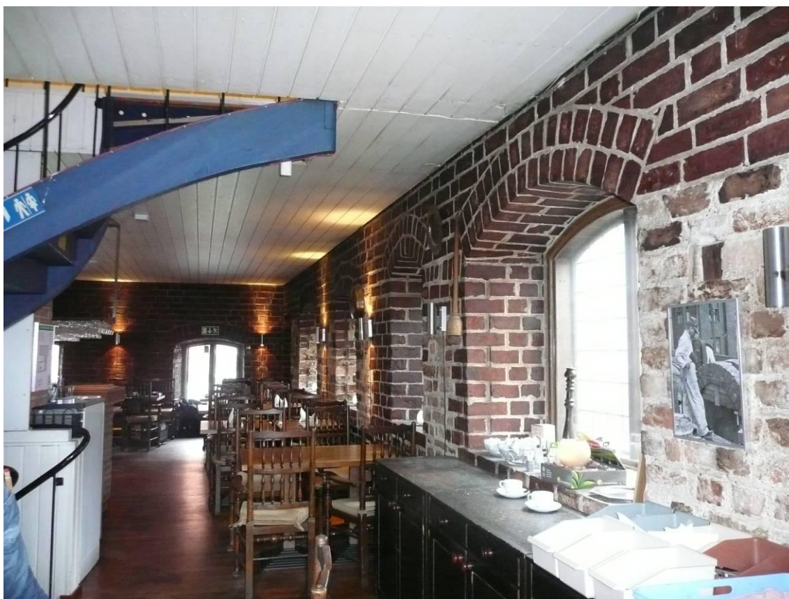
Figur 34. Före åtgärder. Matsalen på plan 2. Norra väggen vy mot väster.
