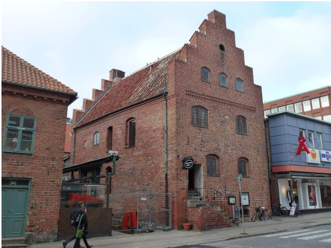
Figur 18. Efter åtgärder, vy från sydost.
