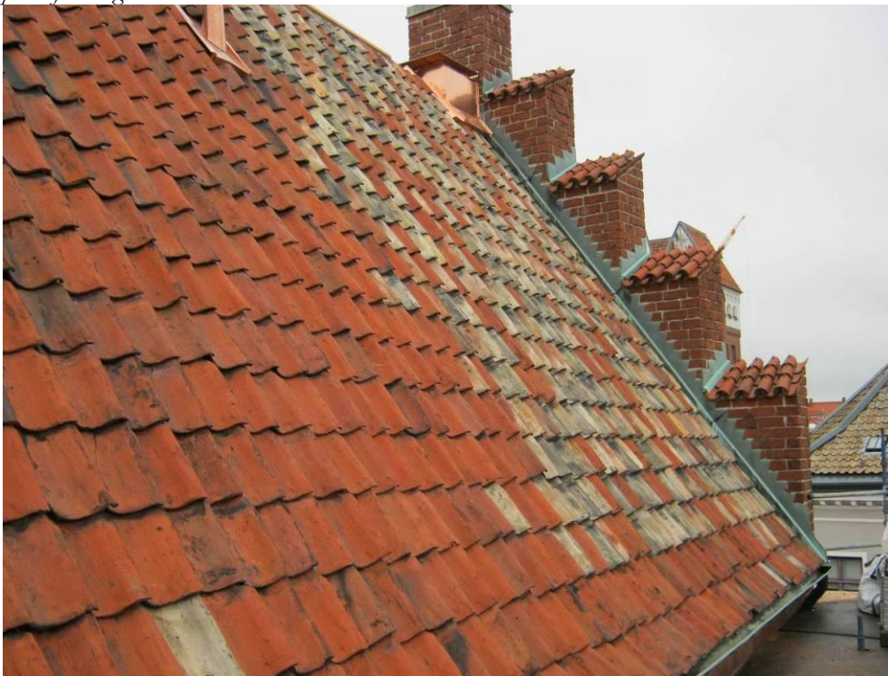
Figur 14. Efter åtgärder, södra takfallet vy mot öster. Den översta delen av kanalen i nock saknas ännu (se figur 15).
