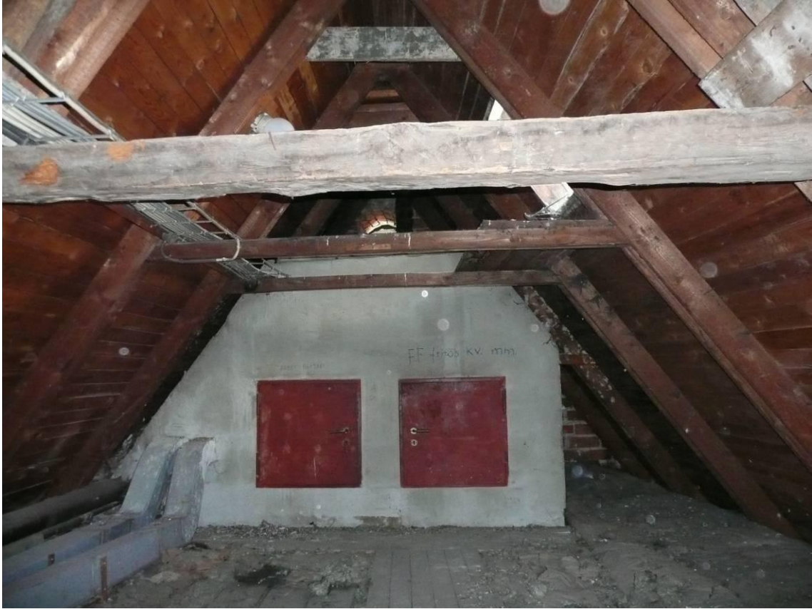
Figur 21. Före åtgärder, vinden vy mot väster. Fläktkammaren i fonden och hanbandet till den äldre takstolen i förgrunden. Golvet är isolerat och täckt med spång av brädor.
