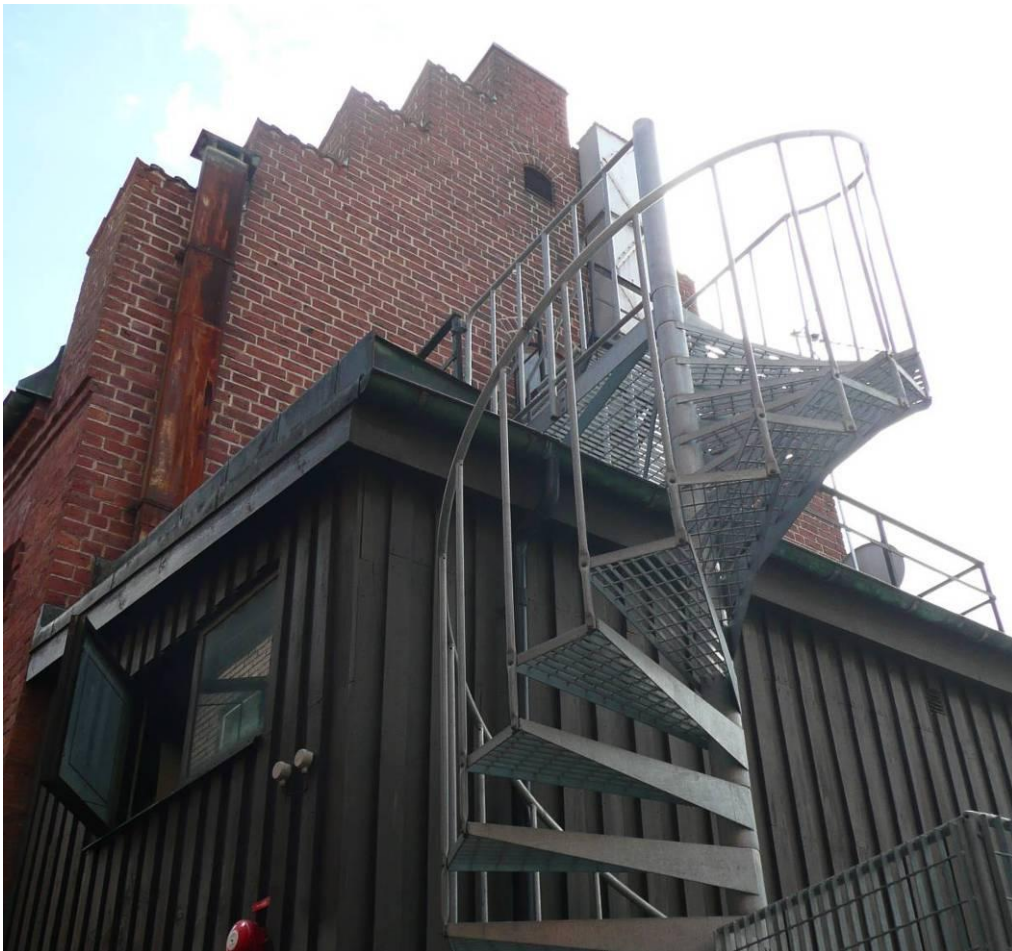
Figur 4. Före åtgärder västra gavelfasaden.
