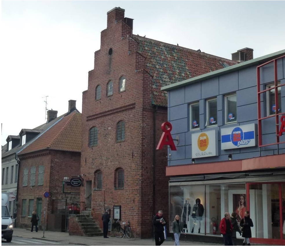
Figur 17. Efter åtgärder vy från nordost.
