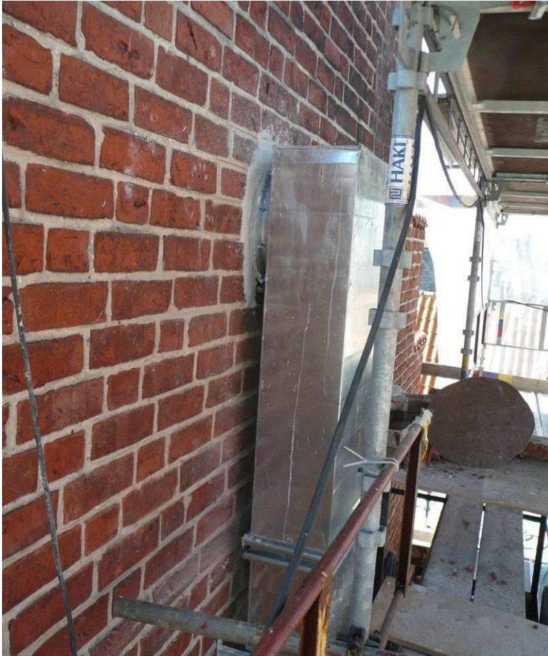
Figur 16. Nyupptaget hål i västra trappsteggaveln för imkanalen som i färdigt utförande klätts med koppjarplåt. Omfogningar med ritsad planfog.
