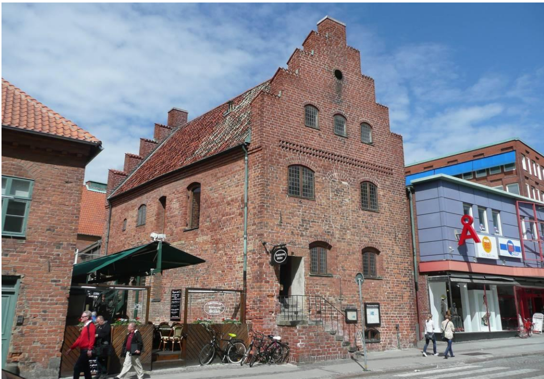
Figur 2. Före åtgärder, vy från sydöst.
