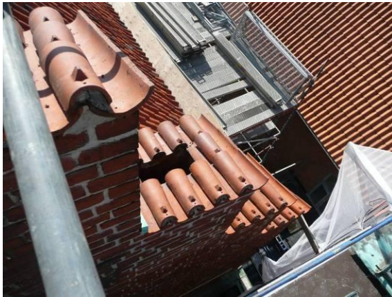
Figur 6. Ovan: Öppen murverkskanal i trappstegsgaveln. Figur 7. Till höger: Igensatt öppning och fästa tegelpannor. Plåten mot trappstegsgaveln har inte monterats ännu. Figur 8-9. Nedan: Nockbrädan var kraftigt rötskadad. Tegelstämplar på befintligt tegel.
