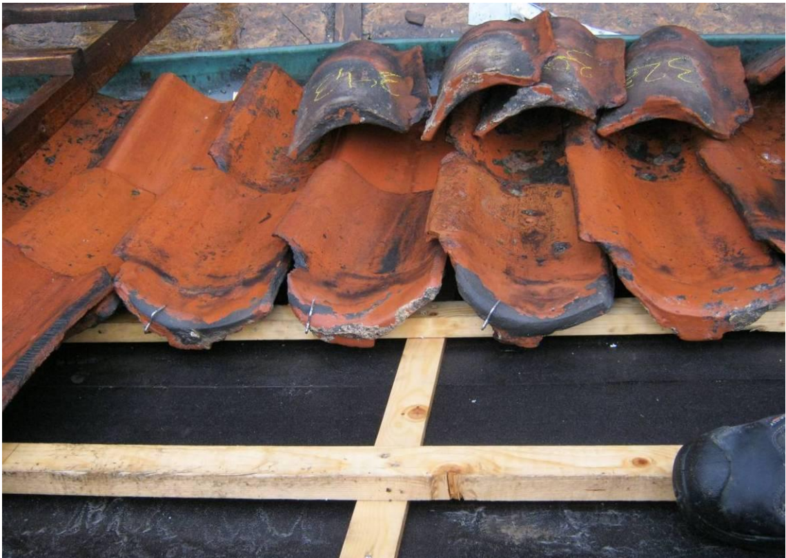
Figur 11. Under återmontering. Takpannorna numrerades för smidig återplacering. De flesta takpannorna fästes med takpannekrok. Ny papp, bär- och ströläkt.
