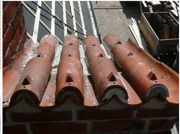
Figur 6. Ovan: Öppen murverkskanal i trappstegsgaveln. Figur 7. Till höger: Igensatt öppning och fästa tegelpannor. Plåten mot trappstegsgaveln har inte monterats ännu. Figur 8-9. Nedan: Nockbrädan var kraftigt rötskadad. Tegelstämplar på befintligt tegel.
