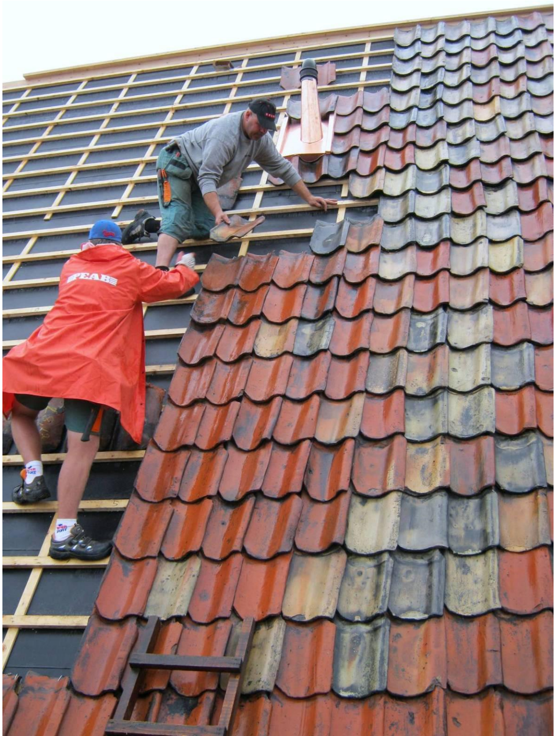
Figur 12. Ny nockbräda, tegelpannorna återmonteras på södra takfallet, tegelpannorna är tvättade med vatten och borste. De tre luftningsrören har ersatts med ett.
