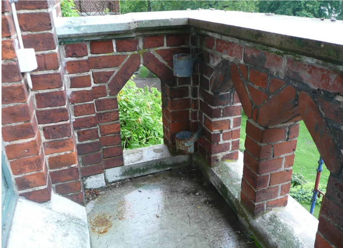
Figur 7. Detalj, före åtgärder. I kalkstenen på räcket syns förskjutning av stenen. I hörnet finns hållare i järn för julgranar.
