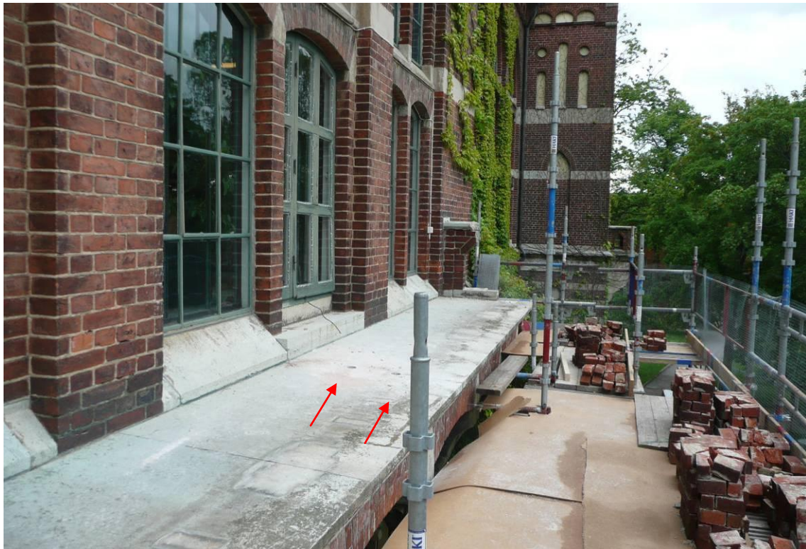
Figur 10. Under arbetet. Räckets och kalkstenen under räckets har demonterats, balkongplattan med kalksten är frilagd. Pilarna visar hål för gängstänger till skulpturen under balkongplattan.
