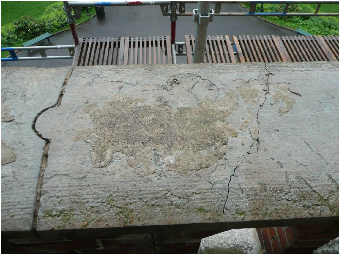
Figur 16. Kalkstensplatta på räcket. Gamla lagningar, spricka i stenen och springa mellan stenarna.
