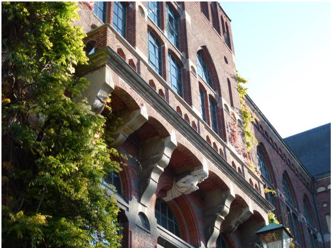
Figur 4. Efter åtgärderna. Plåtkanten vid balkongplattan är knappt skönjbar. Observera skulpturen under balkongen.
