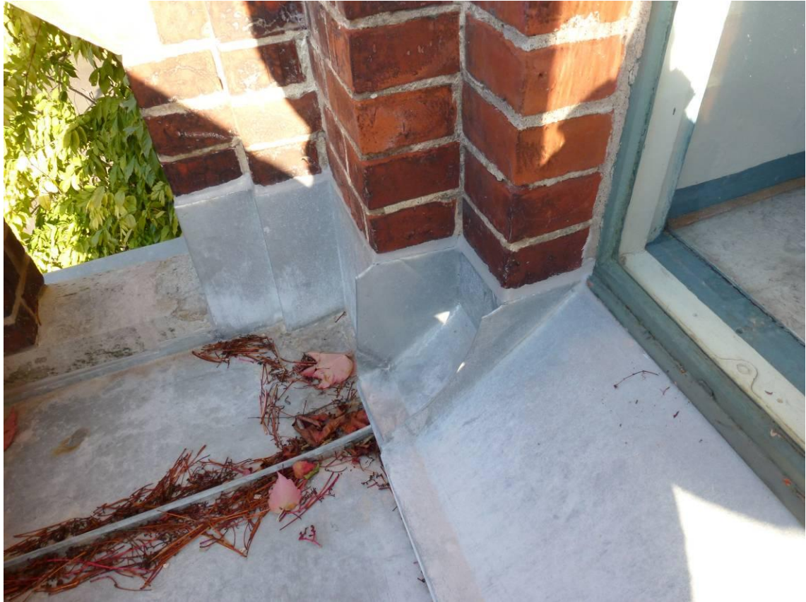
Figur 18. Efter åtgärder. Plåten är tätad med grå fogmassa i fogen mot fasaden.
