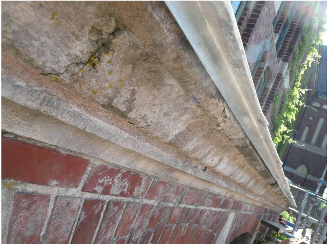
Figur 19. Efter åtgärder. Droppkant i plåten under balkongplattan. I frisen finns sprickor.
