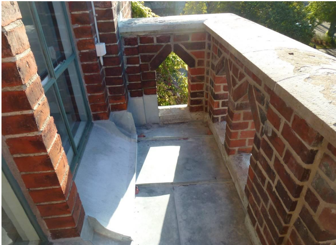
Figur 8. Efter åtgärderna. Ommurat räcke, plåt på balkongplattan samt upp på fasaden till nivå under fönstren tätad med mjukfog.
