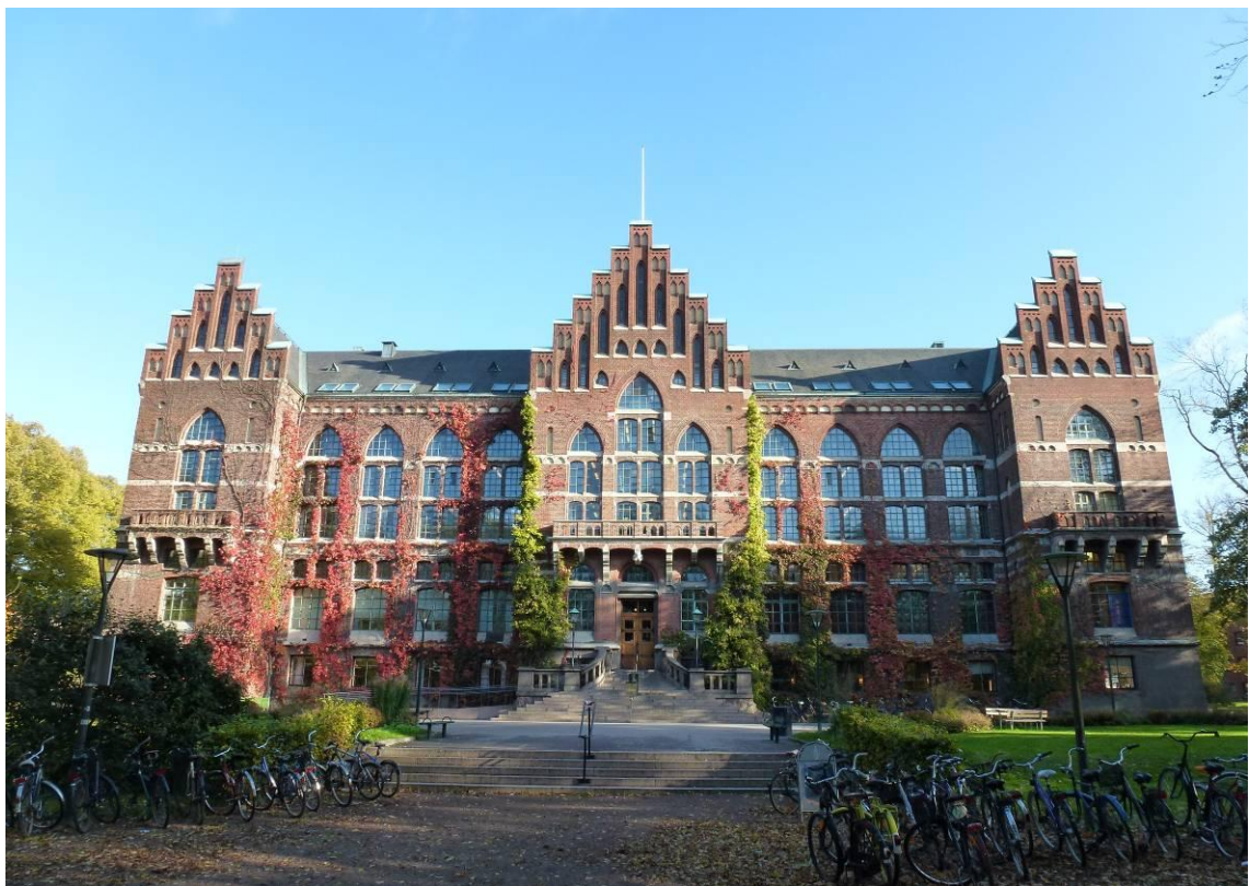
Figur 2. Vy från söder efter åtgärderna.
