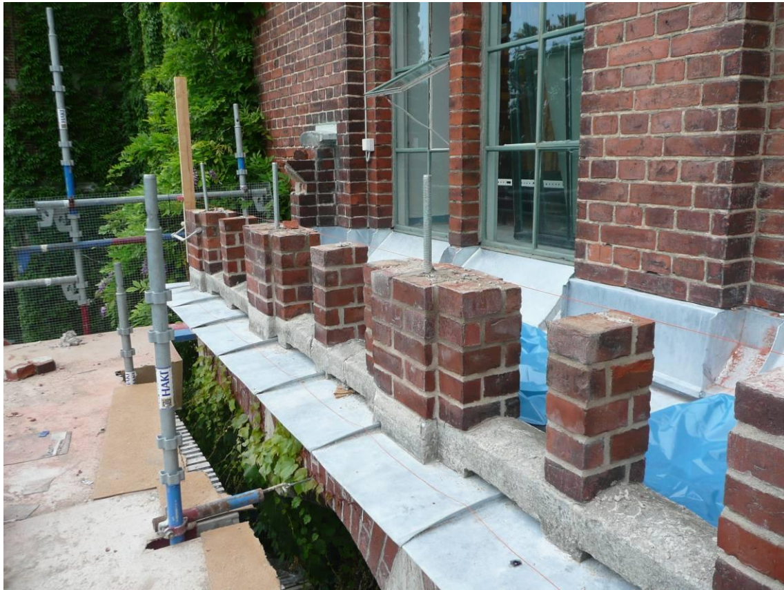
Figur 12. Återuppmurning av räcket pågår med ett inmurat rostfritt armeringsjärn i varje räckespelare.
