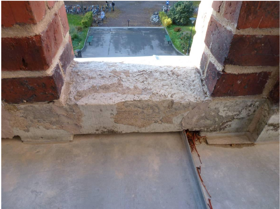
Figur 20. Efter åtgärder. Balkongplattan är klädd med plåt. Kalkstenen i räcket är rengjord av konservator.
