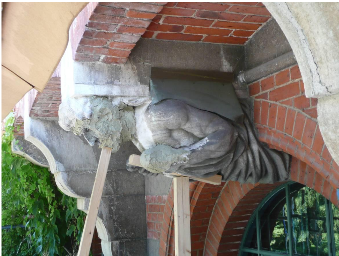
Figur 14. Skulpturen under konservering och tillfälliga stabiliserande reglar under gångstängerna.
