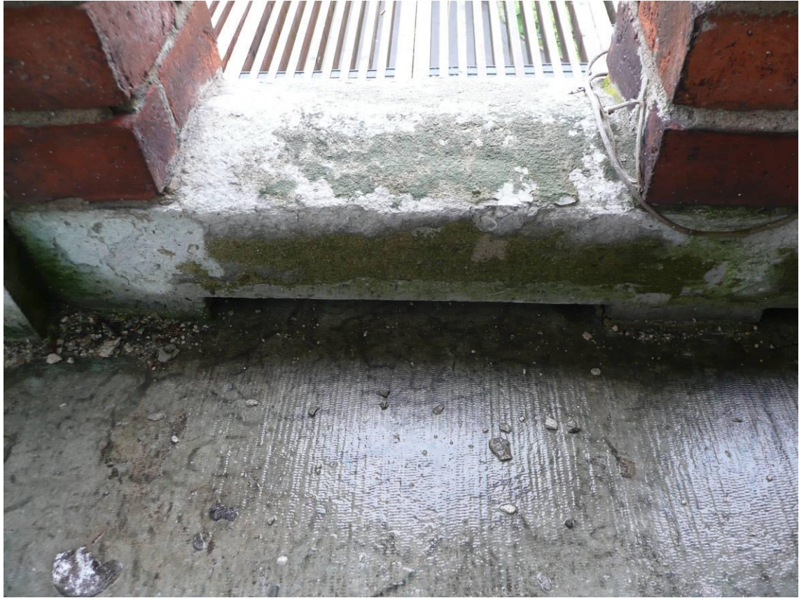
Figur 19. Före åtgärder. Behuggen kalkstensplatta på balkongen.
