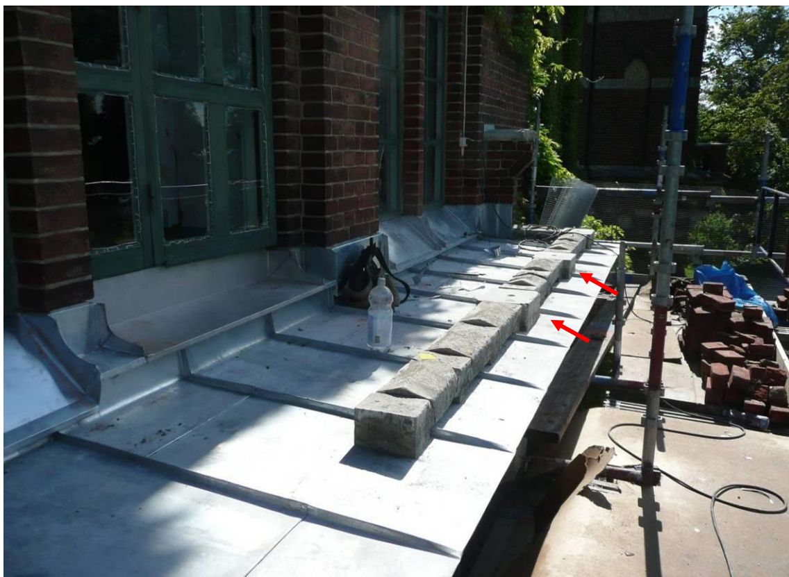
Figur 11. Skivtäckning med falsad zinkplåt. Plåtkanten är infräst i fogen i fasaden och formad efter kalkstenen intill fasaden och trappsteget vid dörren. Kalkstenen under räckets är återmonterad och hål har borrats för armeringsjärn (pil).
