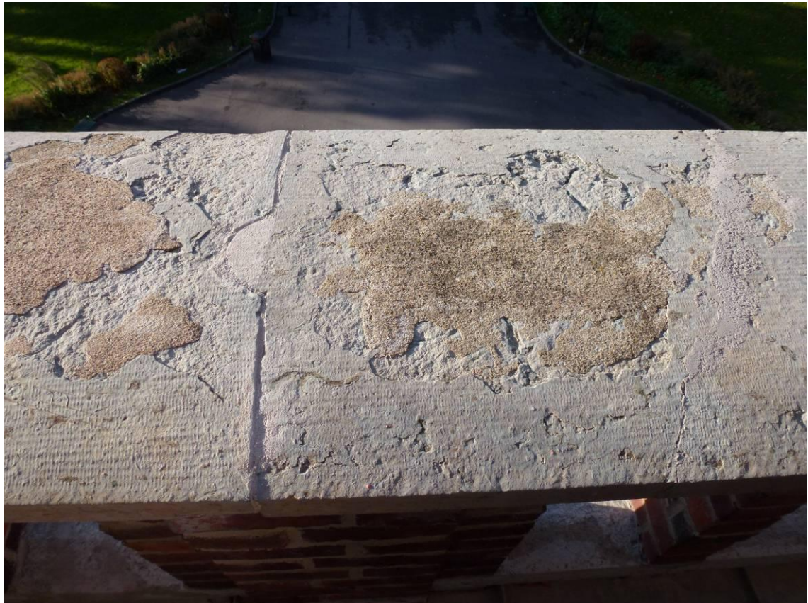
Figur 17. Kalkstensplatta på räcket efter konservering och tätning.
