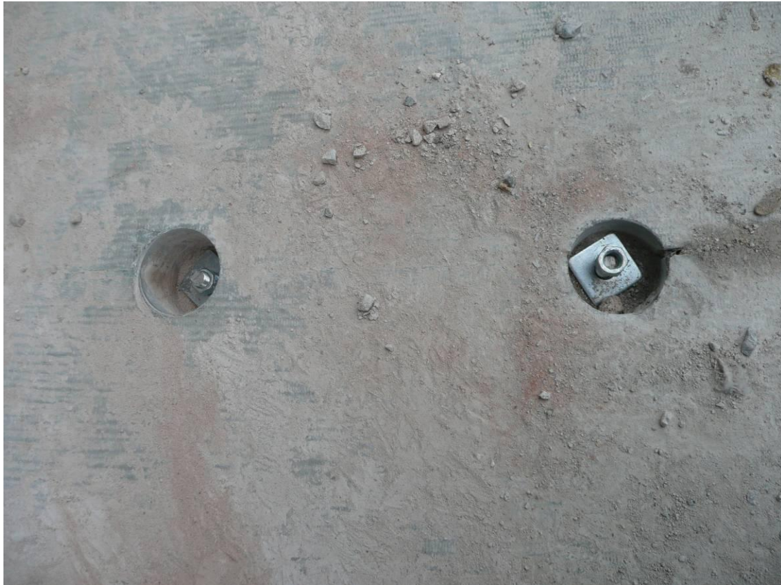
Figur 13. Gängstänger i kalkstensplattan på balkongplattan. Stängerna går ner genom skulpturen.
