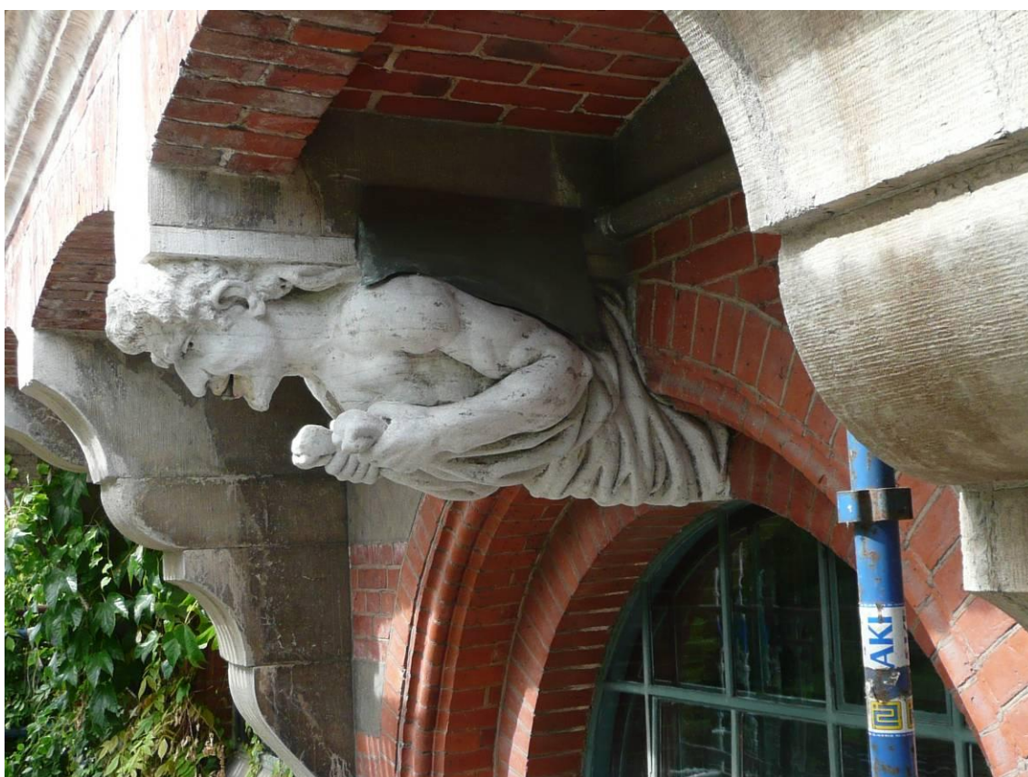
Figur 15. Skulpturen efter konservering. Lagning av konsolen är utförd.
