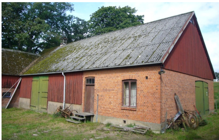
Norra längan södra gårdsfasaden och östra gavelfasaden.
