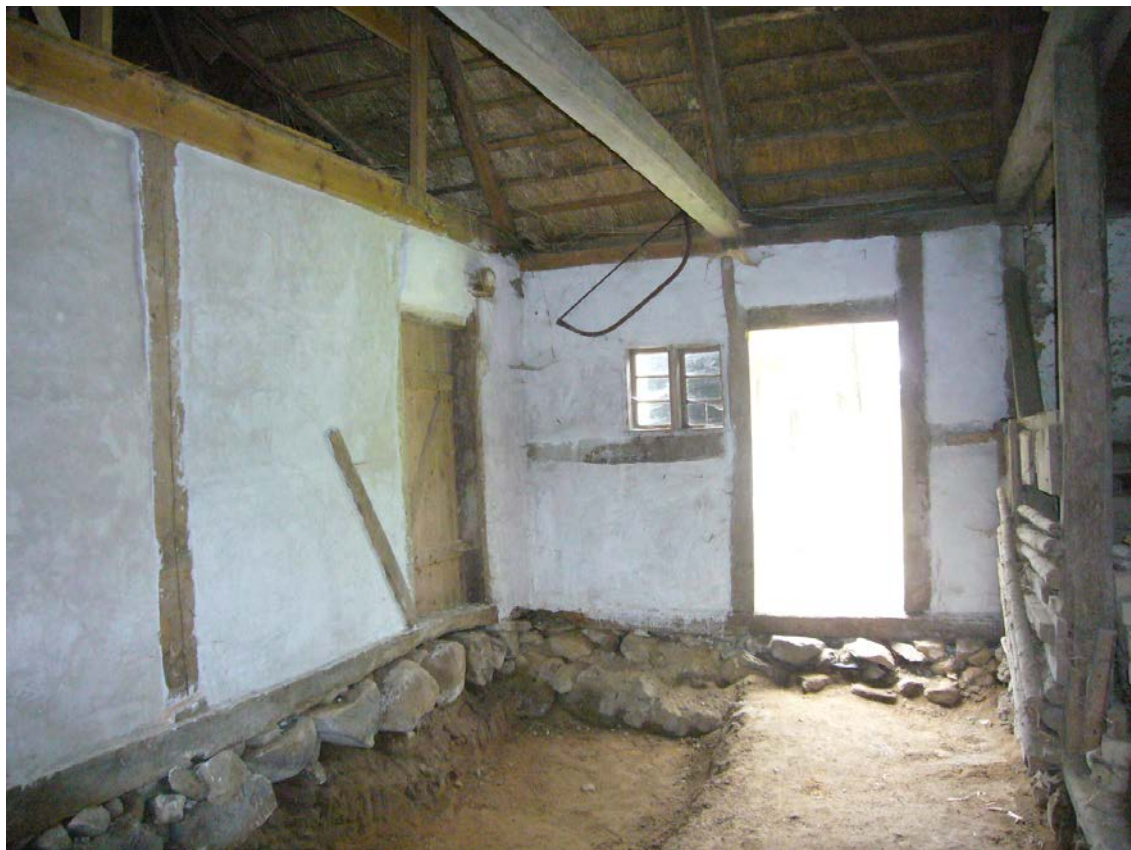
Figur 39. Rum 23 loggolv. Sanden i golvet är delvis urgrävt på grund av äkta hussvamp som fanns i löst liggande virke samt mycel i sanden. Pilen pekar på kraftigt rötskadat fotträ, se även utvändiga skador. Det föreligger risk att mycel finns kvar i väggen. Vy mot väster och infart till gården.
