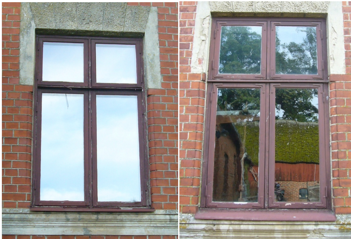
Nyare fönster och ursprungligt fönster.
