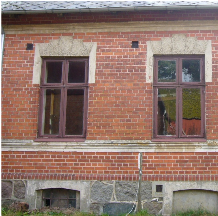
Västra fasaden, vittrade omfattningar på de norra fönstren, vittrad profilerad putslist. Trasigt glas i gjutjärnsfönster i sockeln och marken ligger nära an emot byggnaden.
