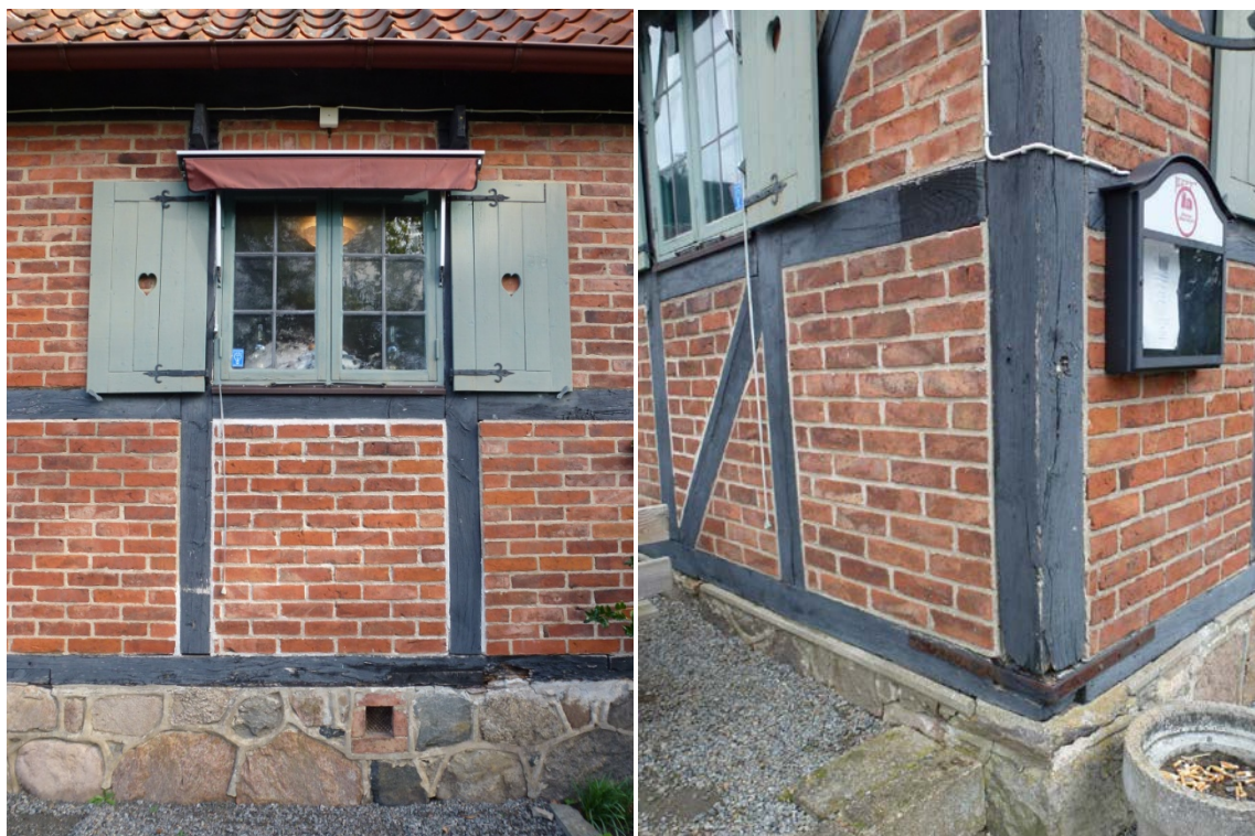
Södra fasaden, rötskadat fotträ, fog mellan fotträ och grund till höger i bild ökar risk för rötskador på fotträ. Springor mellan fönster och stolpar gör inomhusklimatet dragigt. Sydvästra hörnet är sammanfogat med järn, fotträet är rötskadat.
