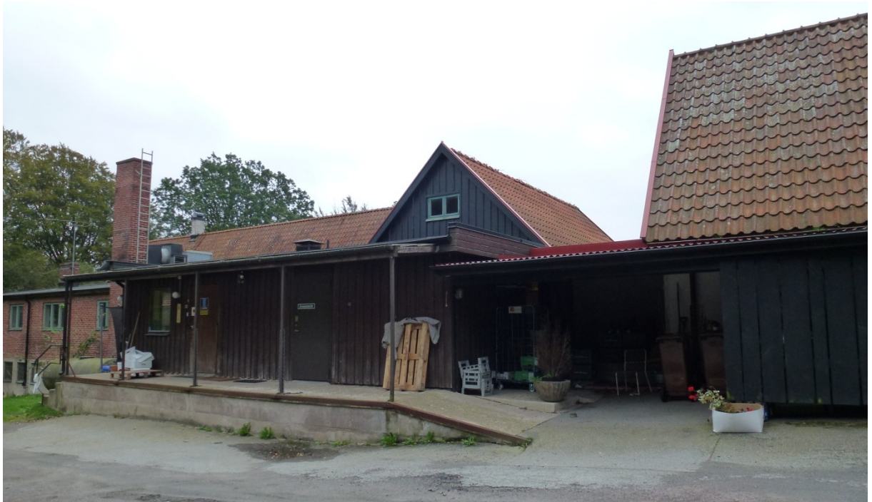
Vy från norr, nybyggnaden mitt i bild.
