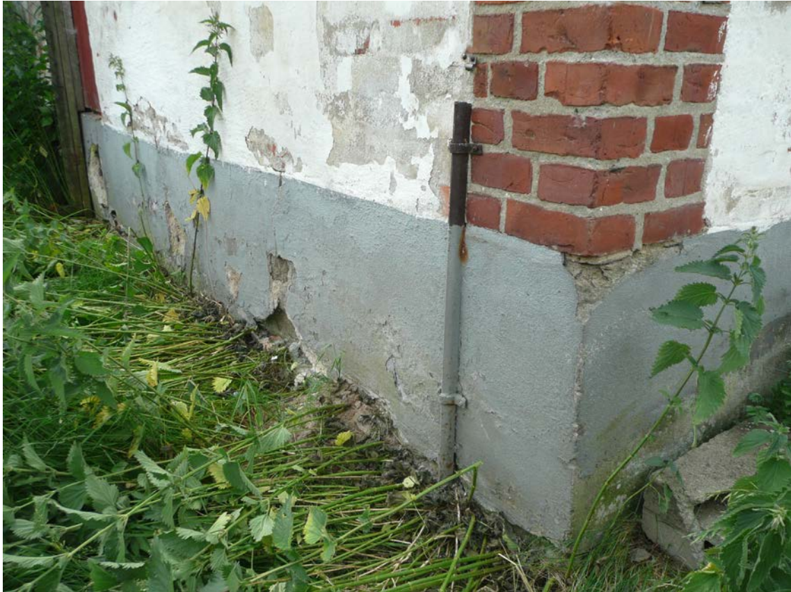
Skador på sockeln, nordöstra hörnet.
