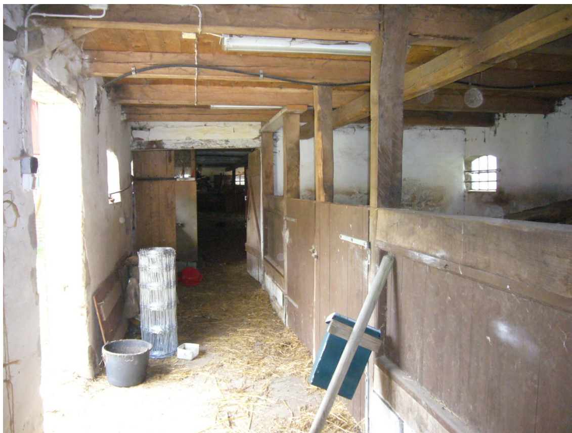
Västra längan, vy från norr.
