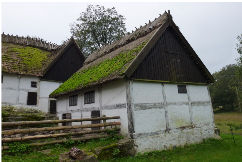
Figur 22. Östra och norra gavelfasaden.
