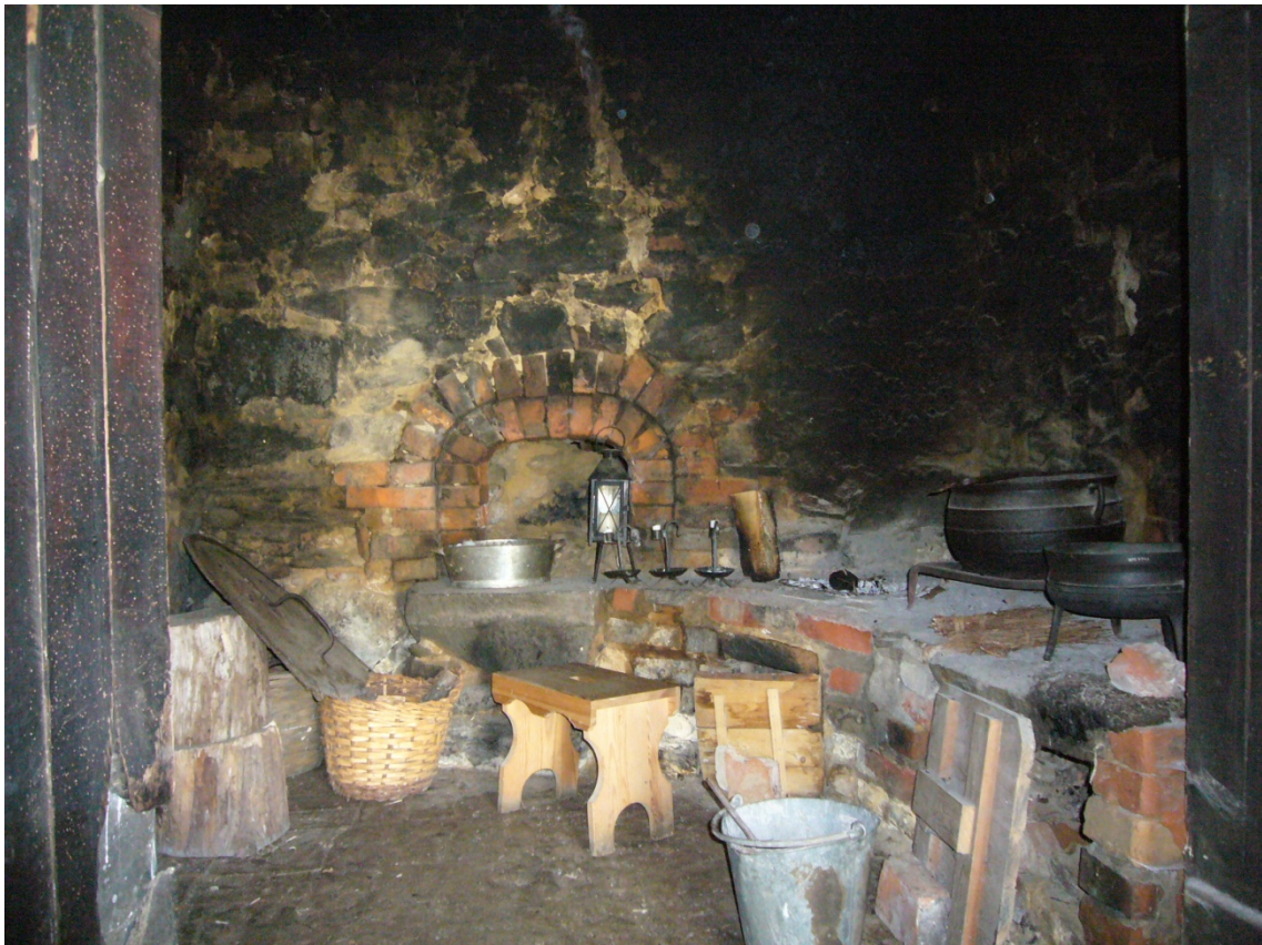
Figur 28. Spisen (rum 3) till höger i bild och bakugnen (rum 4) rakt fram. Inne i bakugnen har delar ramlat ner.
