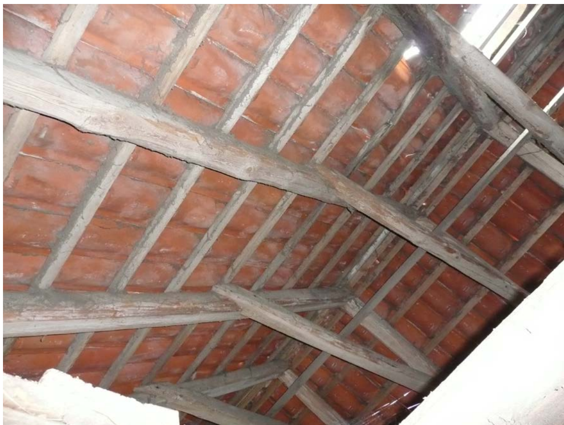
Takpannor på öppen läkt.
