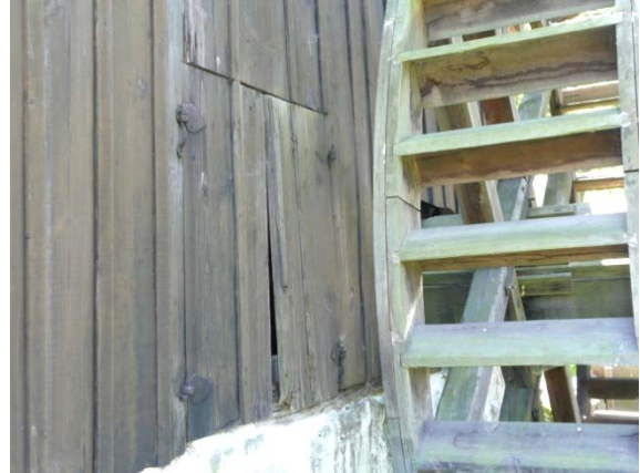
Putsbruk emot löshult och fotträ orsakar rötskador i korsvirket. Lucka på västra fasaden med plattgångjärn, vattenhjulet har något grön påväxt.
