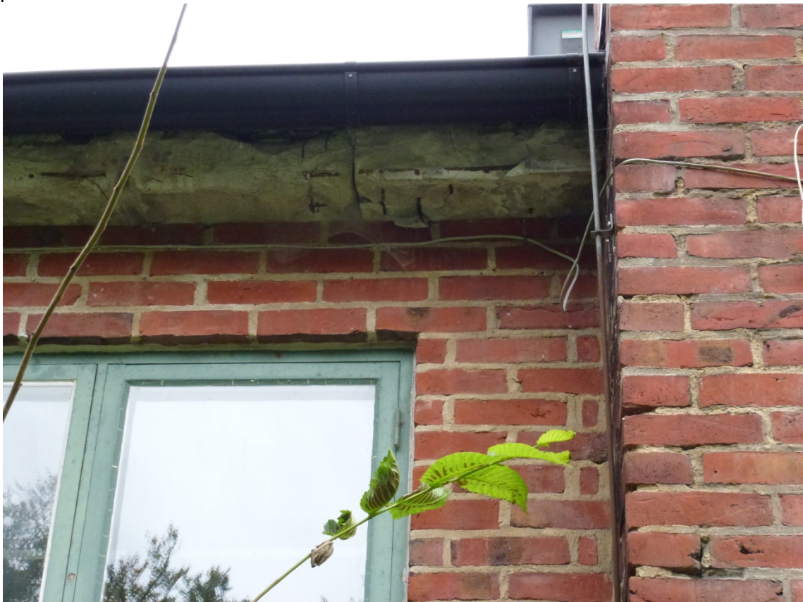
I norr, skadad takfot med synliga armeringsjärn, vittrad fog på den höga murade skorstenen till höger i bild.
