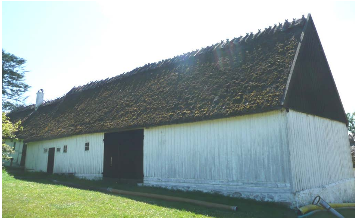
Figur 17. Logen östra fasaden och norra gavelfasaden.
