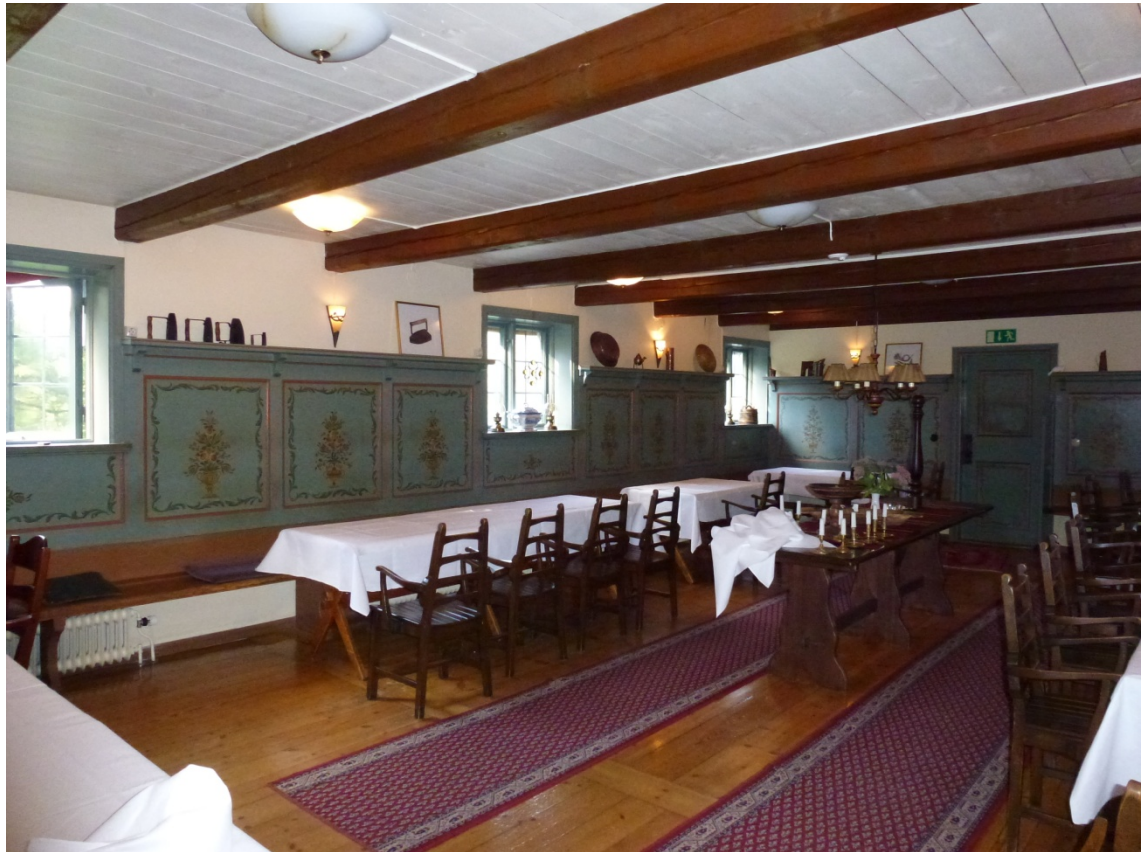
Matsalen. Fönstren är dragiga.
