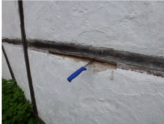
Putsbruk emot löshult och fotträ orsakar rötskador i korsvirket. Lucka på västra fasaden med plattgångjärn, vattenhjulet har något grön påväxt.
