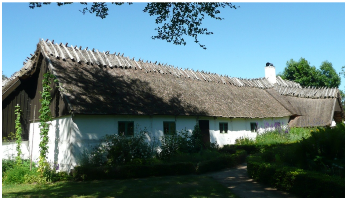
Figur 3. Vy från sydväst, södra fasaden.
