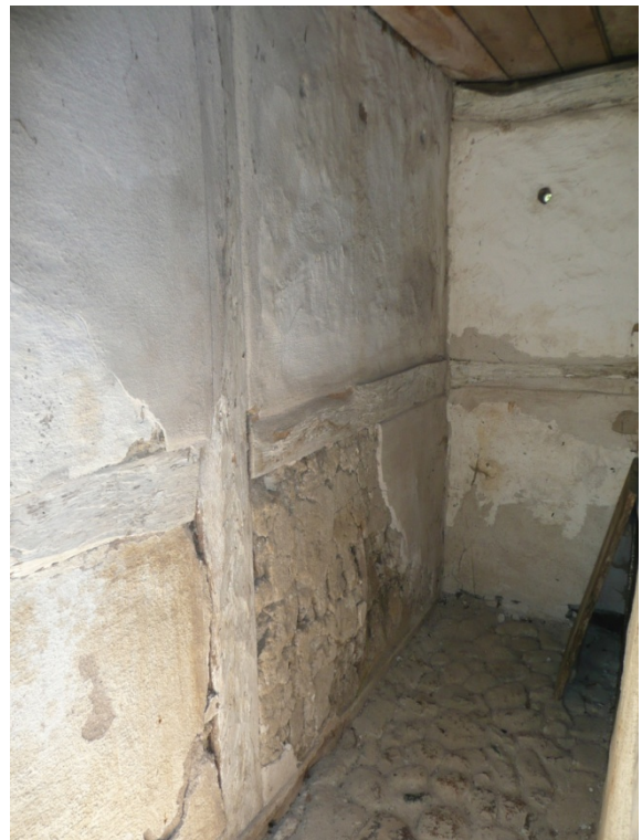
Lerklinad innervägg med putsbortfall.
