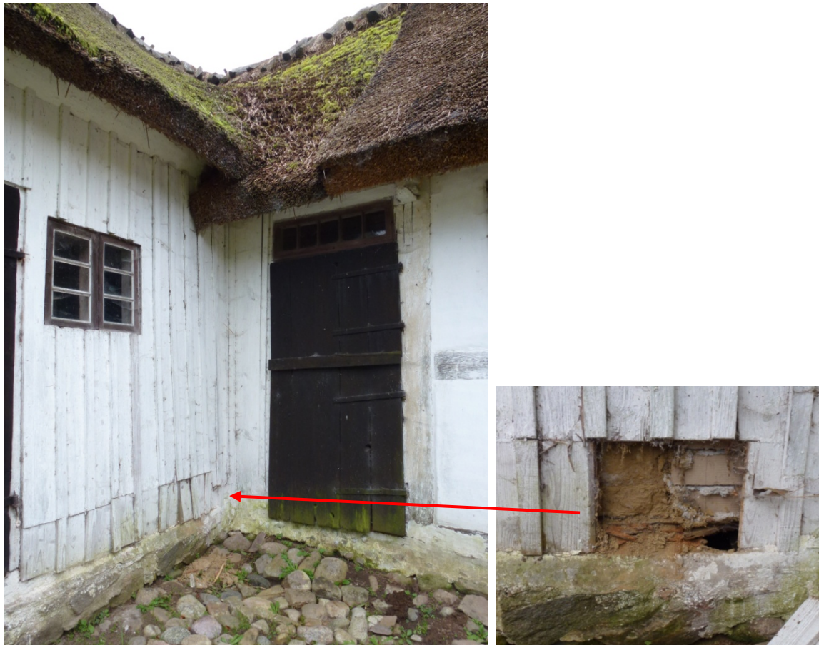
Figur 16. Sydvästra hörnet av logen. Fotträet är bortrotat, fasadpanelen är skarvad och det föreligger risk att det finns mycel av hussvamp i väggen. I bild även norra längans häststaldörr.
