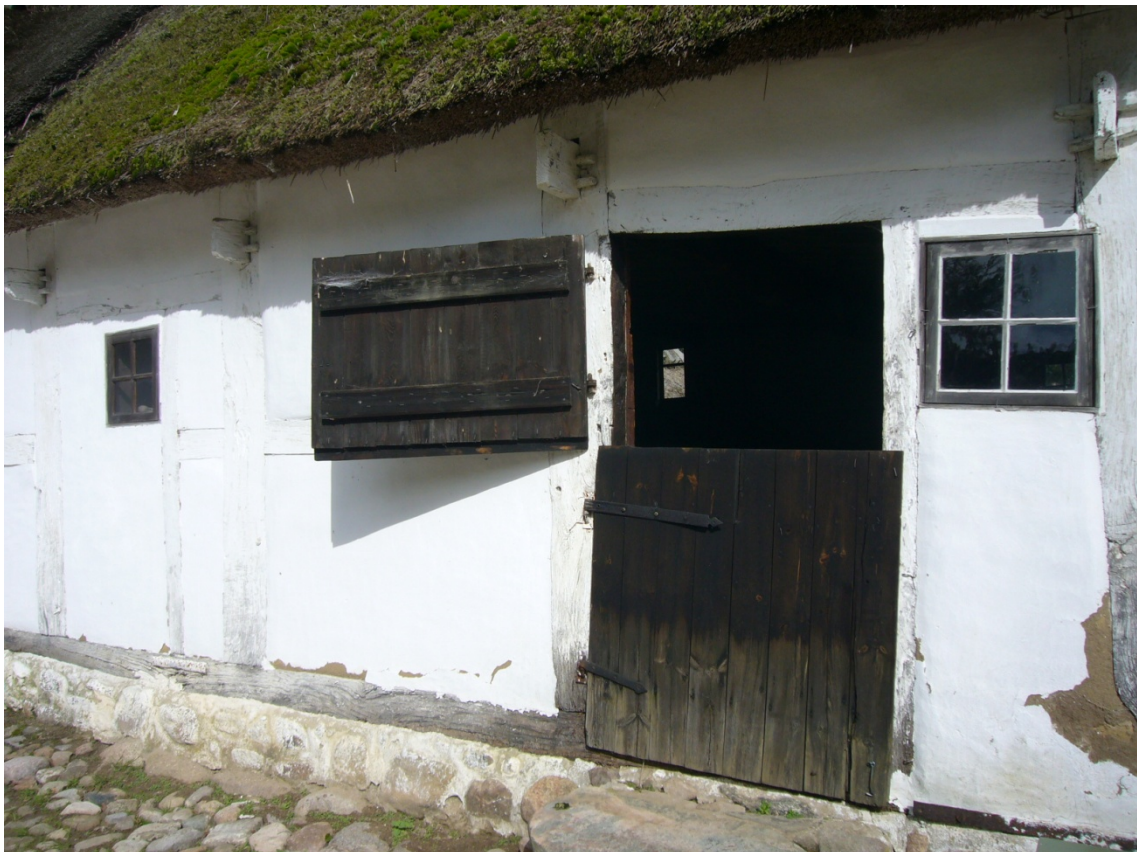
Figur 11. Dörr till kostallet, södra gårdsfasaden, med maskintillverkat bandgångjärn upptill fäst med stjärnskruv och nertill smitt bandgångjärn. Till höger i bild putsskador och kittat fönster, till vänster i bild nyare spårfalsfönster. Olika utformning av stickbjälkarna.
