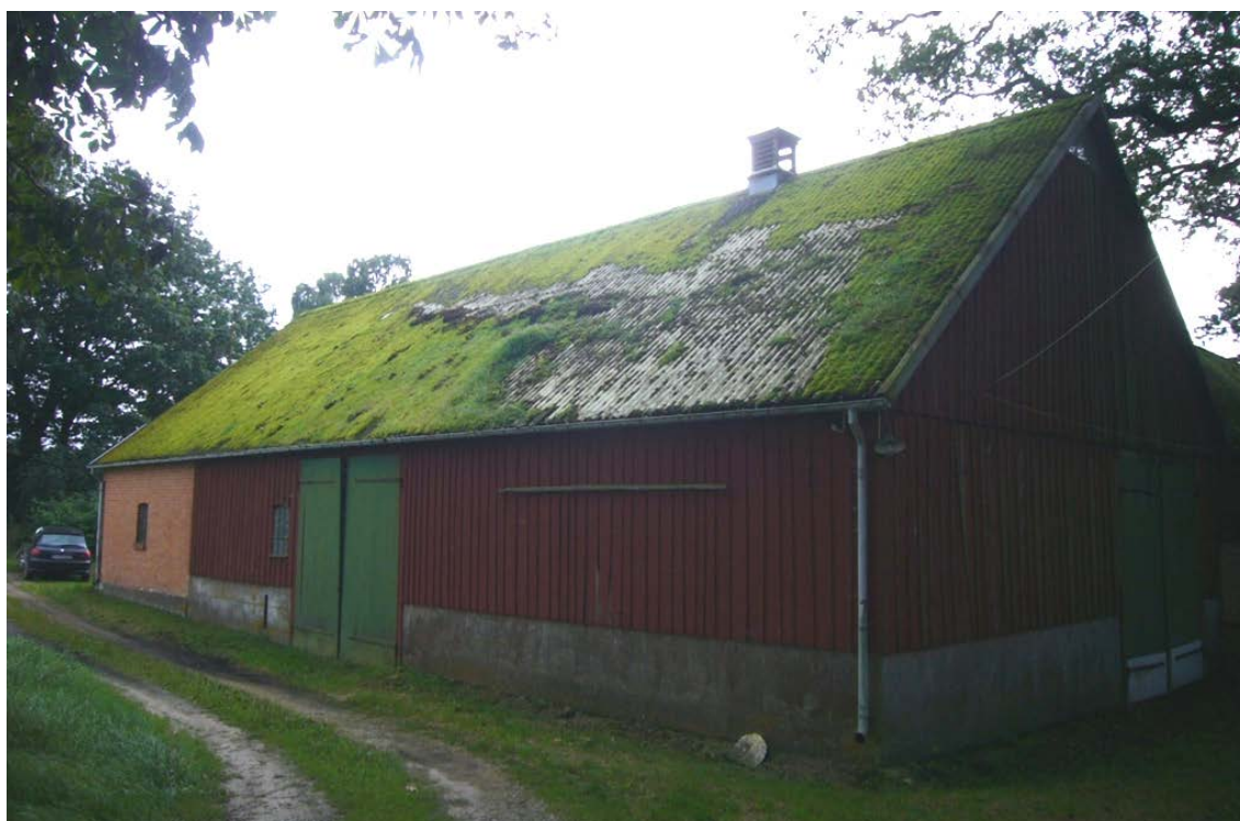
Nora fasaden och västra gavelfasaden. Kraftig mosspåväxt på taket. Intill fasaden finns en gjuten vattenränna, det är viktigt att rensa denna varje höst så att inte regnvatten tränger in i logen eller att rännan fryser med löv i.
