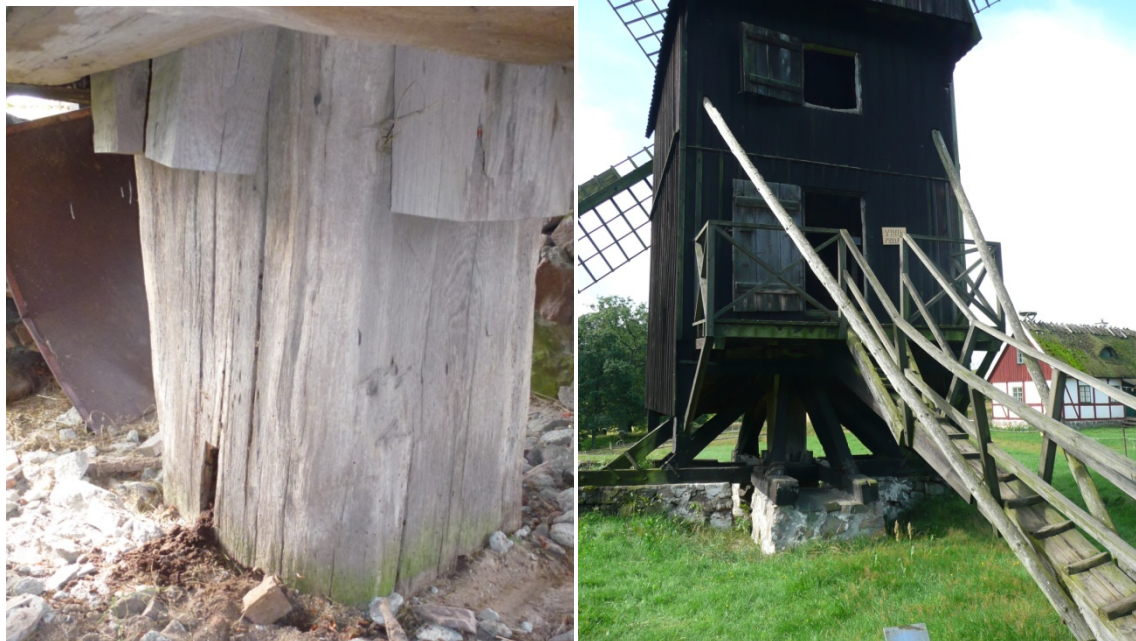
Stubben är kraftigt rötskadad.
