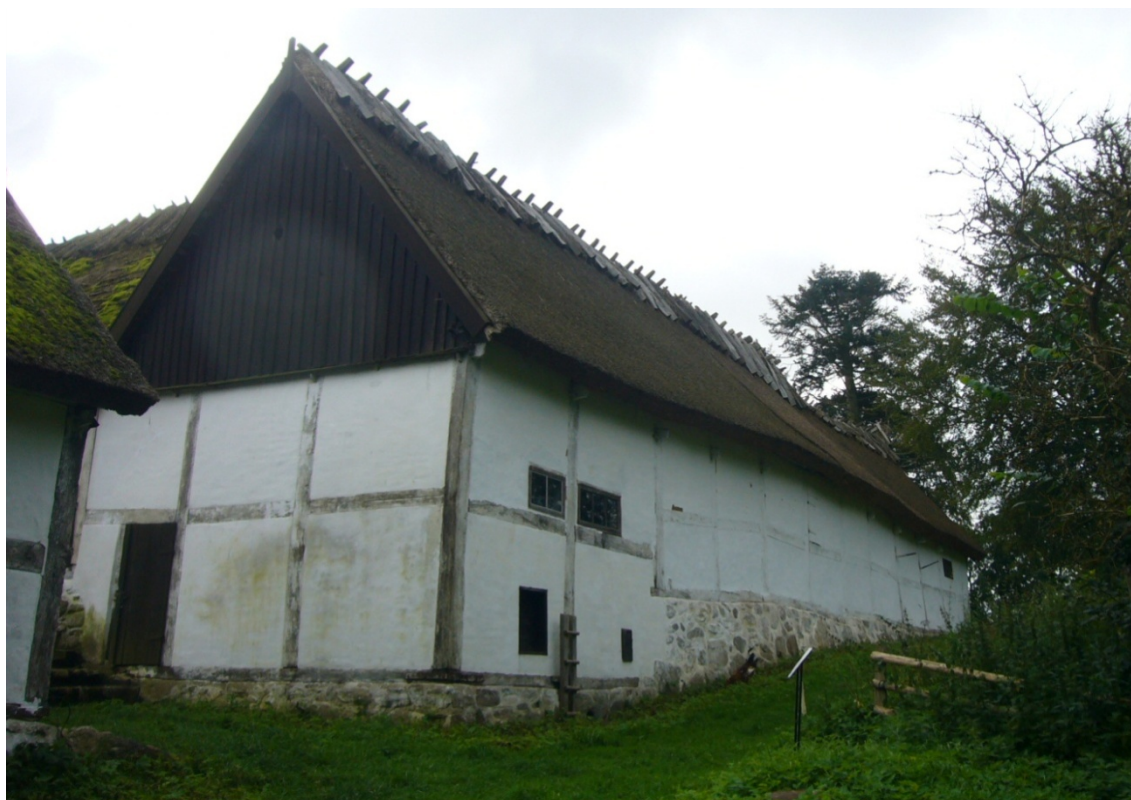
Figur 5. Vy från nordväst, västra fasaden och norra gavelfasaden.
