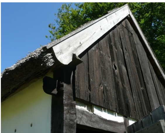
Ovan: profilerad stickbjälke, rötskadat vabord. Till höger: i dörröppningen ser man mötet mellan fotträna och stolpen, springa mellan och stolpe.
