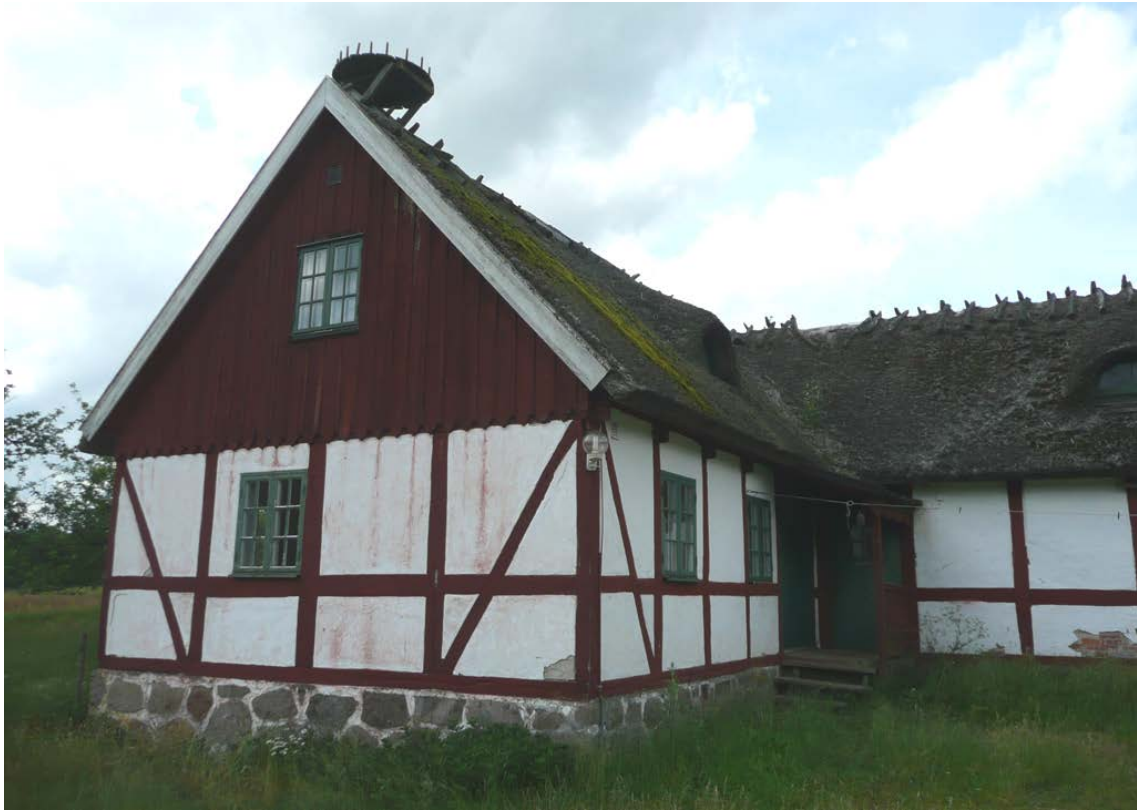
Figur 44. Norra fasaden vid entrén och östra gavelfasaden.
