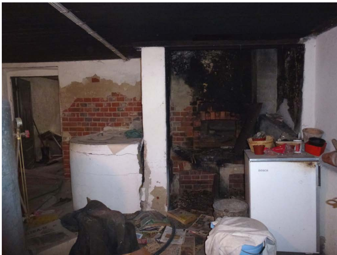
Bak och tvättstugan i källaren.
