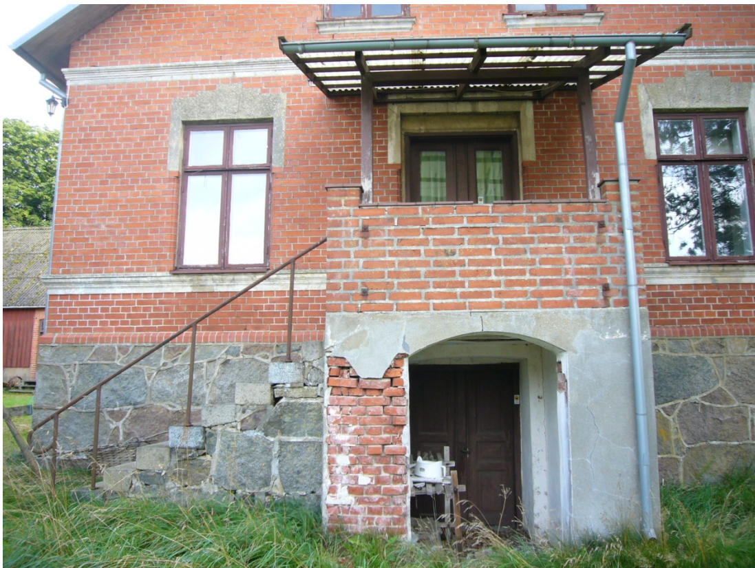
Södra gavelfasaden med trappa till köksingången samt källaringången.
