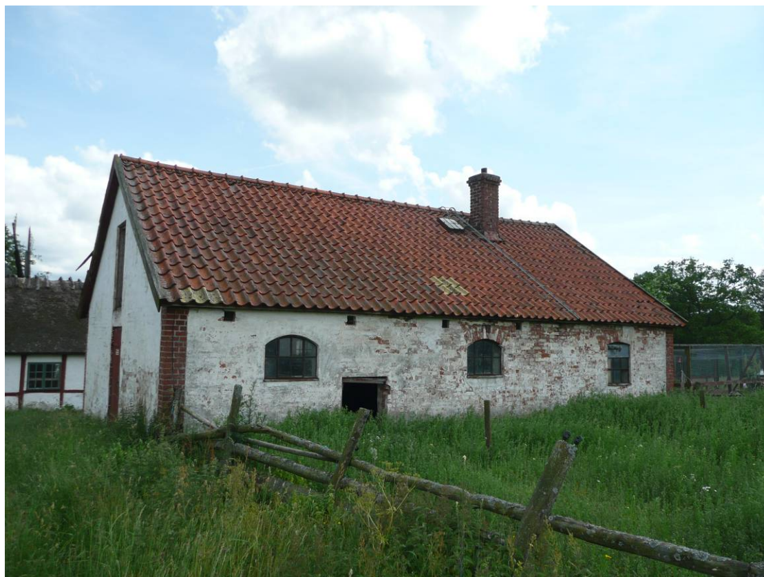
Svinhuset vy från nordväst. Skador i puts och tegelfog.
