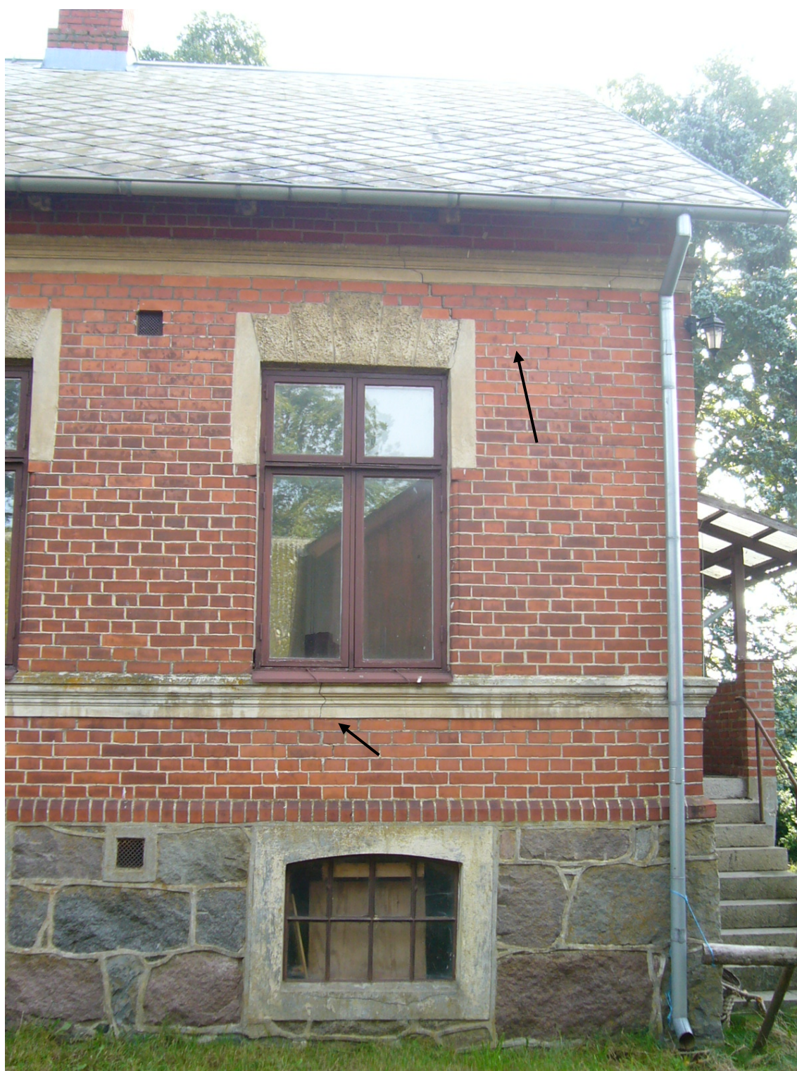
Västra fasaden södra delen, sprickbildning i fasaden.
