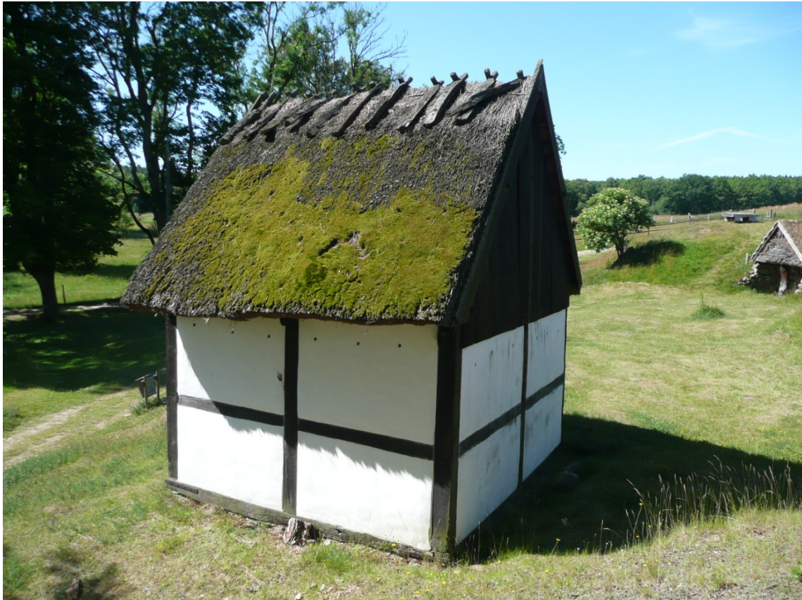
Norra fasaden och västra gavelfasaden. Taktäckningen har kasat ner något då avasaträet är ur läge.
