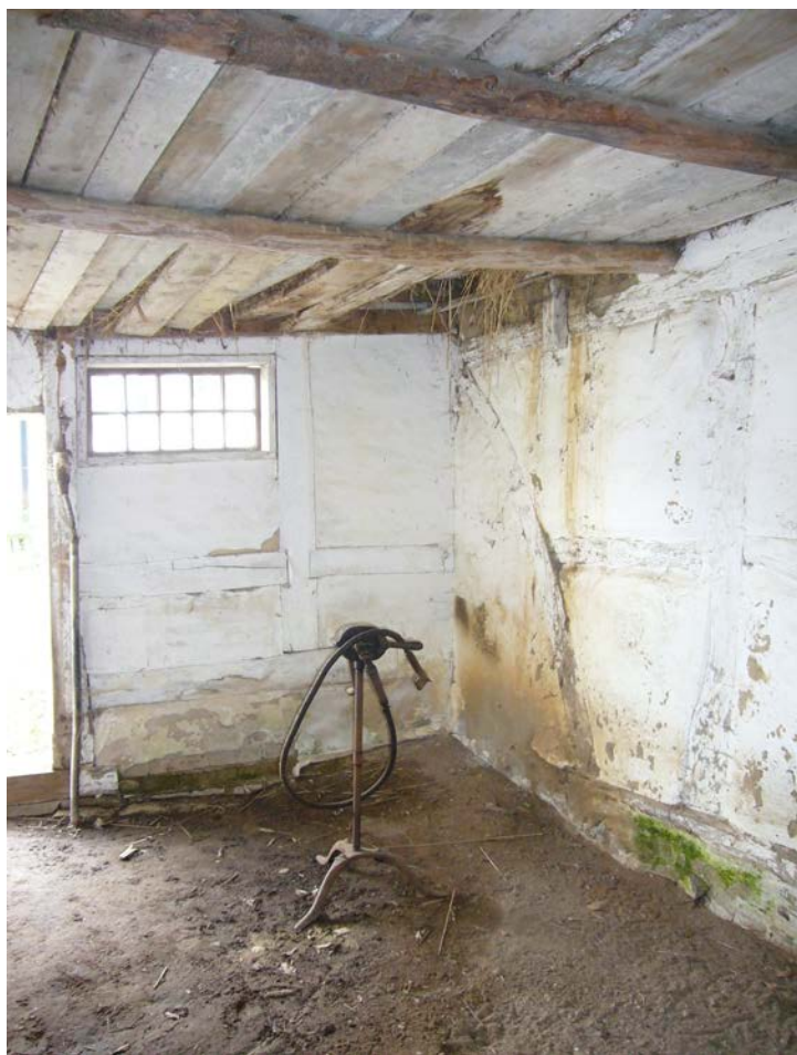
Figur 32. Fårahuset, vy från väster. Fuktskador i väggar och tak, fukt på golvet.
