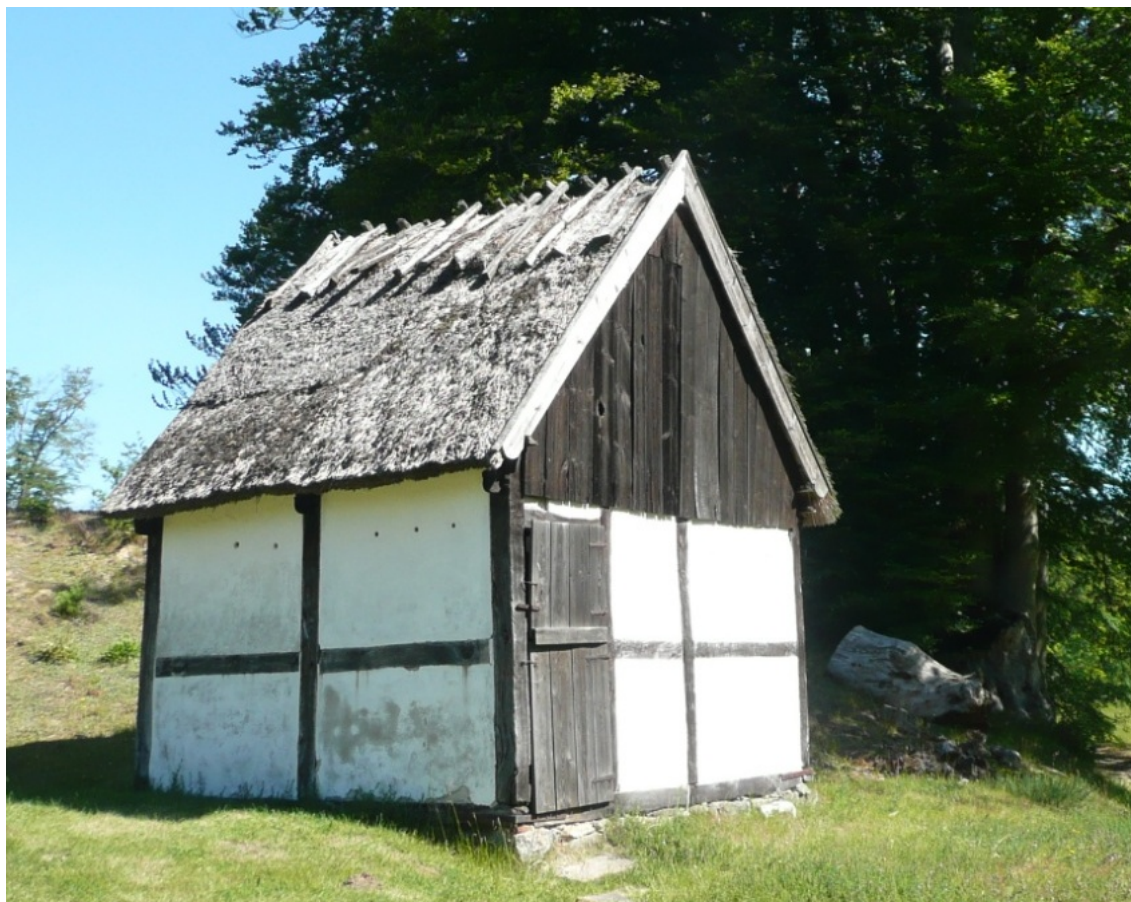
Södra fasaden och östra gavelfasaden.
