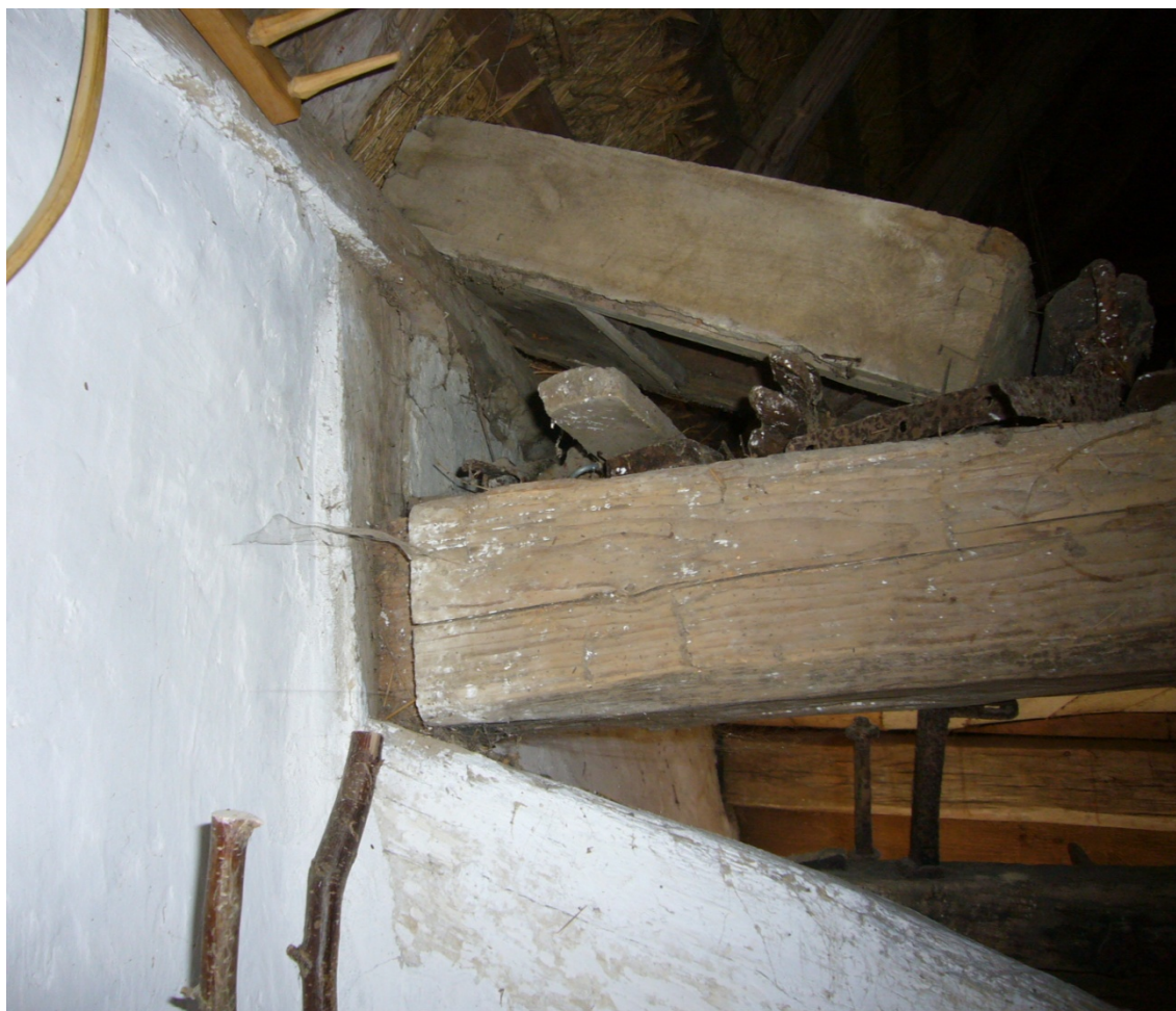
Figur 34. Stickbjälke i den östra väggen är något ur läge men är stabil. Denna bjälke liksom någon på varje vägg bör dock mätas in för att möjliggöra årlig kontroll av eventuella rörelser.
