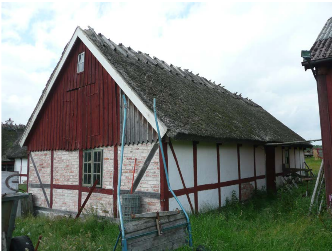
Figur 50. Norra fasaden och östra gavelfasaden. Kraftigt rötskadat fotträ på norra fasaden samt putsbortfall. Östra gavelfasaden har delvis ersatt korsvirke och ommurade fyllningar.
