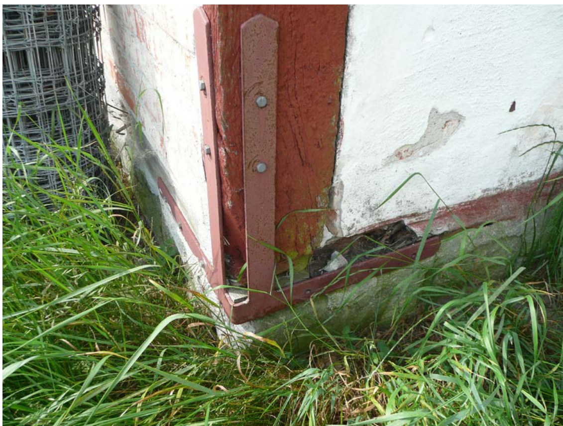
Figur 51. Fotträ i det nordöstra hörnet är kraftigt rötskadat.
