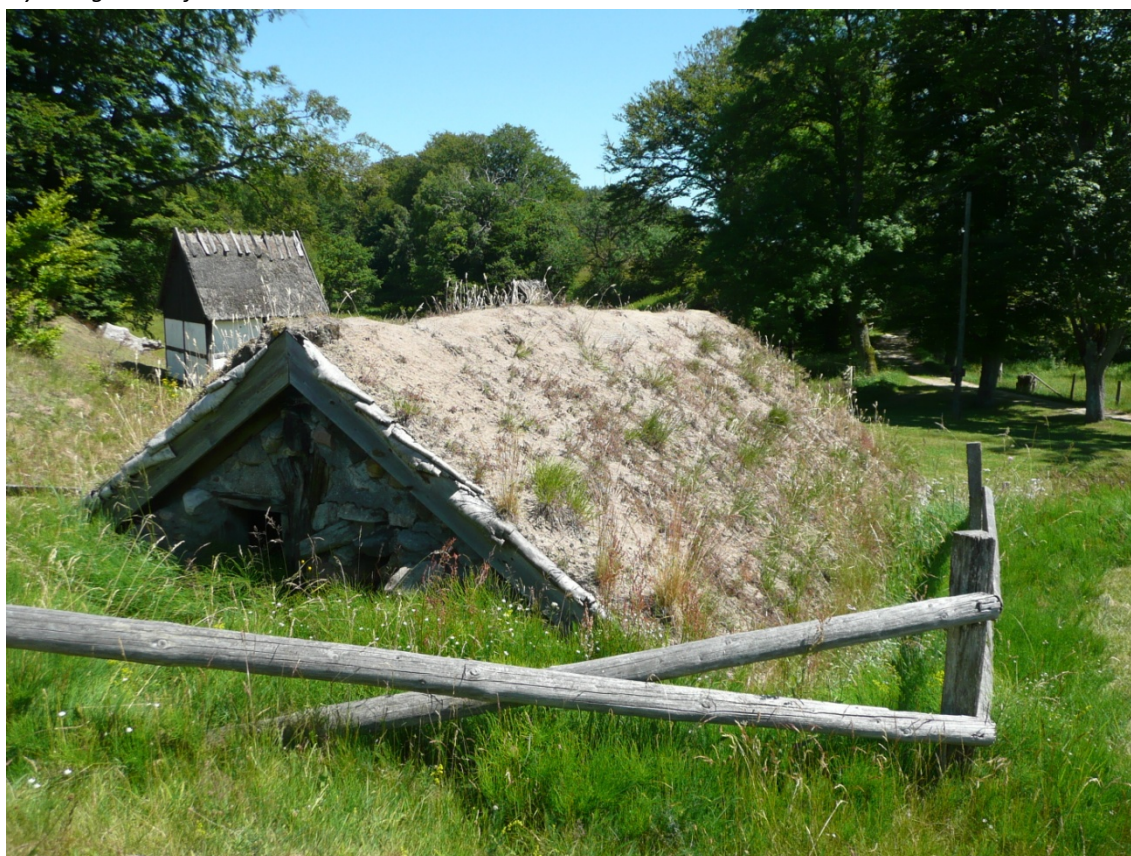
Brytestugan sett från sydväst. Gluggen och den vertikala stocken i gavelröset är rötskadade. Taktäckningen är i dåligt skick.
