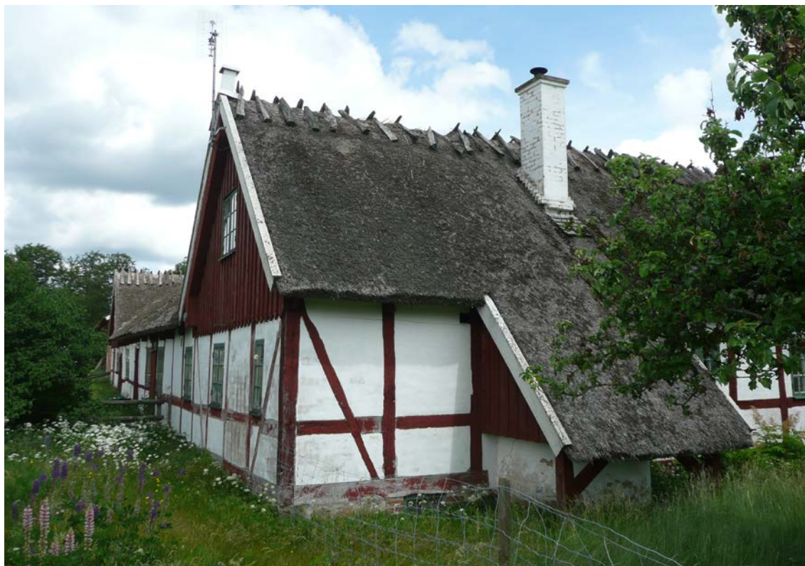
Figur 46. Sydvästra hörnet med "bakugnen". Bostadslängan sträcker sig till höger i bild. Tegel lyser igenom putsen på den östra gavelfasaden. Ryggningen på taket är i dåligt skick.
