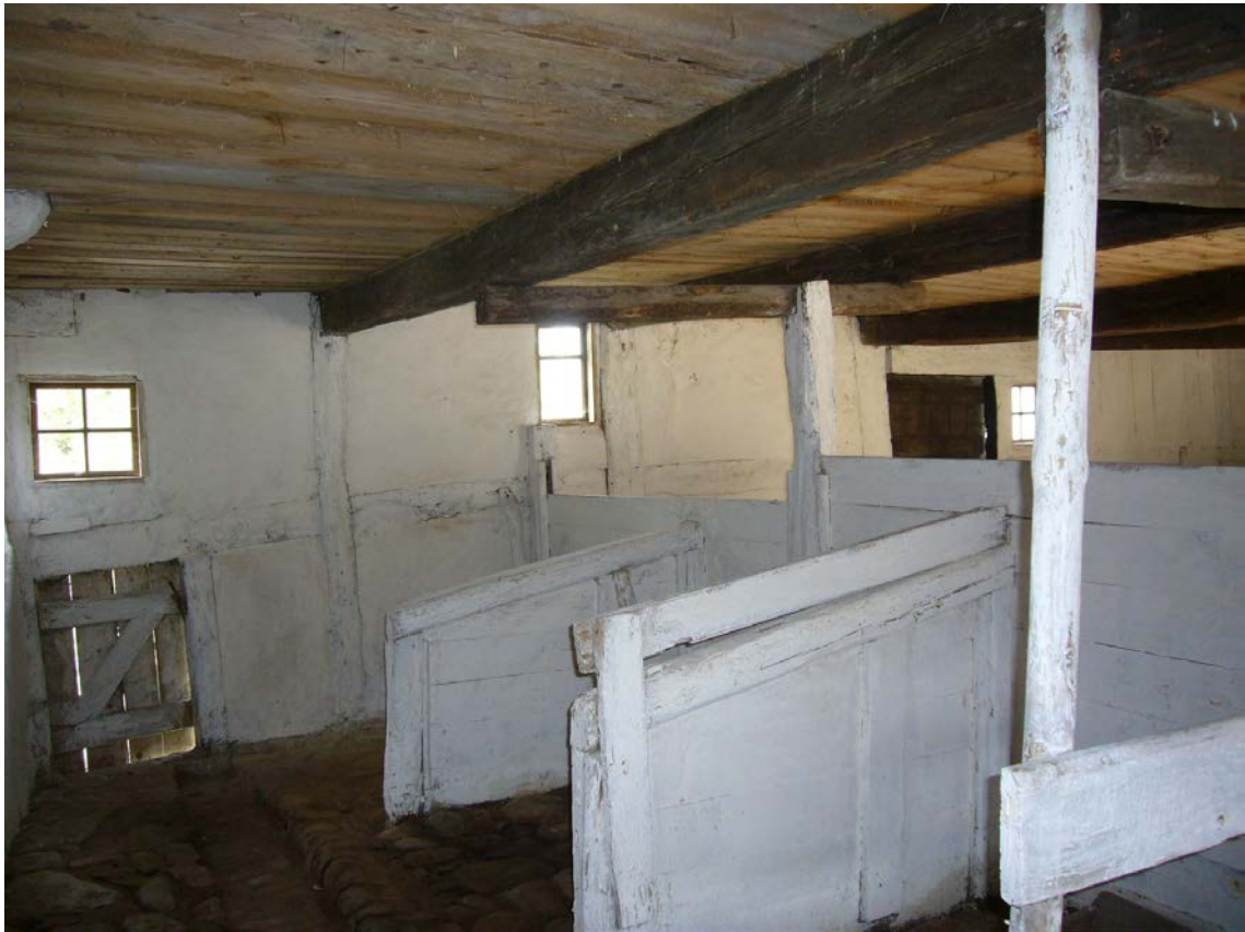
Figur 35. Fähus, vy mot öster, i takbjälkarna finns spår av olika behuggningar och yxor samt virke med och utan vankant.
