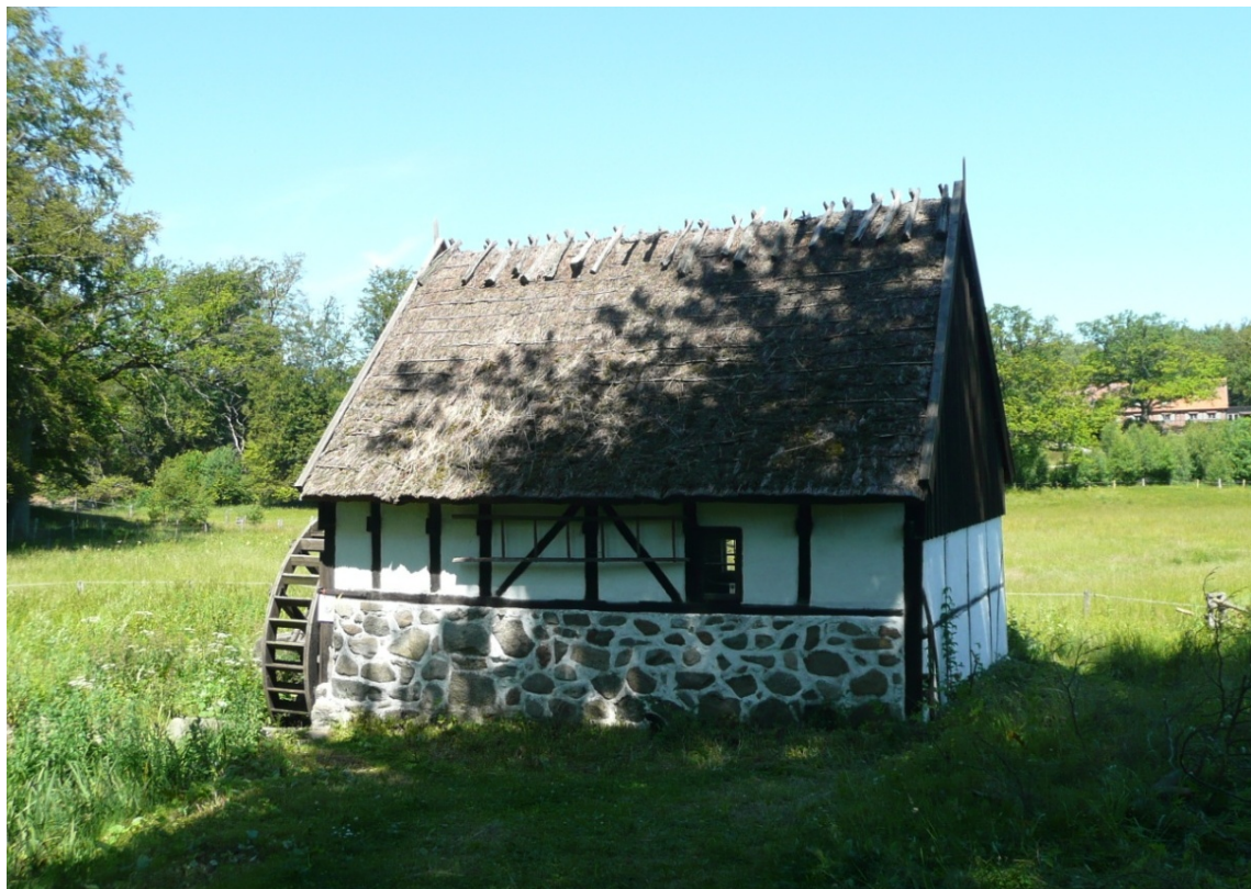
Södra fasaden och östra gavelfasaden.
