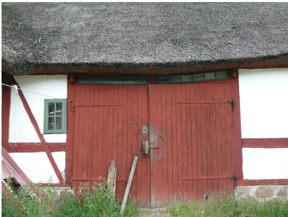
Figur 53. Södra fasaden. Lejden är rötskadad och böjd vilket även medfört att överljuset är böjt. Rötskadat fotträ i hörnet till vänster i bild.
