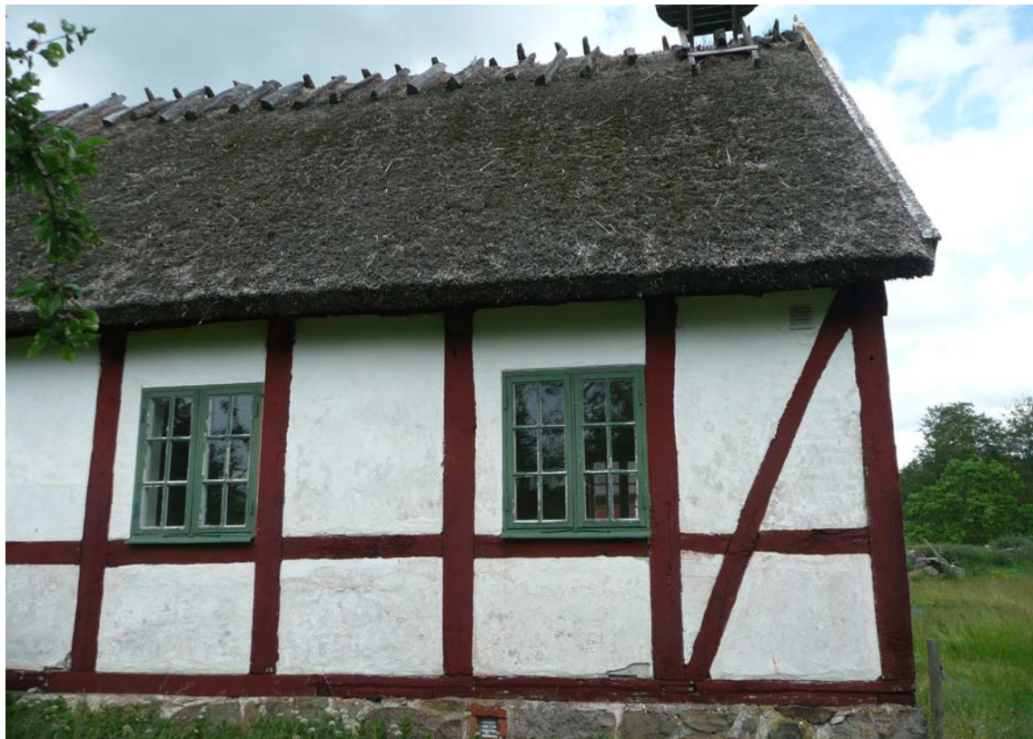
Figur 45. Södra fasaden, urtag i fotträ.
