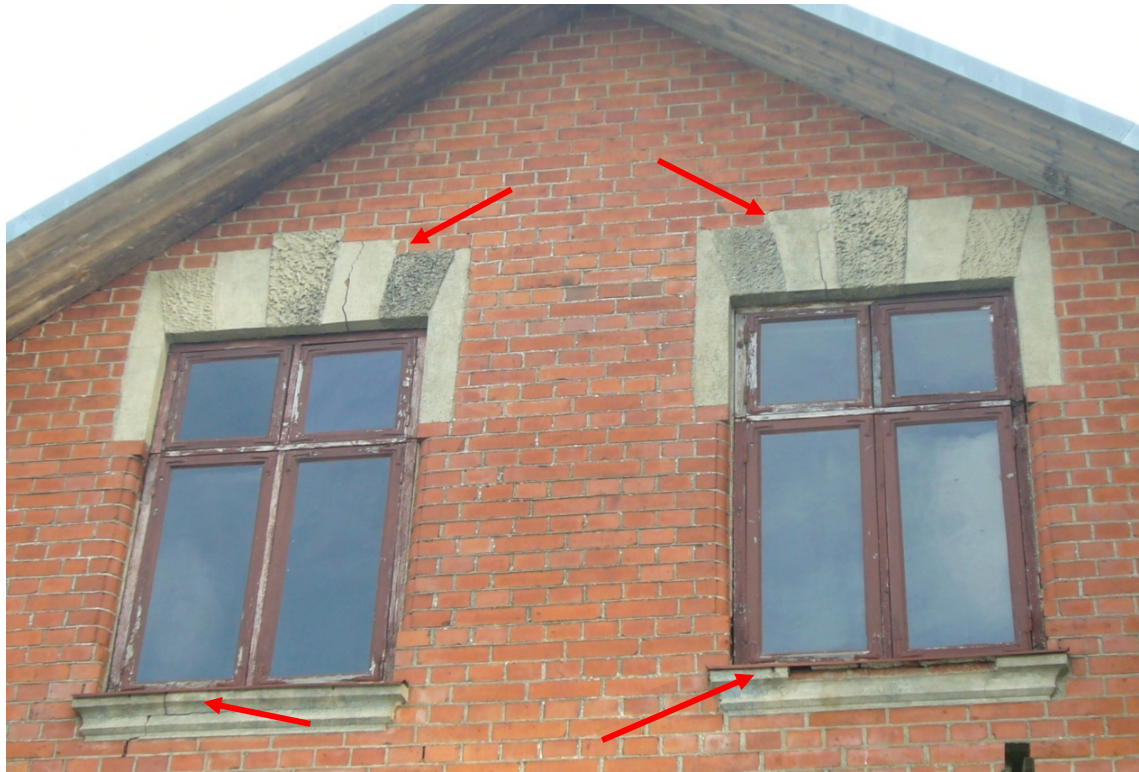
Södra gavelröset, pilarna visar på sprickor.
