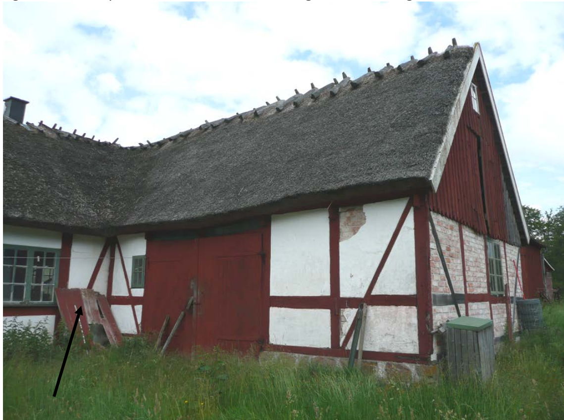
Figur 52. Södra fasaden. Pilen visar rötskadad stolpe och snedsträva på den östra fasaden. Takfallen är i gott skick med ryggingen är mycket dålig.
