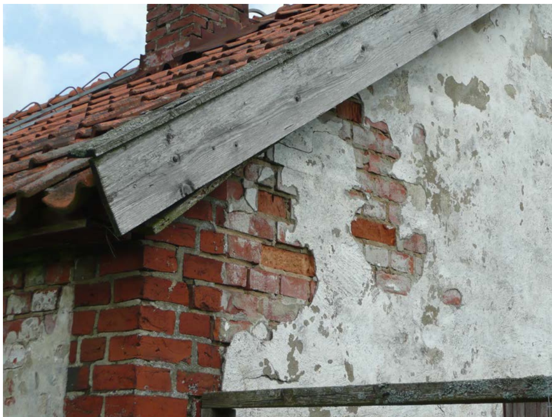
Sydvästra hörnet. Läckande tak har orsakat fasadskador.
