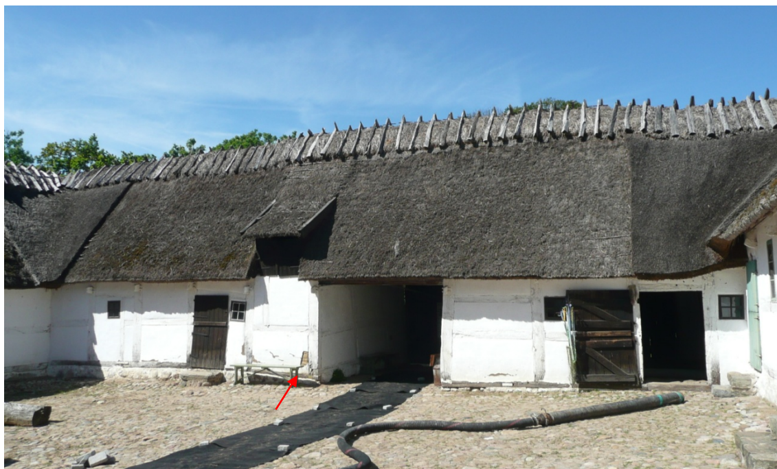
Figur 9. Södra gårdsfasaden, pilen visar på puts och lerstensskador.
