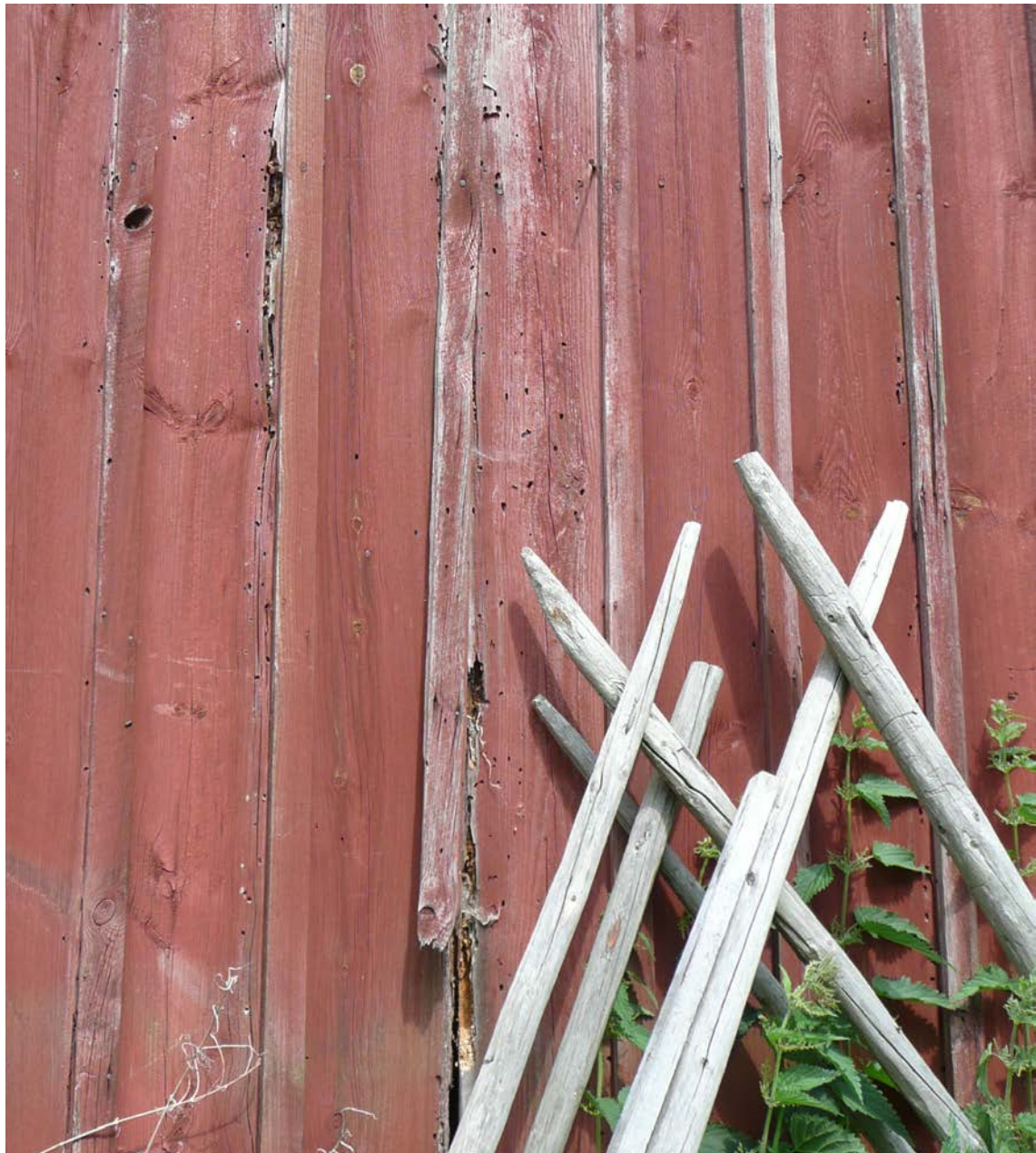
Södra fasaden. Rötskadad och insektsangripen locklistpanel. Endast kraftigt skadade delar ersätts.
