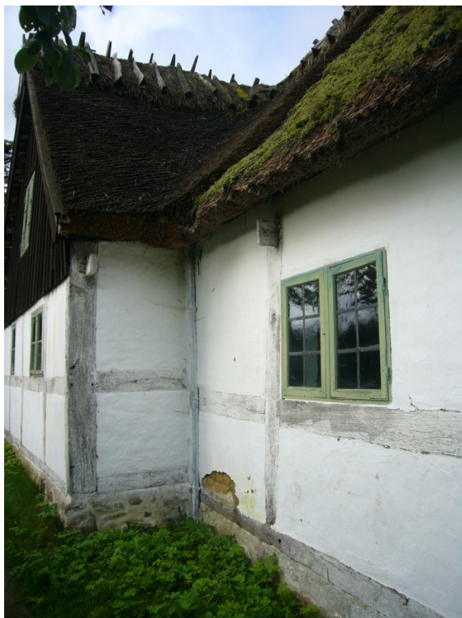
Figur 13. Den östra längan, möte mot södra längans östra gavelfasad. Putsskada i korsvirkesfyllning längst i söder. Rummet innanför har haft hussvampsangrepp. Fotträet är något rötskadat och det finns risk att fotträet är angripet av hussvamp.
