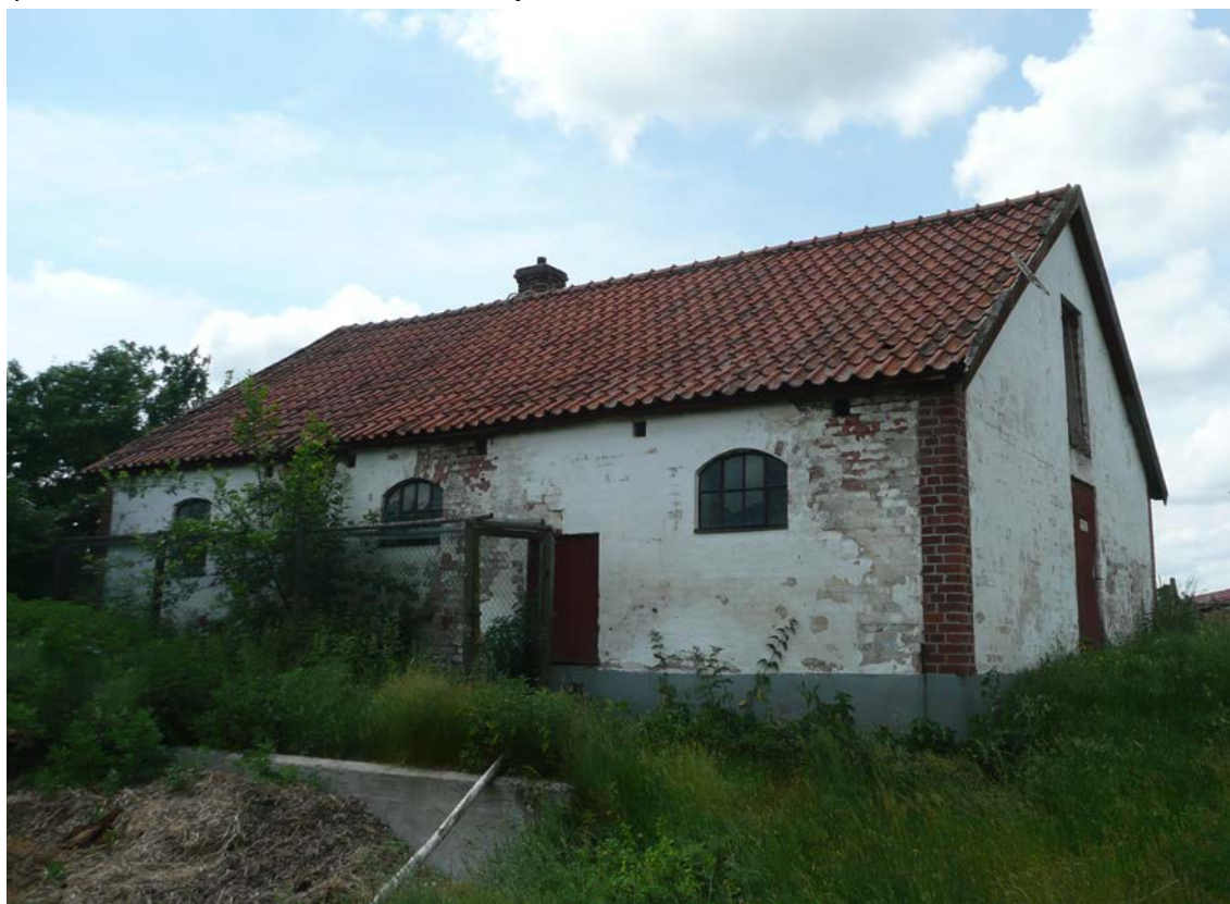
Östra fasaden och norra gavelfasaden.
