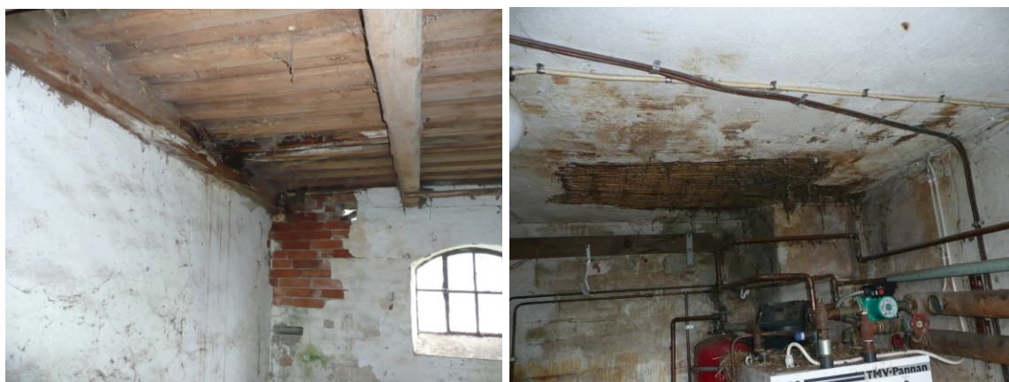
Rötskadat tak och takbjälke och fuktskada i innervägg. Fuktskadat reveterat tak och putsade väggar i pannrummet.
