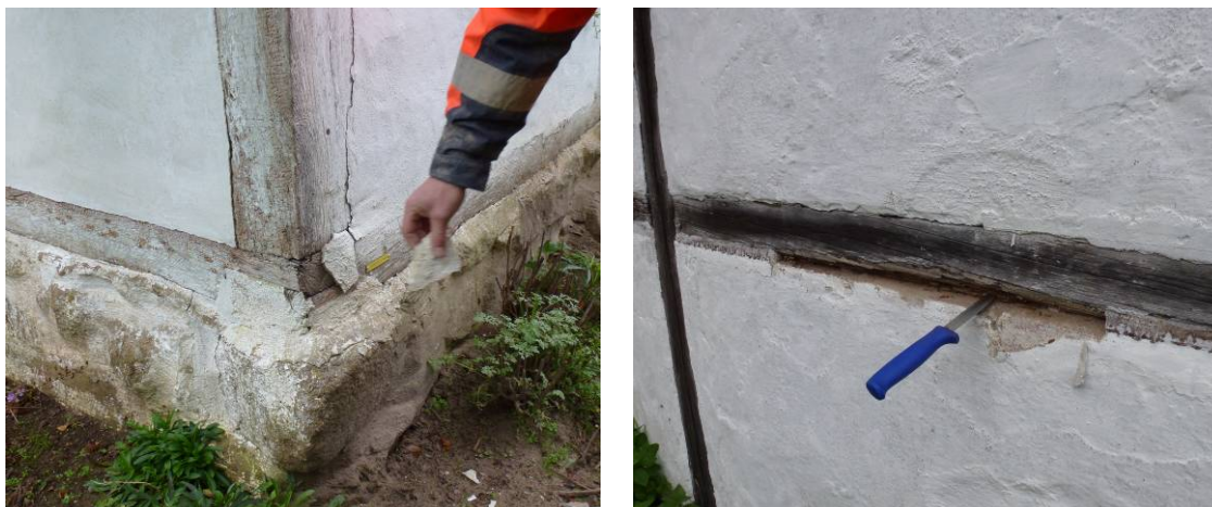
Figur 1. Exempel där fotträ tätats med bruk och fyllningen som ligger an emot trä och har orsakat början till rötskador. Bruket bör snarast knacka bort. Gamlegård sydvästra hörnet och vattenmöllan östra fasaden.
