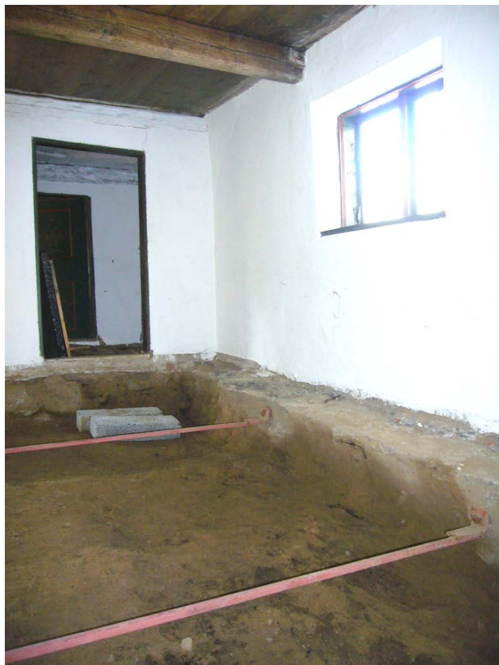
Figur 29. Golvet är urgrävt, rum 5 Dagligstuga, vy mot väster. På bilden syns dragjärn inmonterade 2007.
