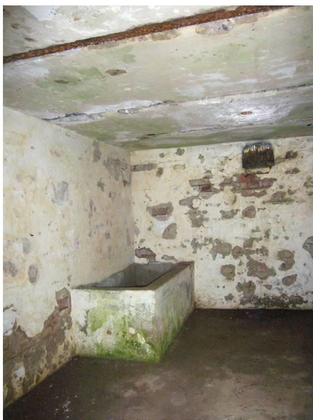
Figur 20. Jordkällaren interiör, vy från norr mot söder.
