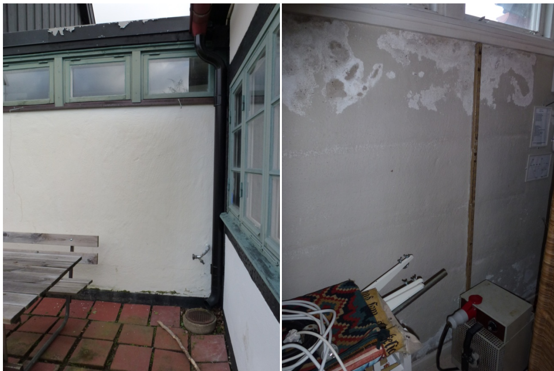
Södra fasaden med fukt och putsbortfall. Interiör fuktgenomslag i väggen.
