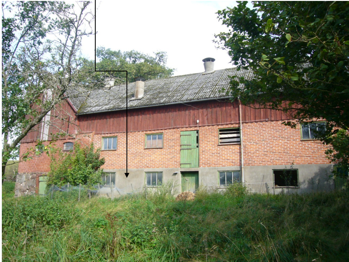
Södra längan, södra fasaden sockelvåning.
