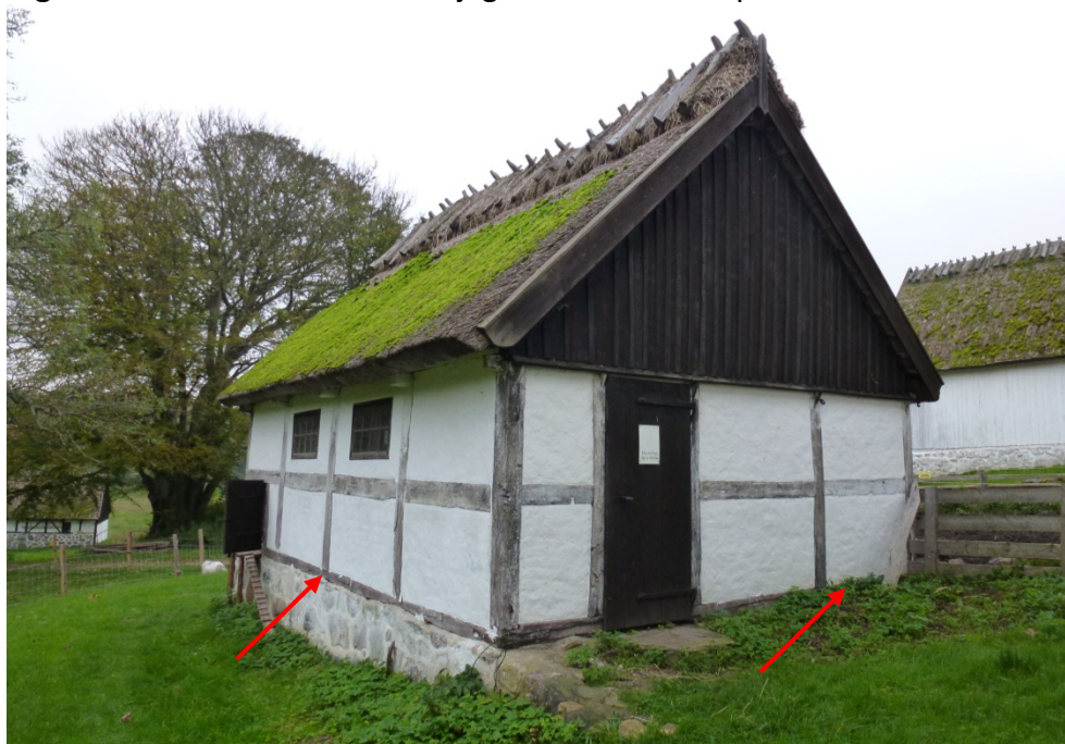
Figur 21. Vy från sydväst. Pilarna markerar rötskadat fotträ och stolpar.
