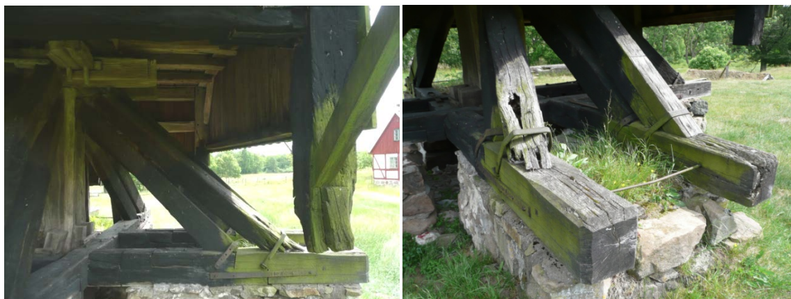
Skarvade och rötskadade fotträn, rötskadade fot-stivor.
