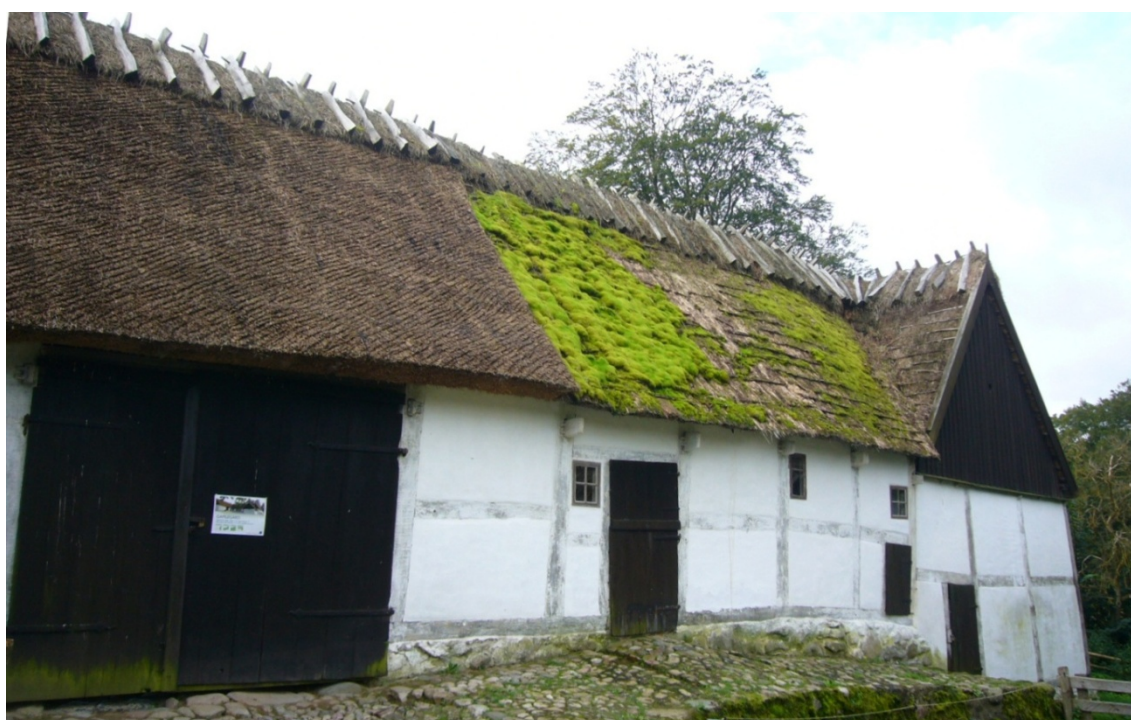
Figur 10. Vy från norr. Takfallet till höger i bild, (västra delen) är i dåligt skick och raften är synlig. Grön påväxt på portar och de nedre facken i väster. De övre facken är något fuktskadade på grund av den bristfälliga takräckningen.
