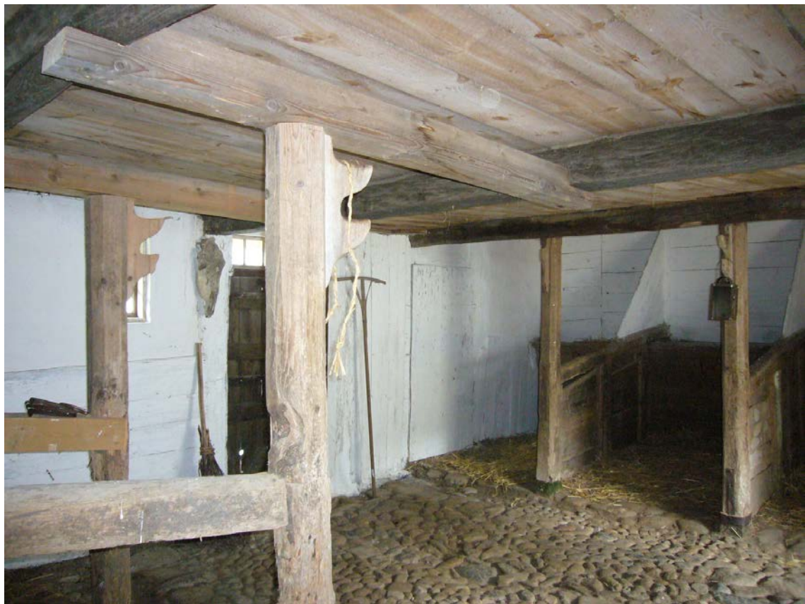
Figur 36. Häststallet, vy mot öster. Nya stödbjälkar i taket.
