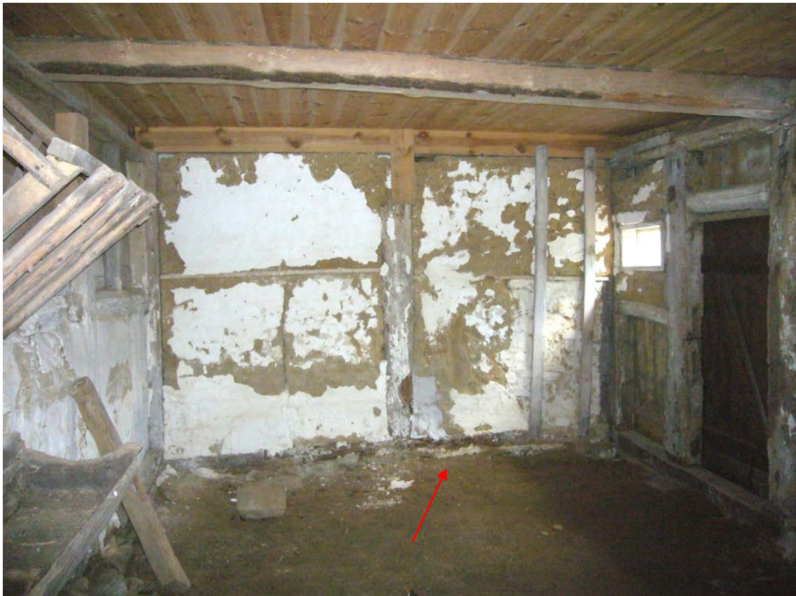
Figur 37. Fölahuset vy från söder mot den norra väggen. Patinerade fack samt avlastningsbräda som visar hur klinefacken är uppbyggda. Pilen visar på mjukt fotträ.
