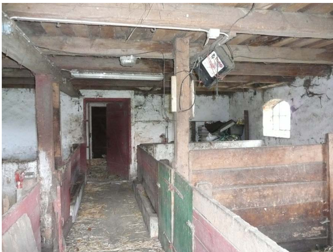
Svinstallet, vy från norr mot hönsuset.
