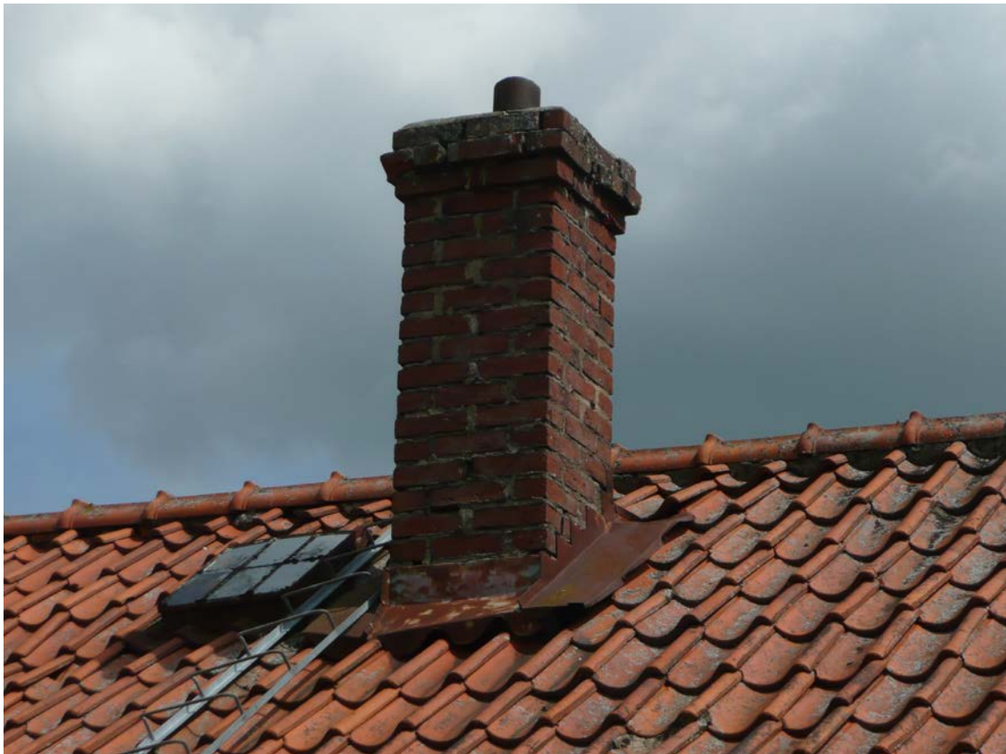
Skorsten och takfönster.
