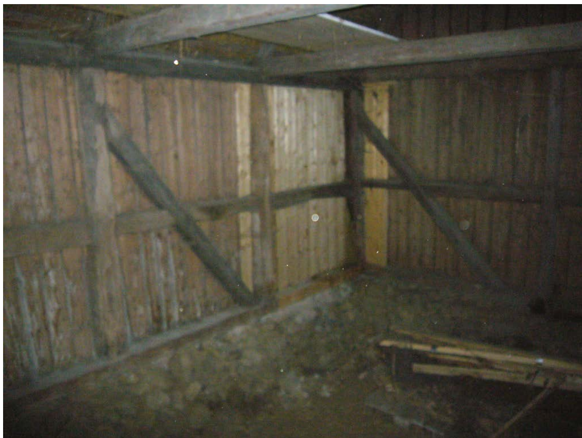
Figur 40. 24-25 loge, stolpverk med utvändig fasadpanel. I hörnet är panelen ersatt 2001.
