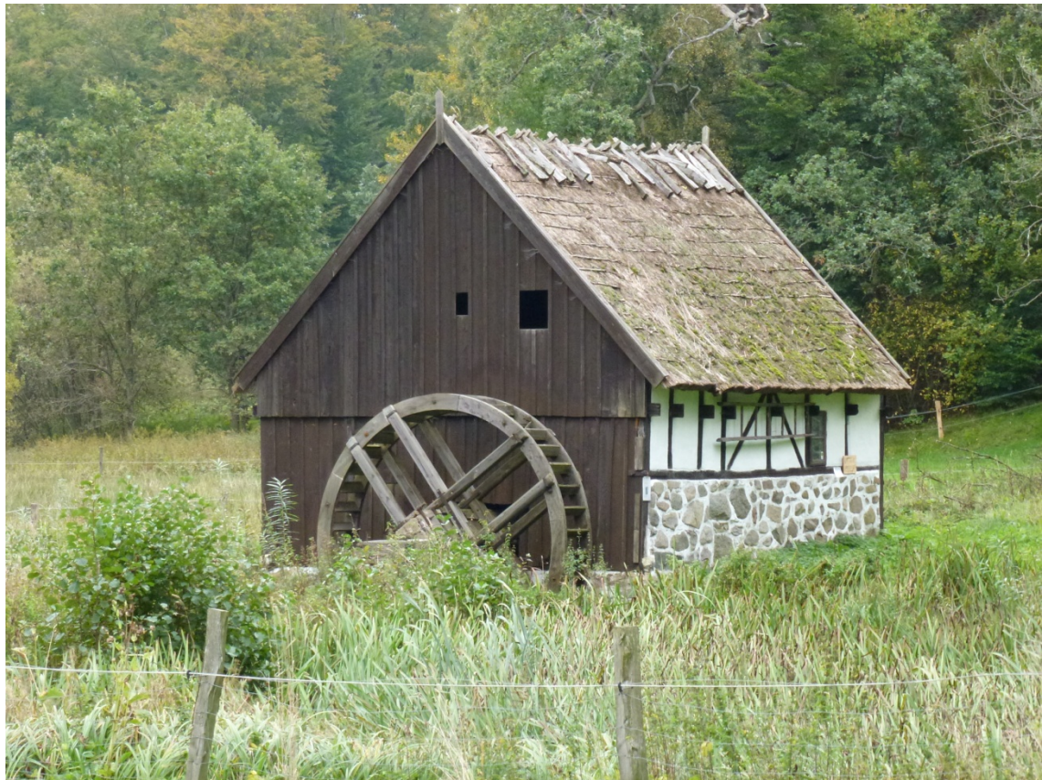
Västra gavelfasaden och södra fasaden. Dammen framför möllan är igenvuxen. Taktäckningen är i dåligt skick.
