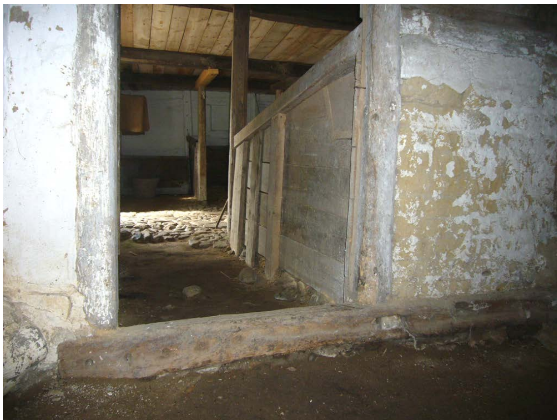
Figur 38. Fölahuset, återanvänt fotträ med urtag för stakar och stolpar nu vänt i sidled. Vy från öster mot häststallet.
