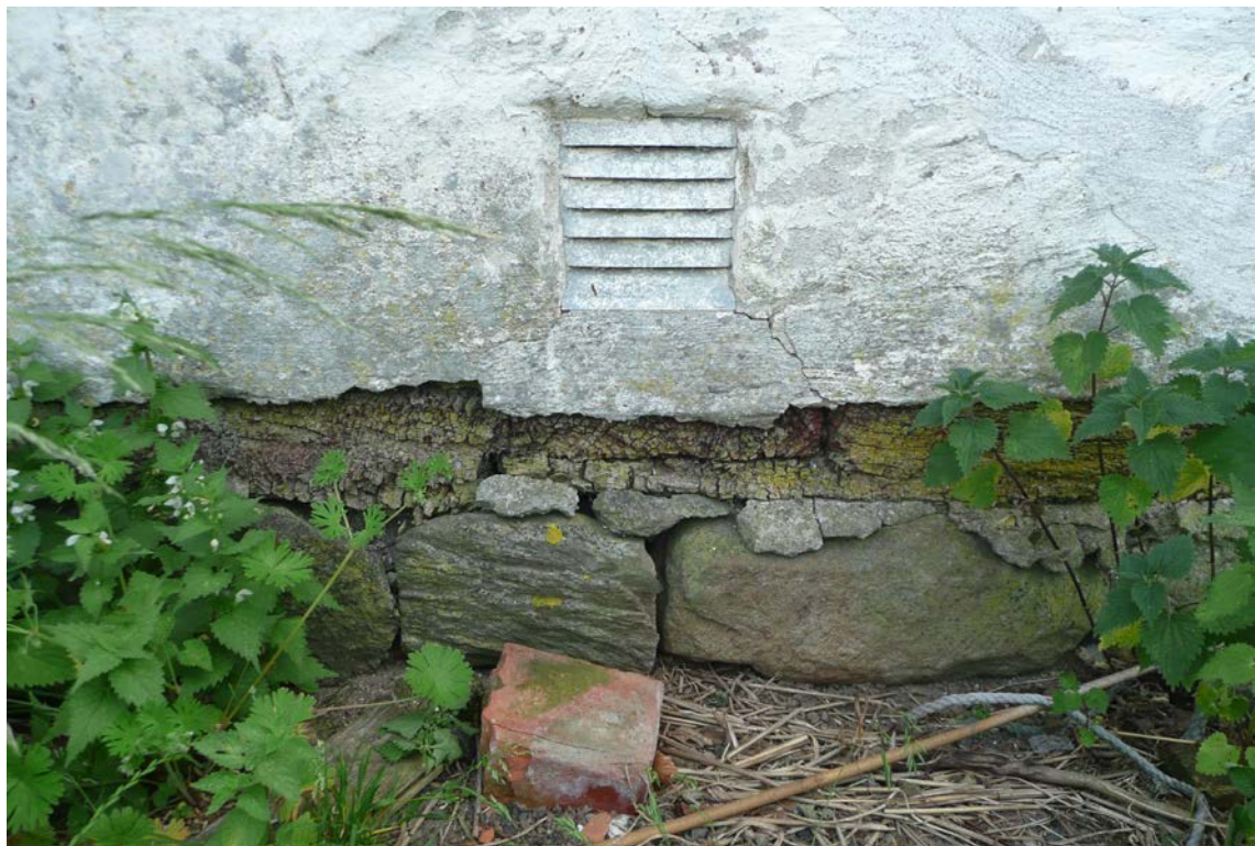
Figur 48. Fotträ i ek är gammalt med i gott skick, västra fasaden. Puts bör inte ligga en emot fotträ.
