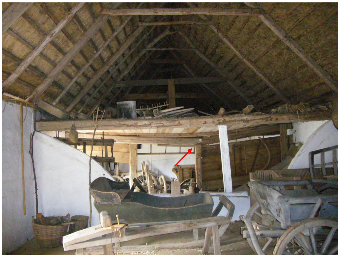
Figur 33. Logen, vy från norr. Pilen visar knäckt takbjälke.
