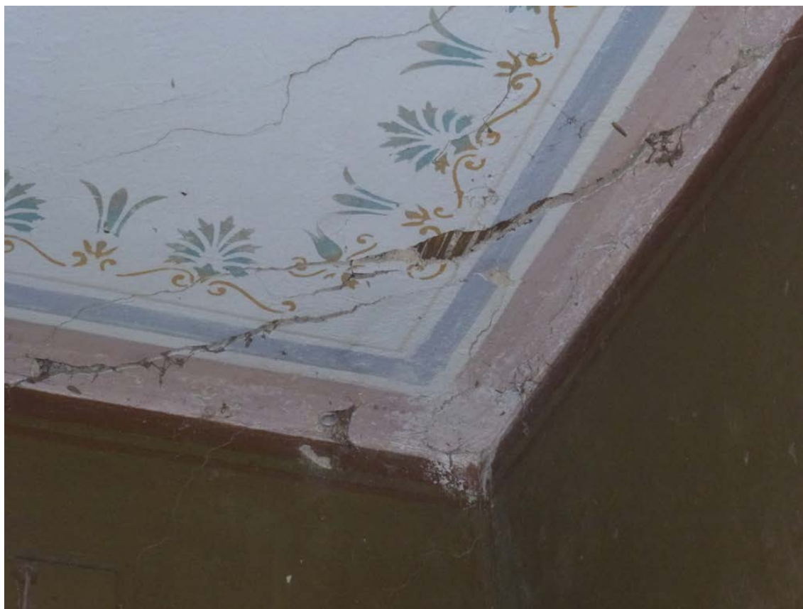
Entré i norr. Sprickor i taket, nordvästra hörnet, vassmatta är synlig is sprickan.
