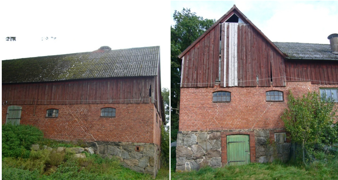
Sprickbildningar och rötskadat hammarband under panelen på västra fasaden och södra gavelfasaden.
