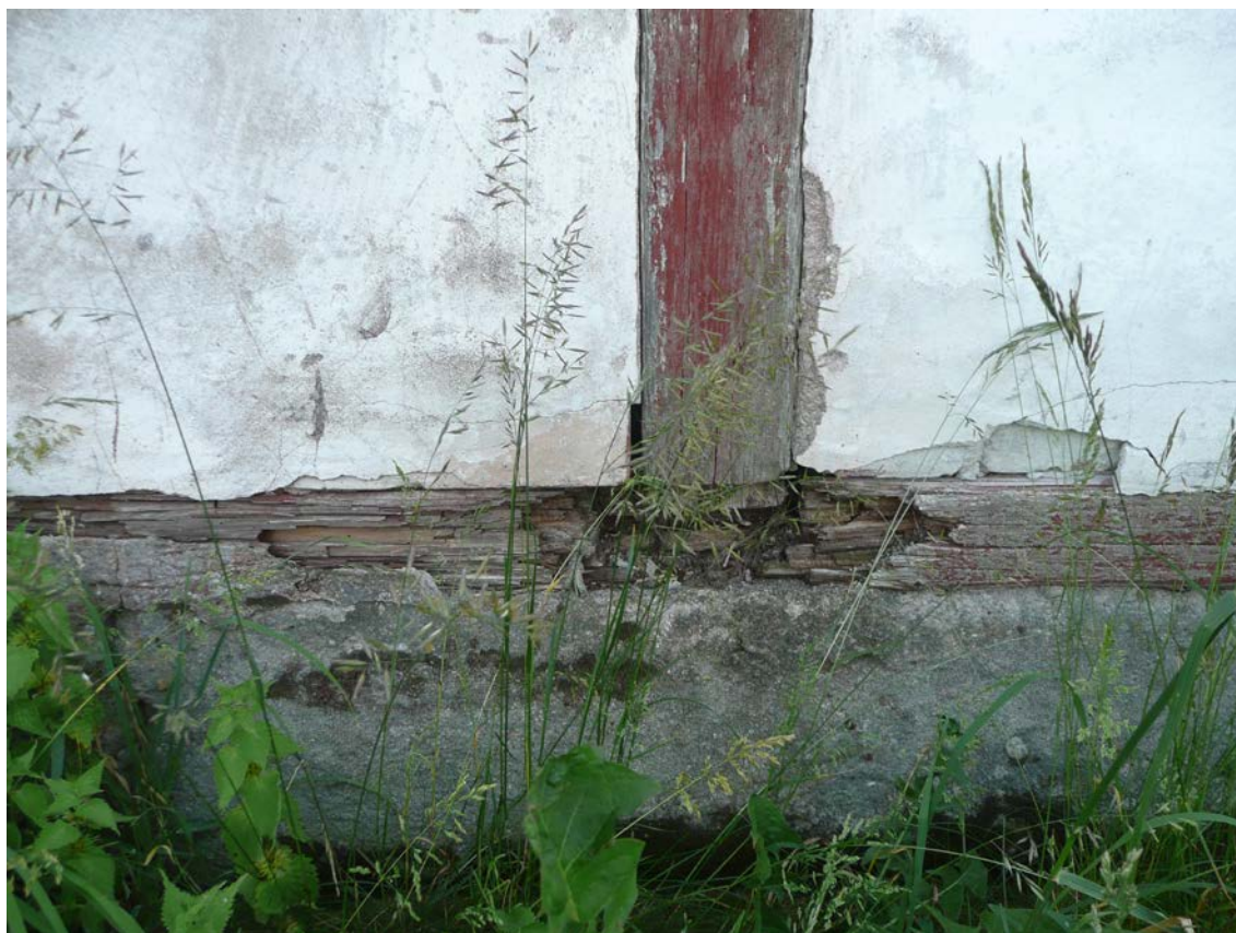
Figur 49. Kraftigt rötskadat fotträ i fur på västra fasaden.
