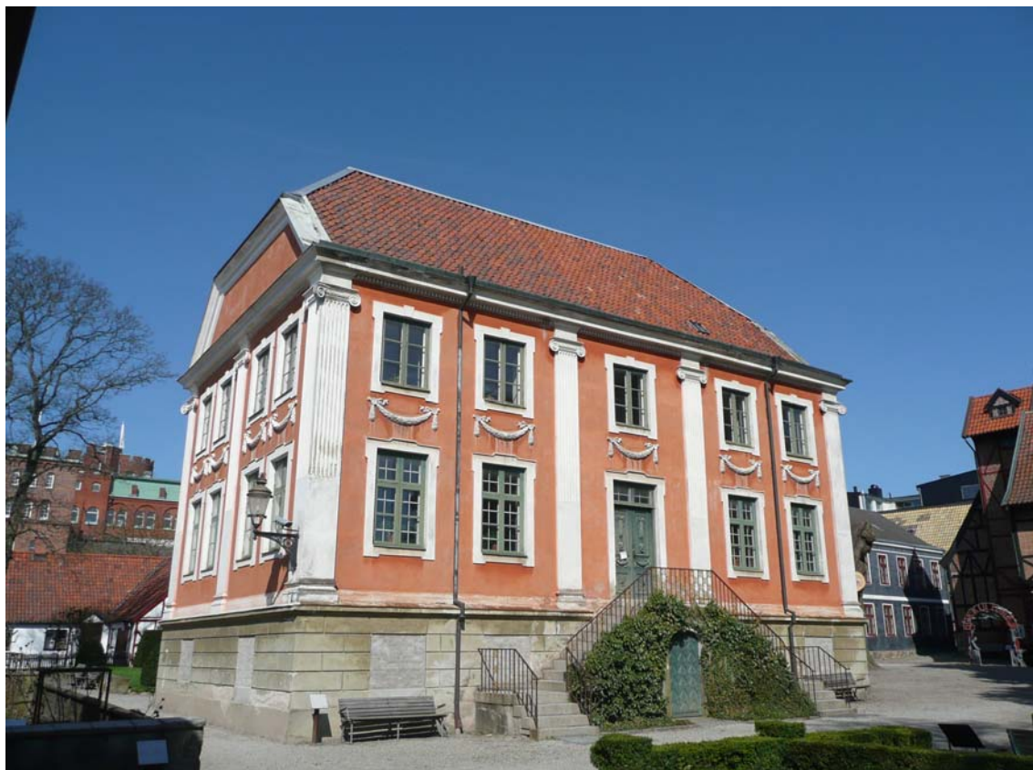
Foto från sydöst. Huvudentré i öster. På takfallet finns ett takfönster.
