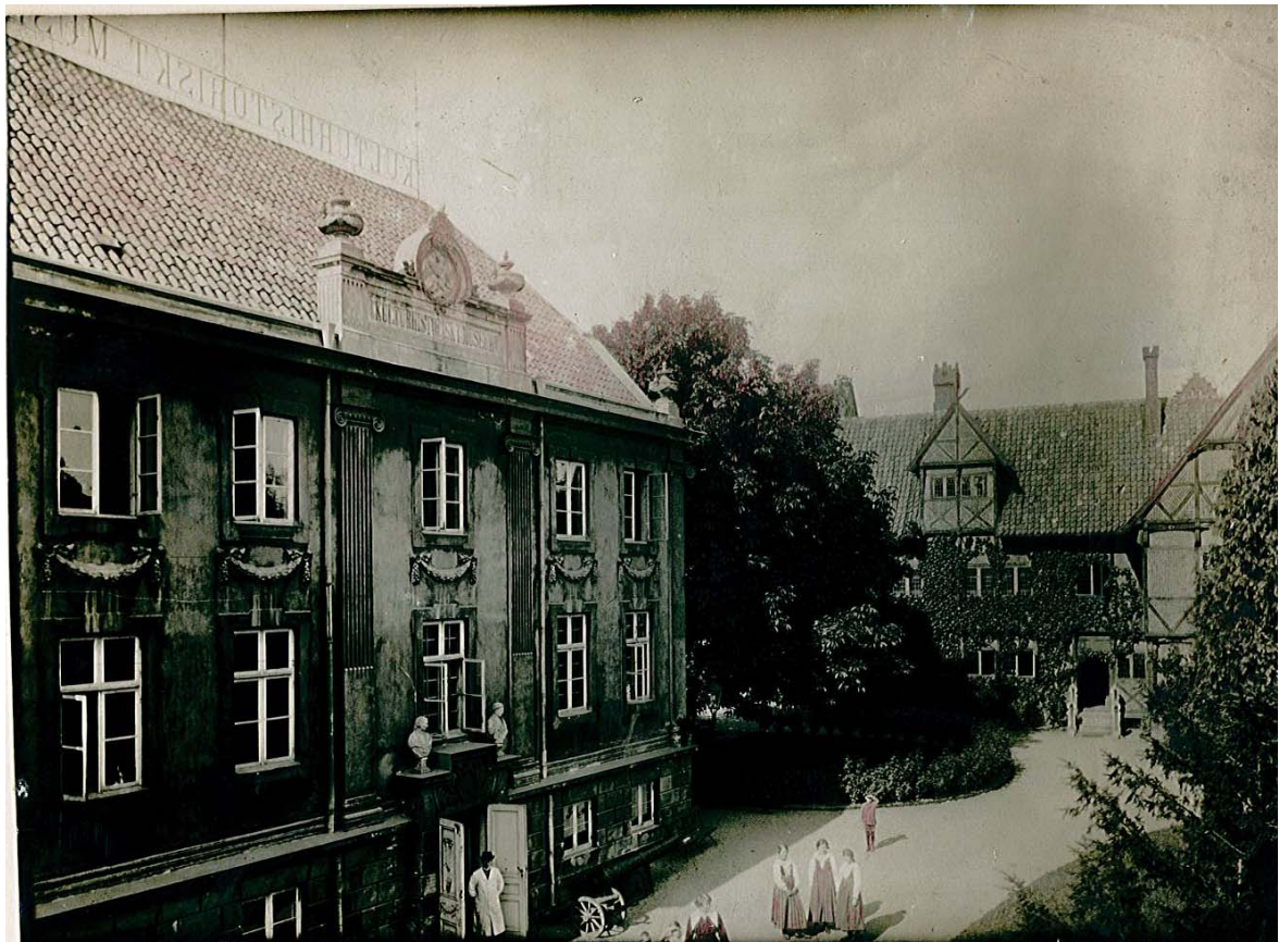
År 1914, östra fasaden. Efter att Kulturen köpte huset fick fasaden en ny gestaltning, här har huset även en fronton och en skylt längs hela taknocken. Entré från bottenvåningen. Källa: Kulturens arkiv. B3555.
