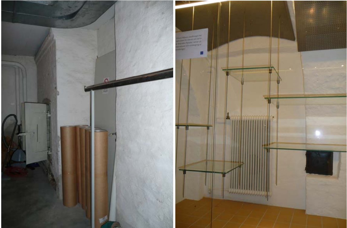
Till vänster: Den norra väggen fotograferad från öster. Till höger: Den södra väggen i rummet med tunnvalvet. Här finns strukturen av murstockar till den före detta köksavdelningen bevarad.
