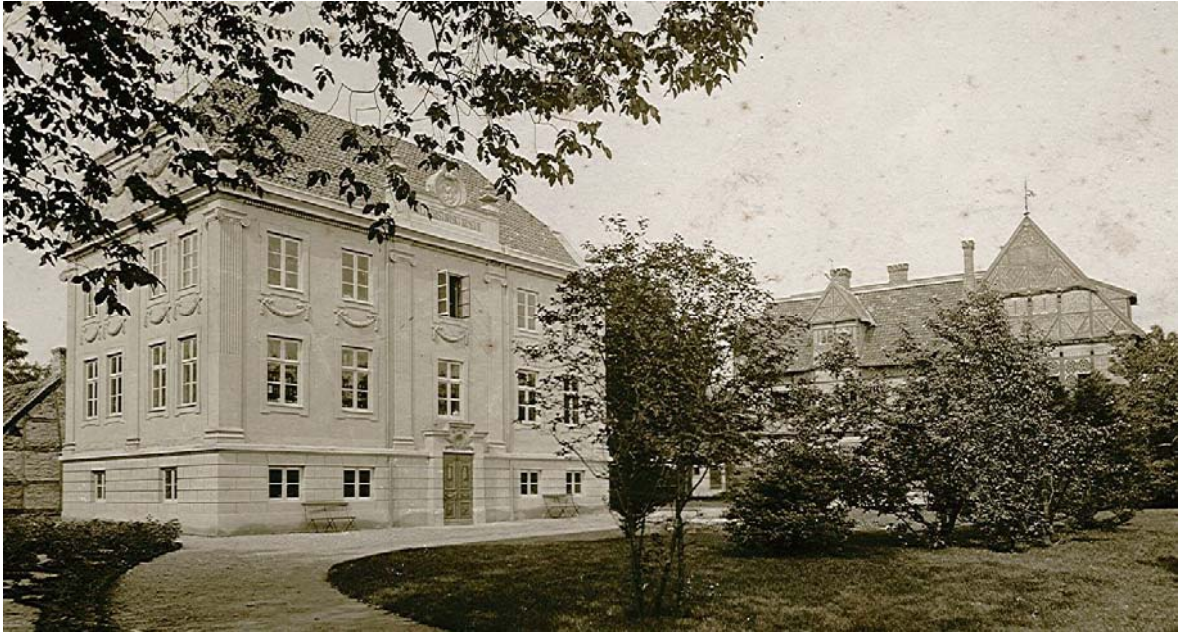
Vy från sydost år 1899. Fasaden ser ut att vara helt vit/ljusmålad, fönstren är vita och dörren en mörkare nyans. Dörren är sannolikt samma som idag. Ett kolorerat vykort från samma tid visar ljusgul fasad med vita dekorationer och fönster. Källa: Kulturens arkiv.
