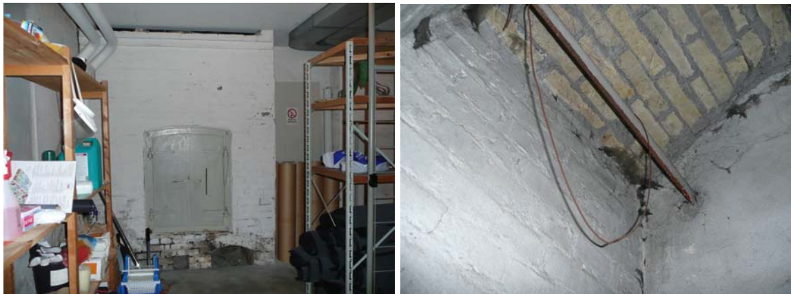
Till vänster: Spis/bakugn i det nordvästra hörnet i el-centralen. Öppningarna nertill leder ner under golvnivå. Till höger: Spisen/bakugnen är invändigt murad med tegel och taket är murat tunnvalv.
