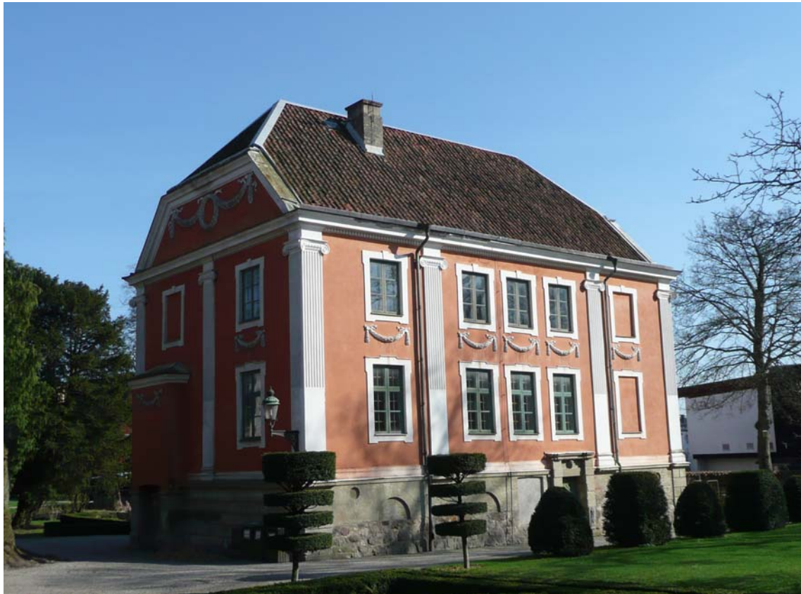
Foto från nordväst. På takfallet finns ett takfönster intill skorstenen (i bild vänster om skorstenen) På norra gaveln en liten utbyggnad med blindportal.
