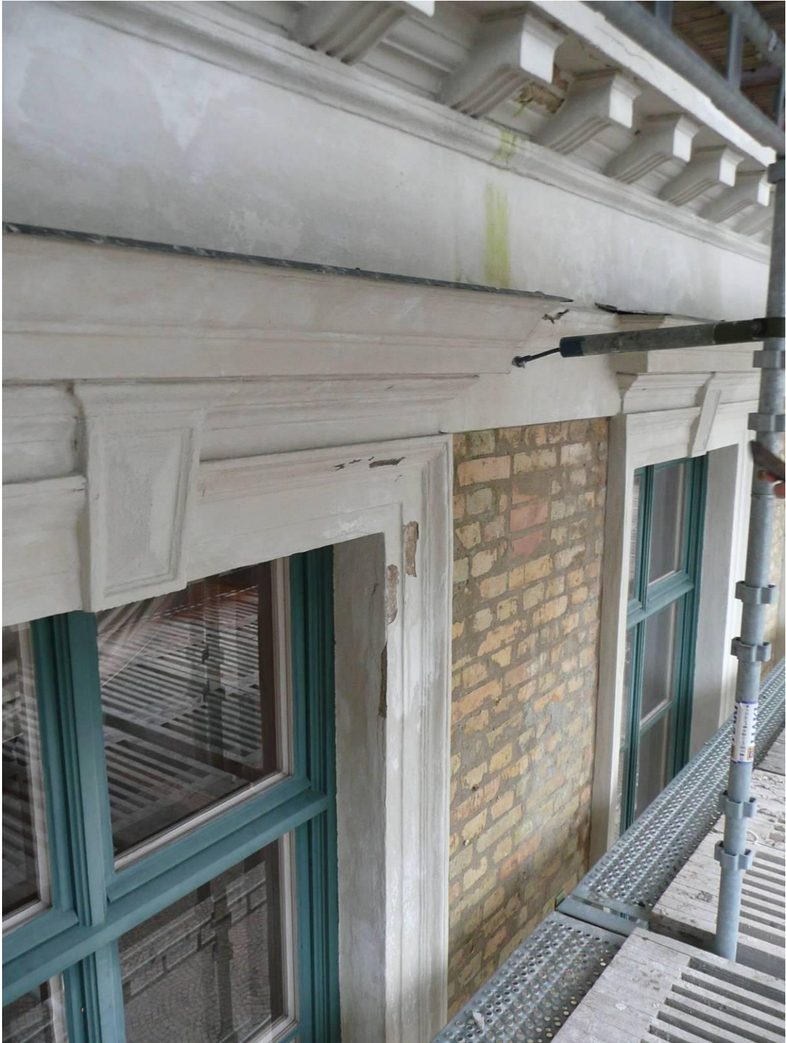
Figur 13. Före åtgärder. Exempel på skador i takgesimsen och fönsteromfattning. Vy från nordost. Fönster före ommålning.
