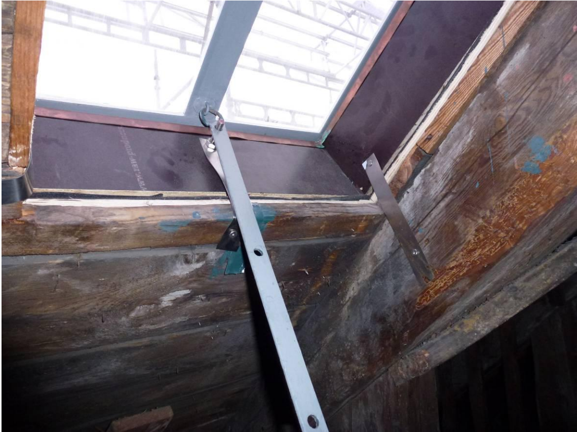
Figur 26. Efter åtgärder. Takfönstrets sarg är förhöjd och nyuppförd i plywood.
