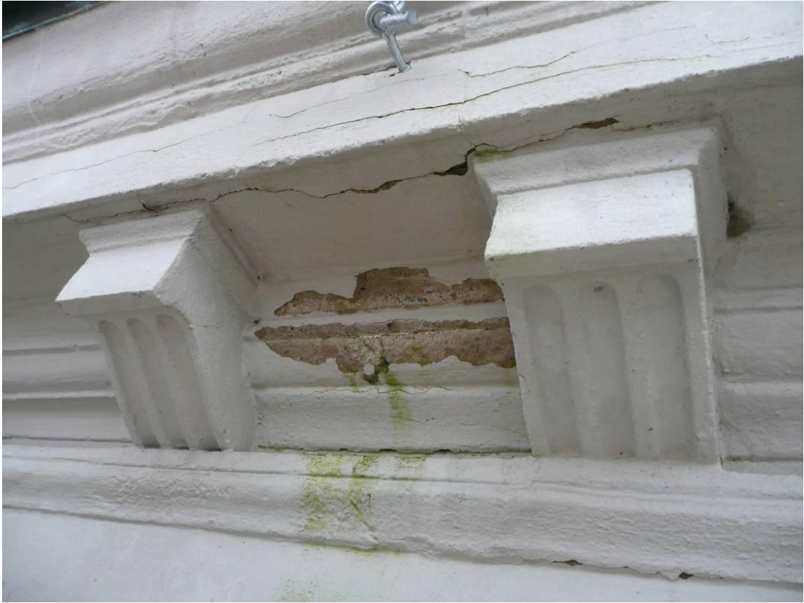
Figur 14. Före åtgärder. Exempel på skador i takgesimsen.
