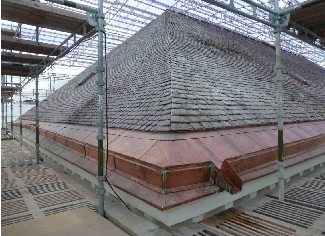
Figur 24. Södra och östra takfallet. Nytt nockrärke i öster.
