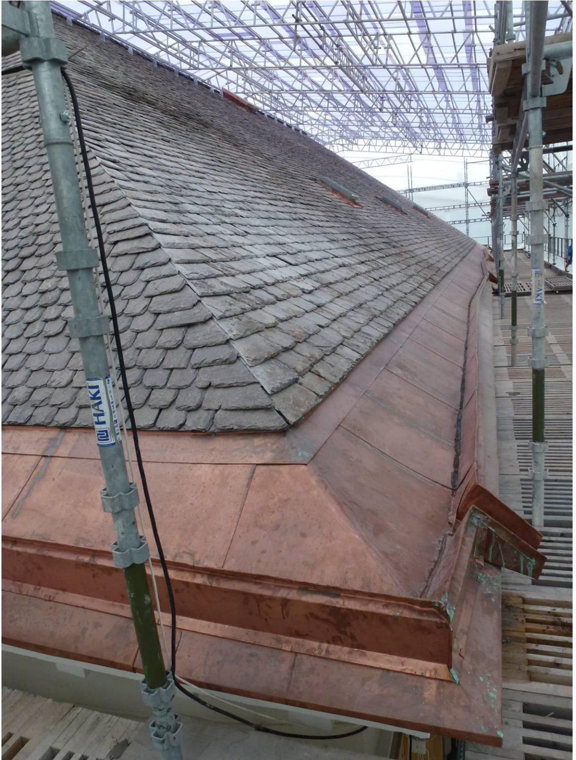
Figur 21. Efter åtgärder. På det södra takfallet, till vänster i bild, återmonterat Ramkvillaskiffer. Till höger i bild, östra takfallet kompletterat med Glavaskiffer. Fotrännan har byggts med fall till varje stuprör, fyra på var långsida. Vattenkuporna monterades senare i samband med att ställningarna revs, eftersom dessa var i vägen för vattenkuporna.
