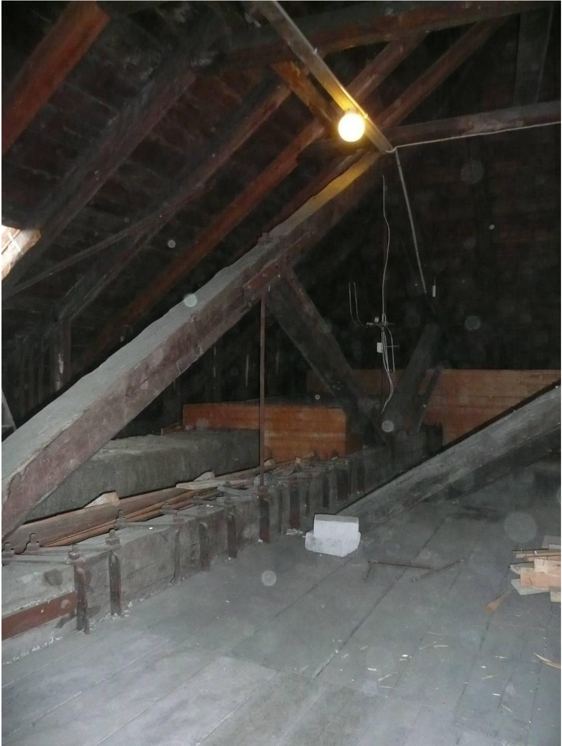
Figur 37. Före åtgärder, vinden. Tvärgående takbjälkar hänger med järn i den längsgående takbjälken.
