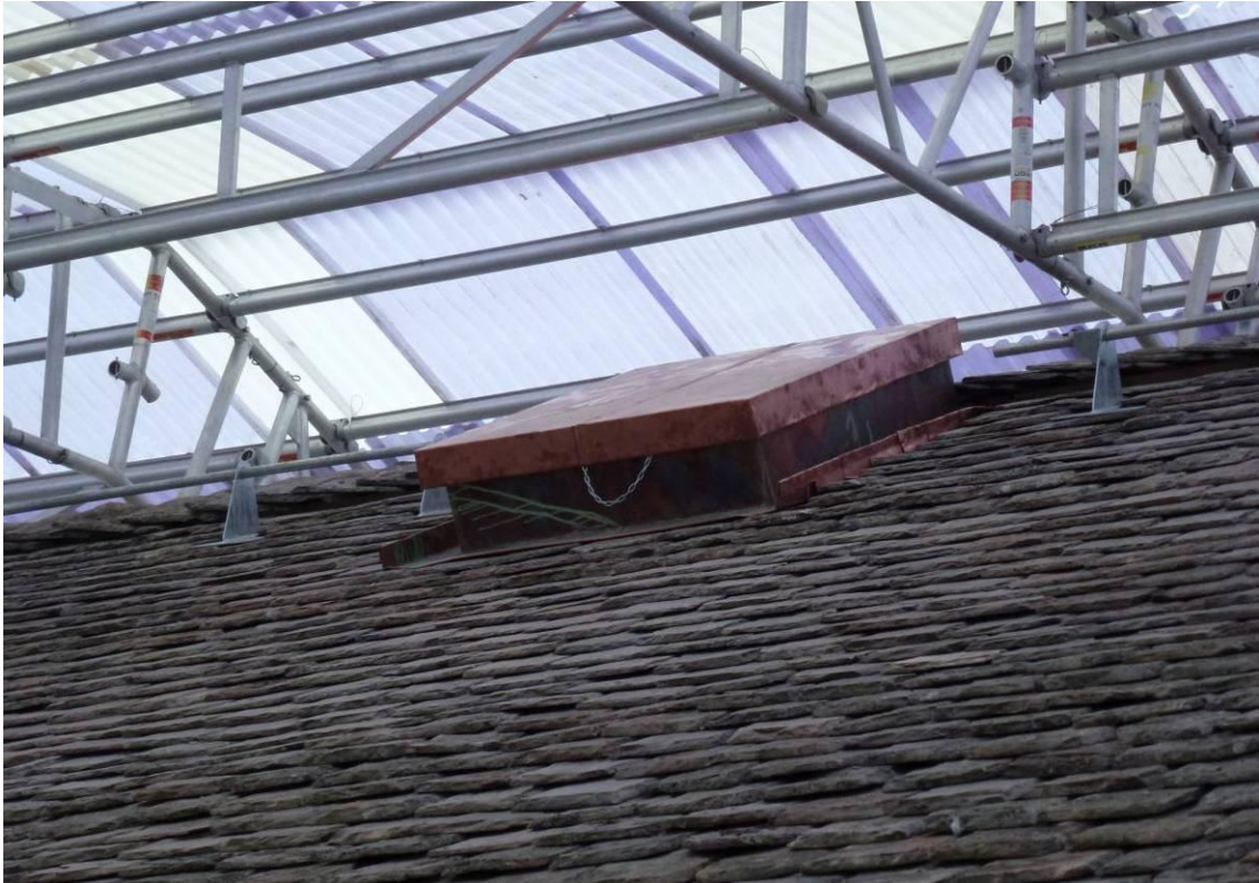
Figur 27. Efter åtgärder. Ny taklucka och plåtinklädnad runt luckan i kopparplåt. Nytt varmförzinkat nockräcke.
