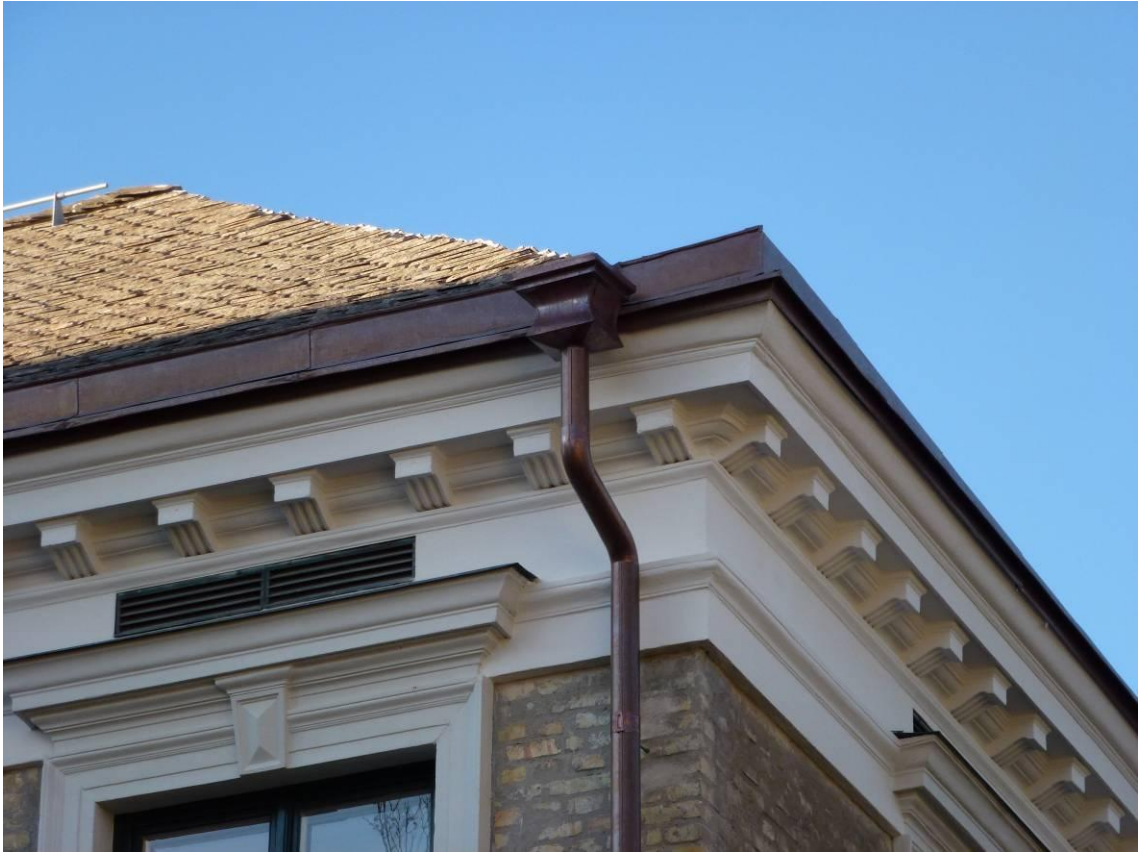
Figur35. Efter åtgärder. Nordöstra hörnet.
