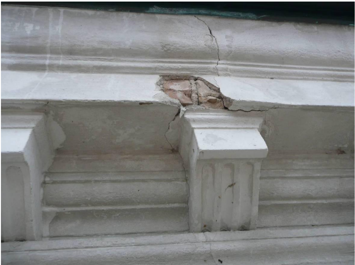
Figur 15. Före åtgärder. Exempel på skador i takgesimsen.
