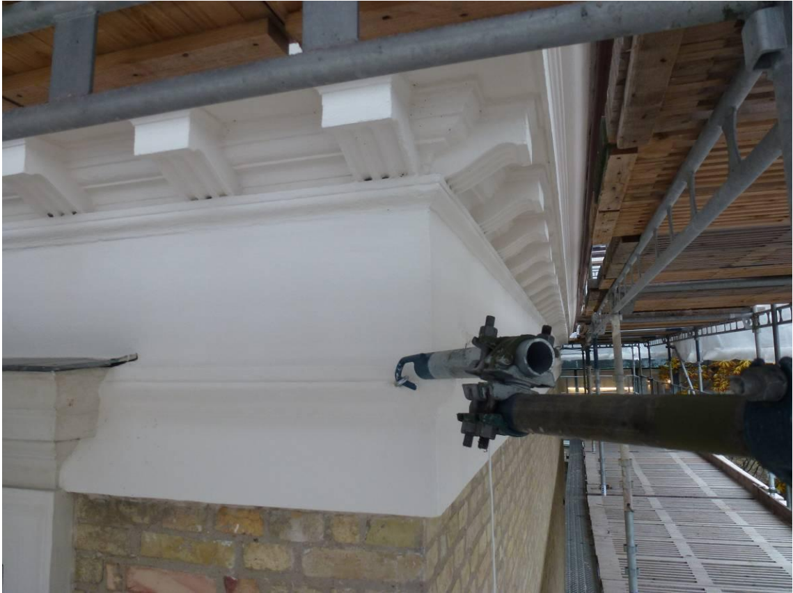
Figur 30. Efter åtgärder. Putslagad och målad takfot.
