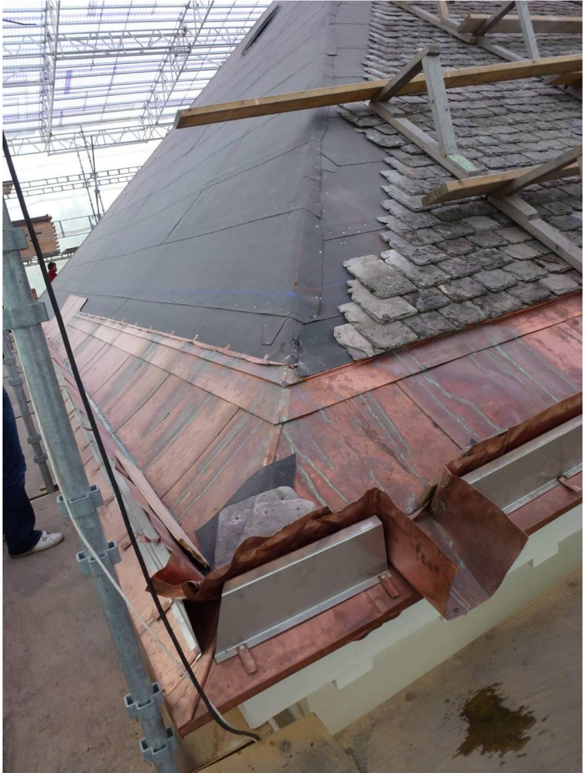
Figur 19. Den nya fotrännan under uppförande. Glavaskiffer har spikats på det västra takfallet.
