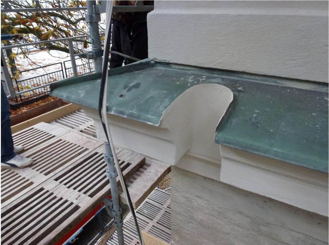
Figur 29. Mycket välgjorda urtagningar för de nya stuprören i de horisontella listverken.
