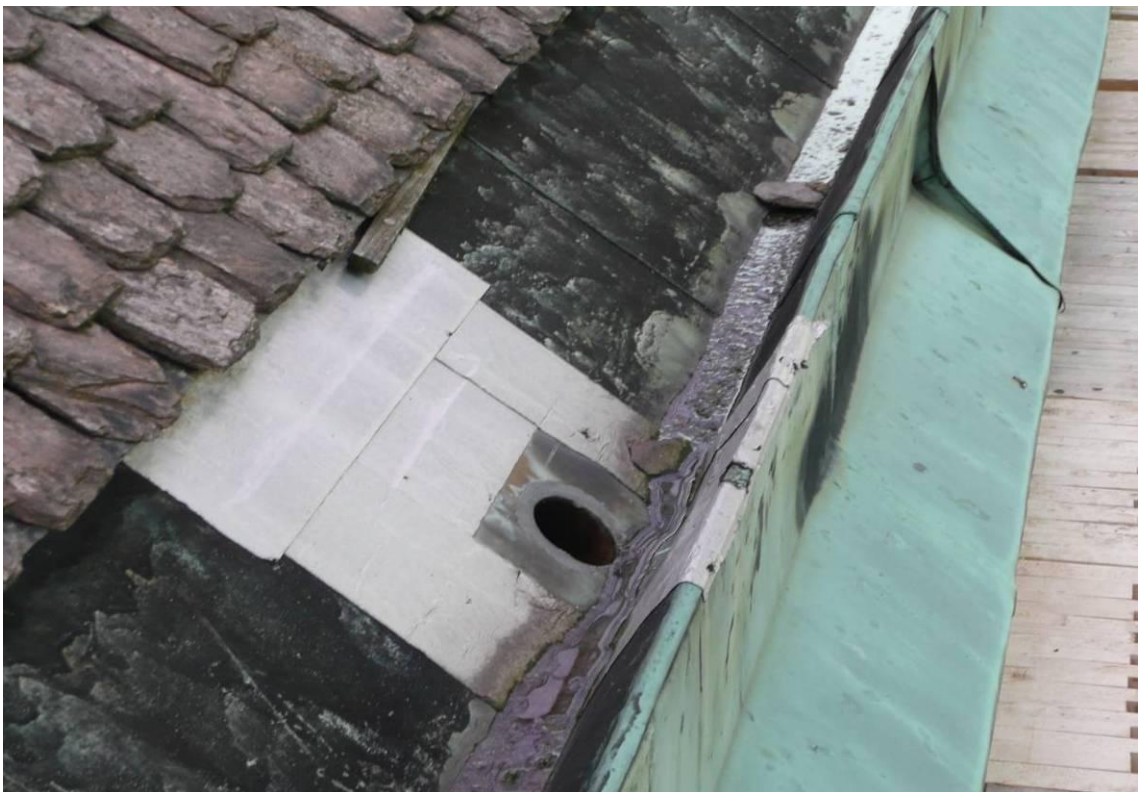
Figur 8. Före åtgärder. Hål till invändigt stuprör. I fotrännan som uppfördes på 1960-talet syns den stående falsen som återkom med jämna mellanrum.
