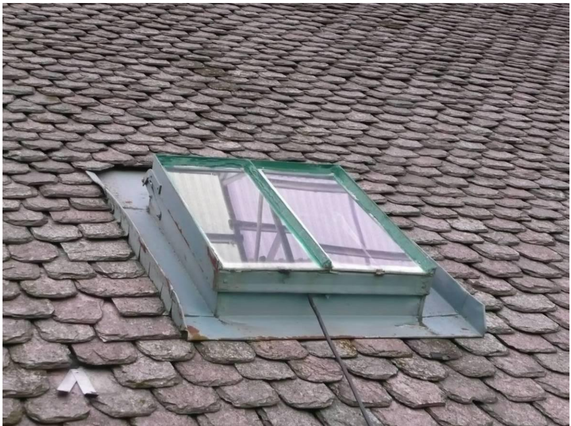
Figur 11. Före åtgärder. Takfönster.
