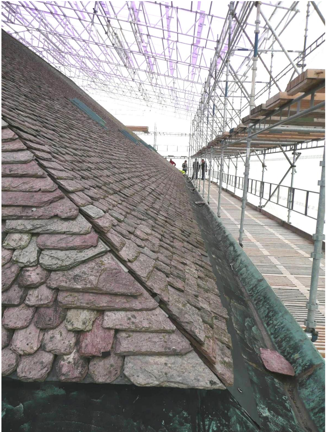
Figur 6. Före åtgärder. Östra takfallet. Ramkvillaskiffer. Fotrännan är rak och har ytterst litet fall.
