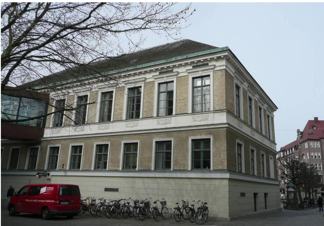
Figur 2. Före åtgärder. Vy från nordost.
