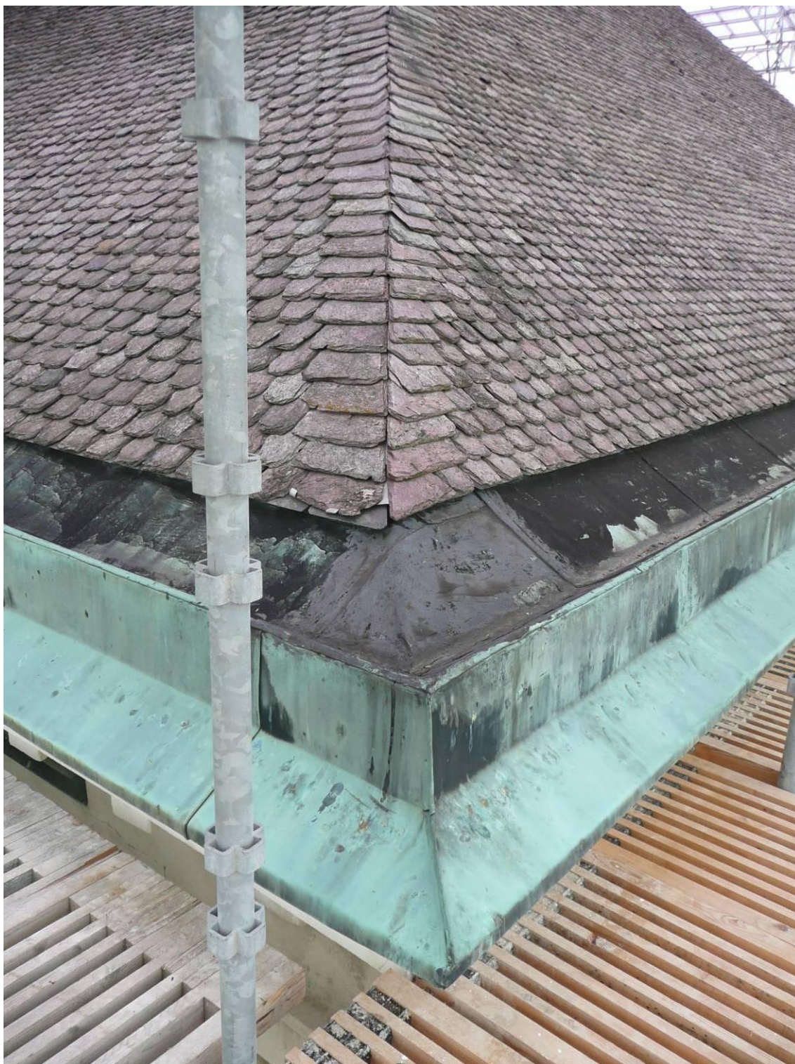
Figur 5. Före åtgärder. Ramkvillaskiffer med rundad kant. Fotrännan i kopparplåt är grund och flack. Fotsten i Grythyttanskiffer syns under den nedresta skifferraden.
