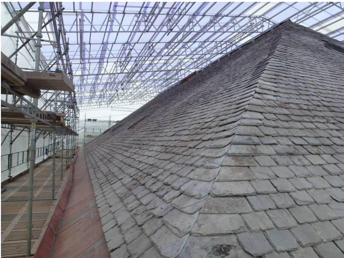
Figur 23. Östra och norra takfallen, Glavaskiffer.
