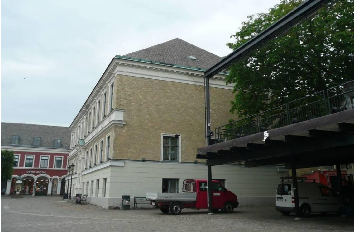
Figur 3. Före åtgärder. Vy från sydväst. Fuktskador syns i fasaden, under takfönstret.
