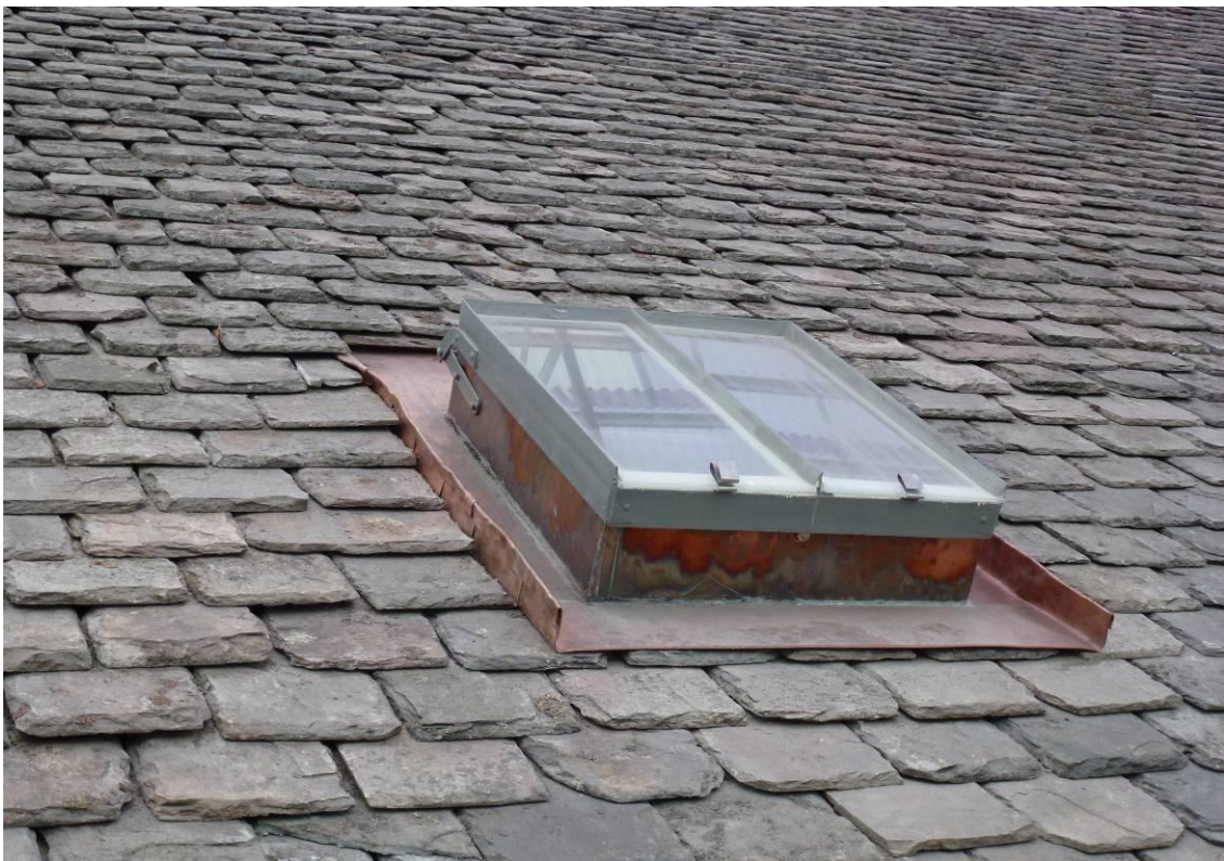
Figur 25. Efter åtgärder. Takfönstret är renoverat och målat. Förhöjd sarg och ny plåtbeslagning kring takfönstret i kopparplåt.
