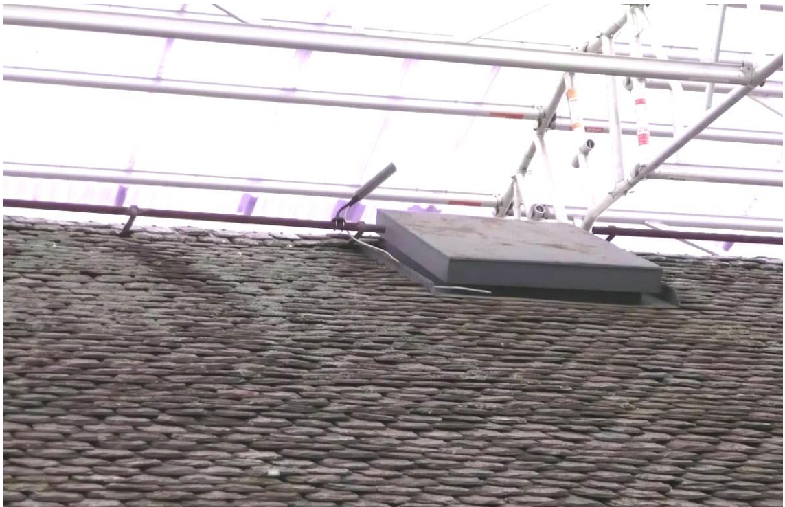
Figur10. Före åtgärder. Taklucka och nockräcke i öster.
