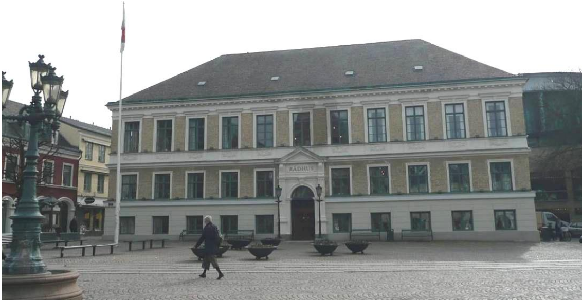
Figur 1. Före åtgärder. Södra fasaden. Fuktskador i fasaden syns ovan entrén.
