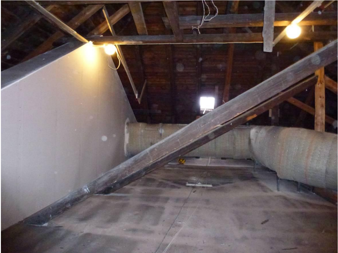
Figur 38. Efter åtgärder, vinden. Takbjälkarna med järn har klätts in med gipsskivor och golvet har täckts med gipsskivor.
