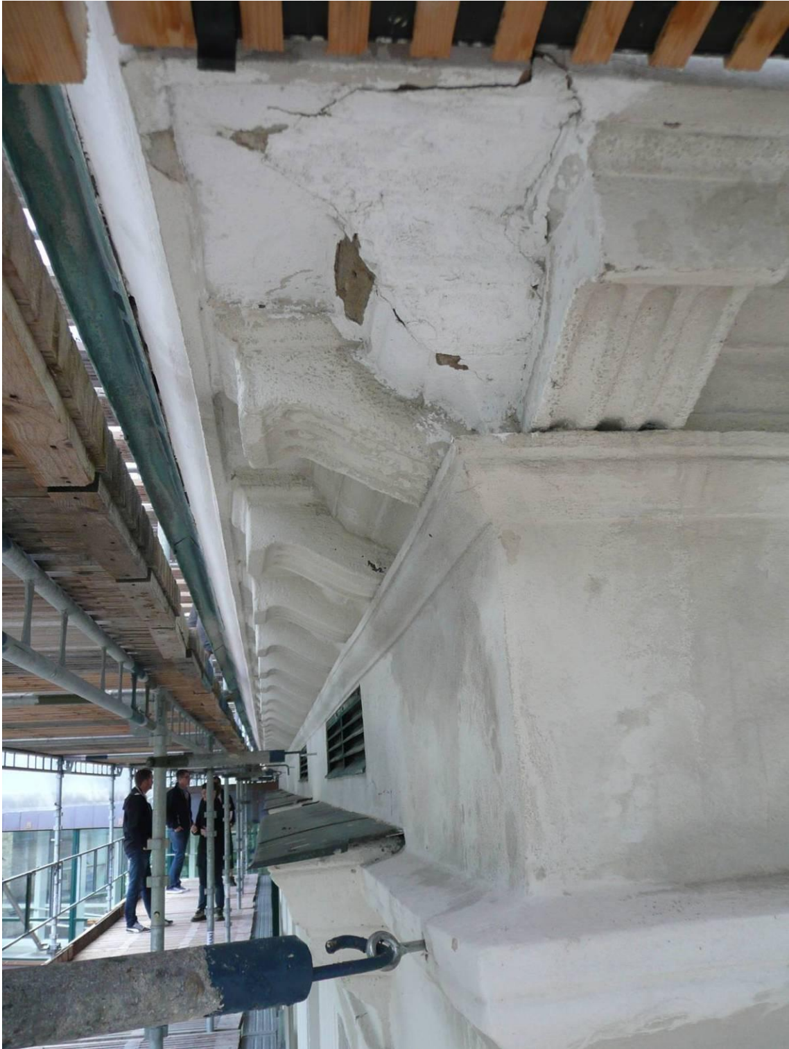
Figur 16. Före åtgärder. Skador och tidigare lagning i gips i takgesimsen, nordöstra hörnet. Hål för ställningarna lagades i samband med att ställningarna togs ner.
