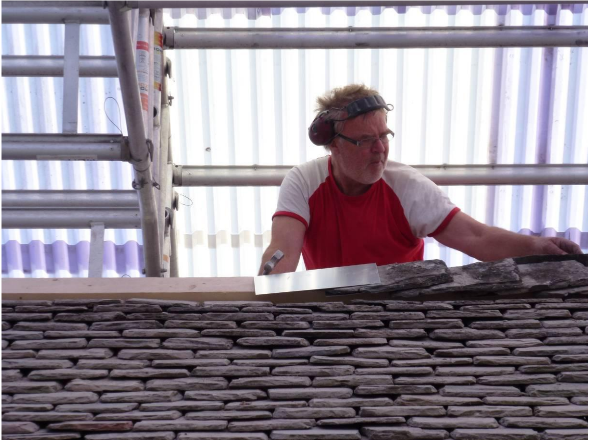
Figur 20. Nocken åtgärdades med ny nockbräda, Glavaskiffer med dolda spikar, inskottsplåtar i aluminium.
