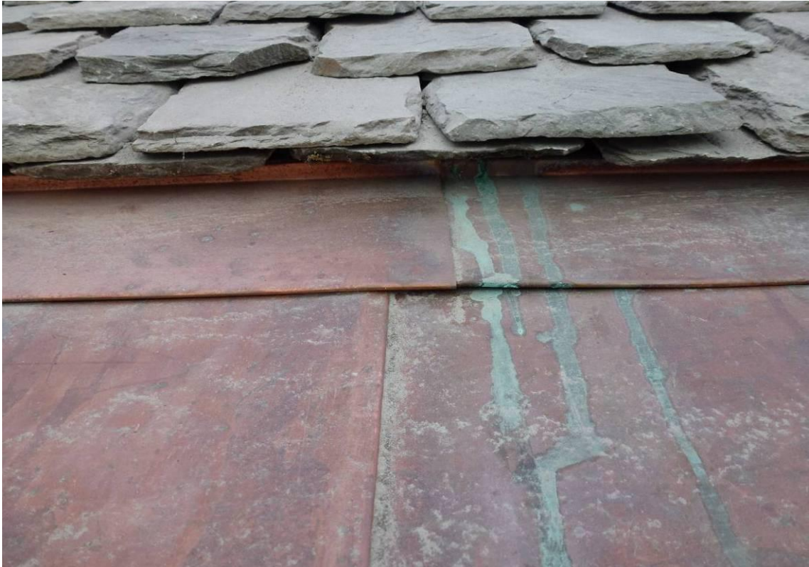
Figur 22. Glavaskiffer och fotsten av Grythyttanskiffer, vilar på kilen i plåten, vilken ersatt den tidigare träläkten. Kopparplåten är dubbel för bättre hållbarhet.
