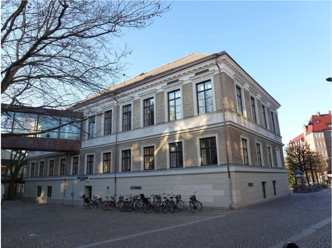
Figur 32. Efter åtgärder. Vy från nordost.
