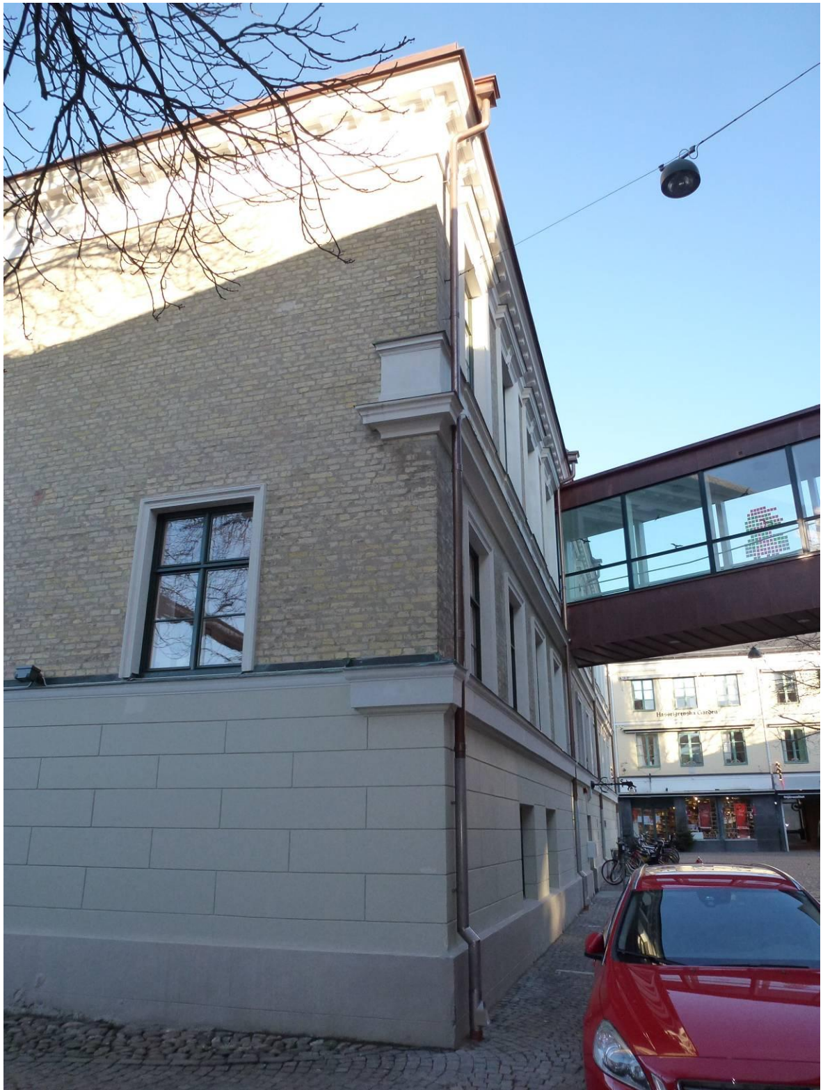
Figur 34. Efter åtgärder. Sydöstra hörnet. Vandalskydd är monterade längst ner på stuprören.
