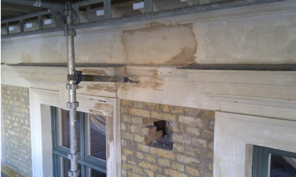
Figur 17. Putslagningar pågår. Inspektionsöppning i fasaden för kontroll av fuktskador. Öppningen murades igen med befintligt tegel. Foto: Intermur AB.
