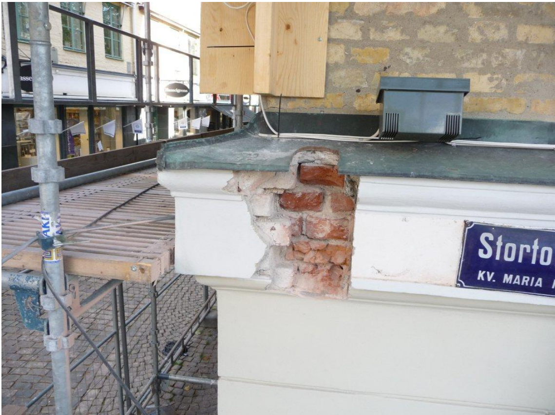
Figur 28. Urtagning i listverk för nytt stuprör. Foto: Intermur AB
