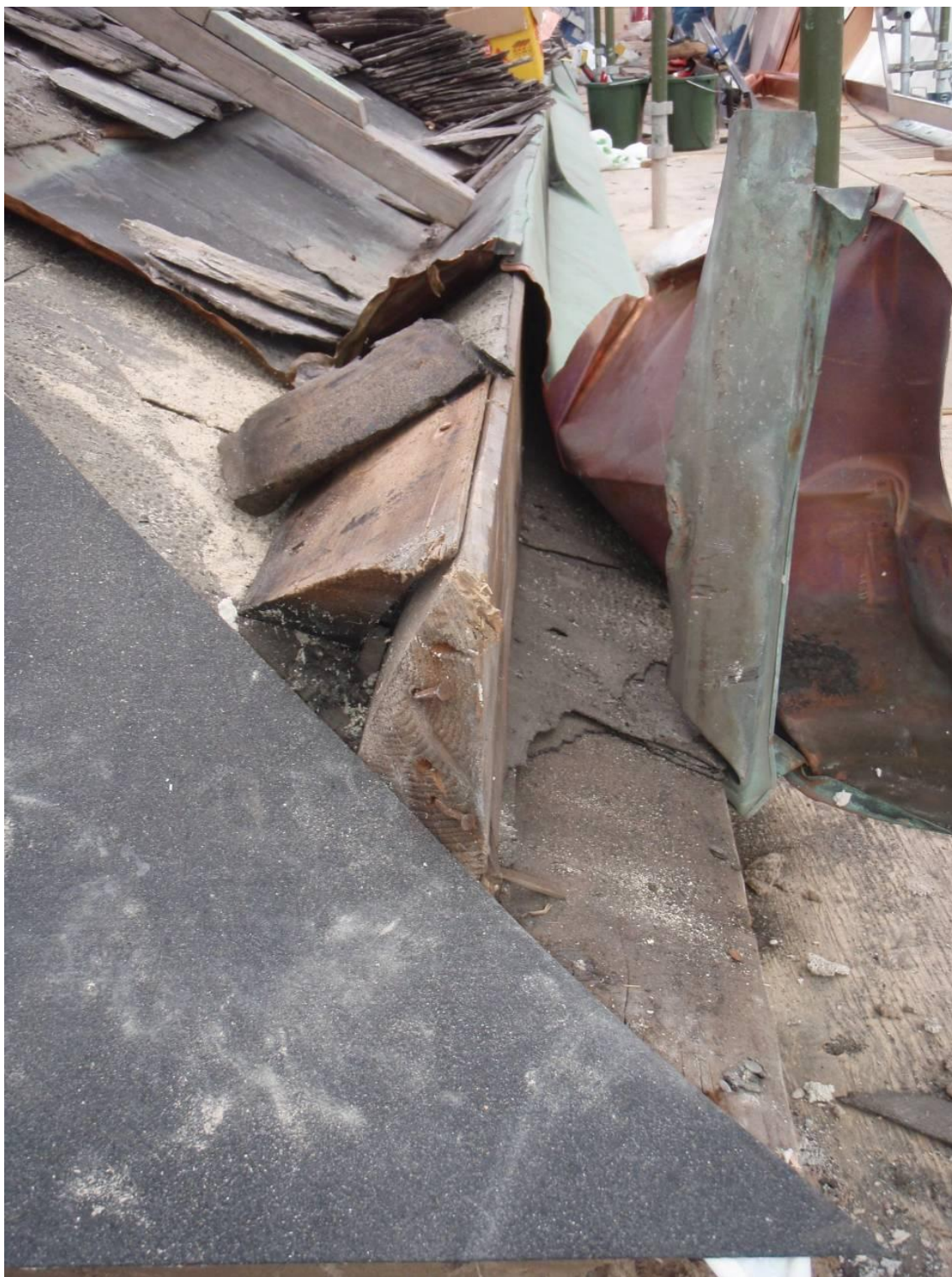
Figur 9. Foto i det sydöstra hörnet. Under arbetet med att riva den gamla fotrännan. Fotrännan var uppförd med trästomme och två plåtar som var falsade mitt ovan trästommen. I förgrunden av bilden ny takpapp.
