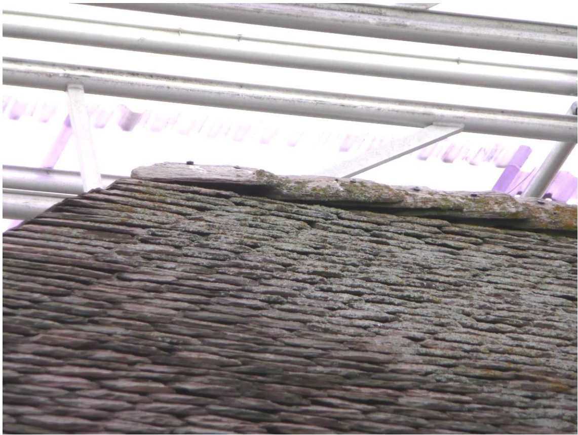
Figur 12. Före åtgärder. Ramkvilladkiffer i nock, spikat med synliga spikar och packning.
