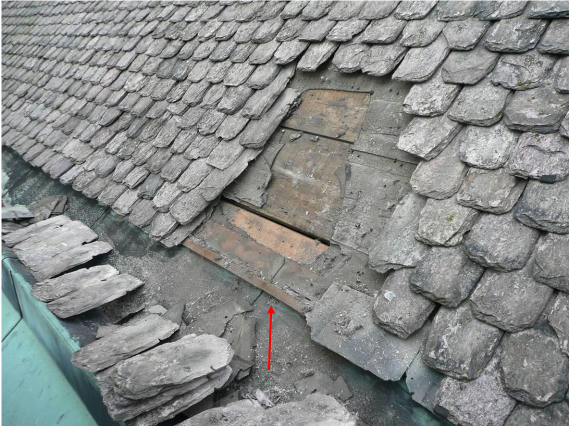
Figur 7. Före åtgärder. Ramkvillaskiffer har börjat tas ner. Glipor mellan underlagsbrädor. Pilen markerar trälakten som ersattes med en kil i plåten.
