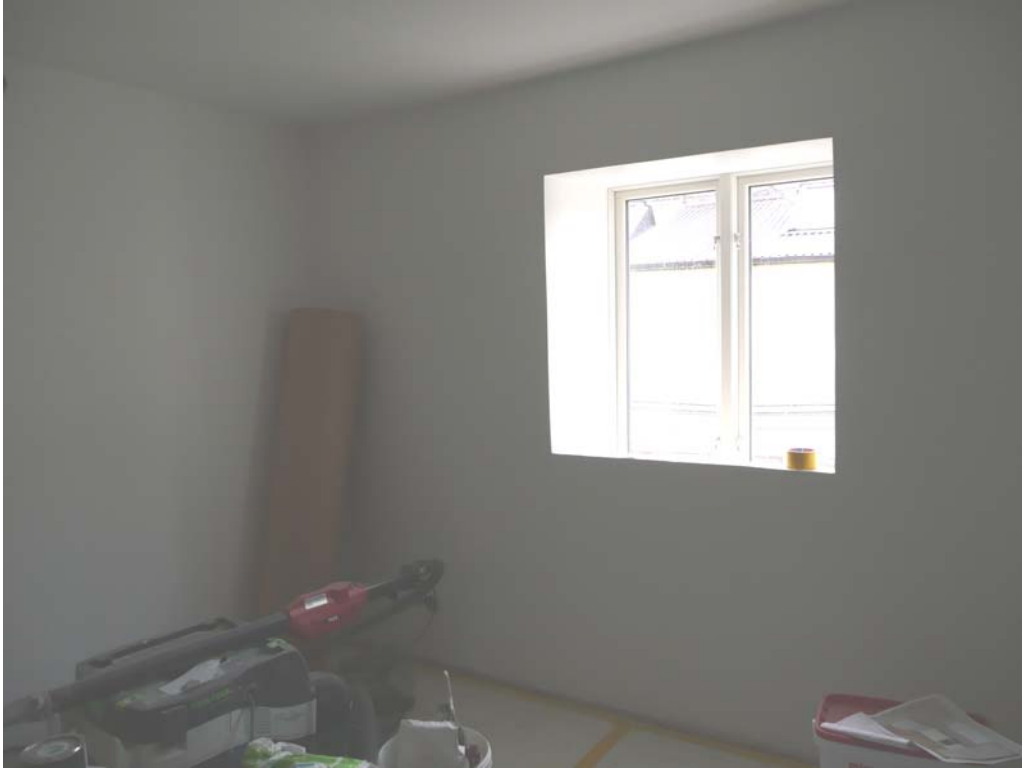
Invändigt har väggarna klänts med reglade gipsskivor ca 15 cm innanför lerstens och tegelväggen.
