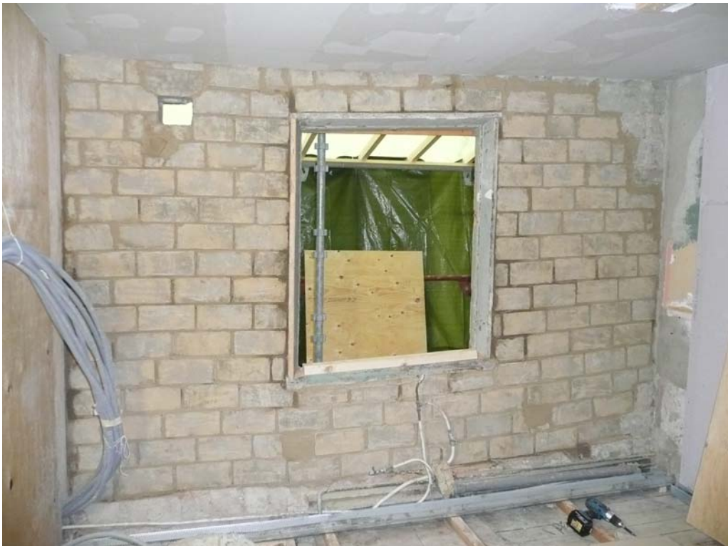
Nyuppmurad innervägg av lersten. Samma rum som bilden ovan.
