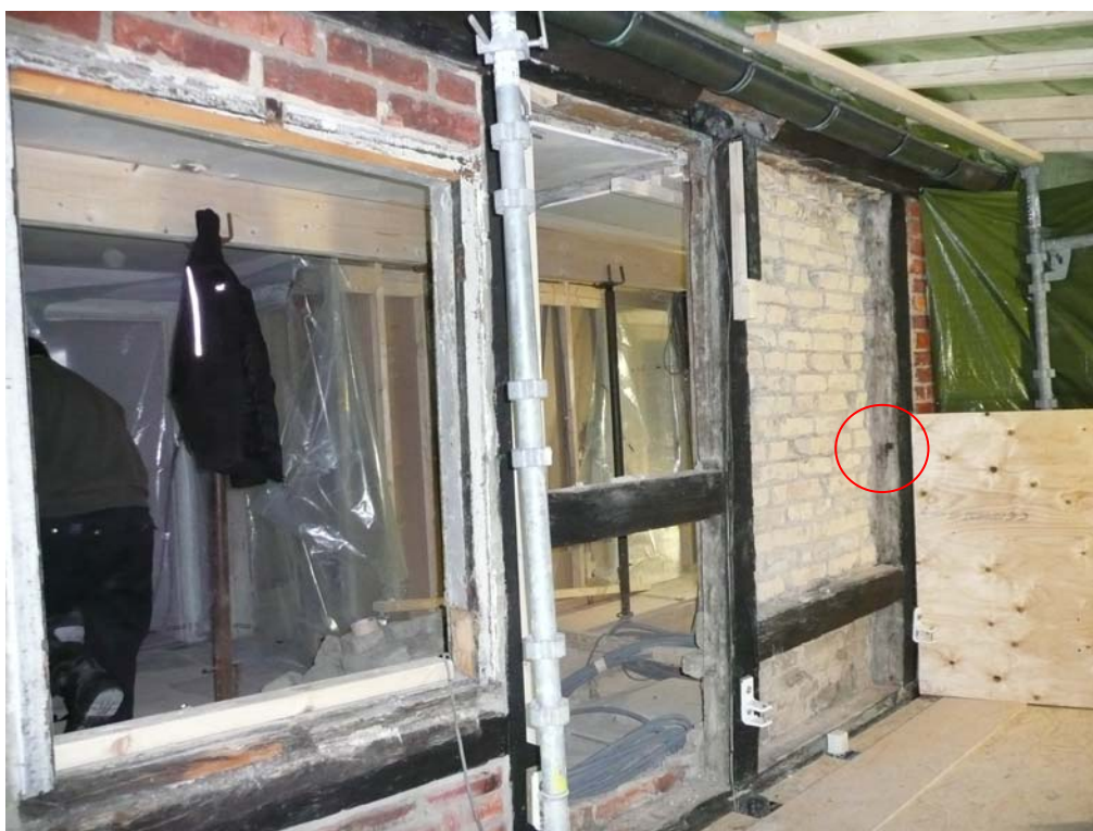
Fyllningarna, det mindre fönstret och innerväggen av lersten har plockats ner. Till höger i bild ser man innerväggen i gult lättbränt tegel före åtgärd. Här ser man också genom spår i stolpen att lösbulten längs till höger i bild tidigare suttit högre upp (markerat med cirkel) i samma nivå som lösbulten mitt i bild. De gamla fönsterkarmarna med många lager av färg sparades. Nya fönster placerades innanför de gamla karmarna.
