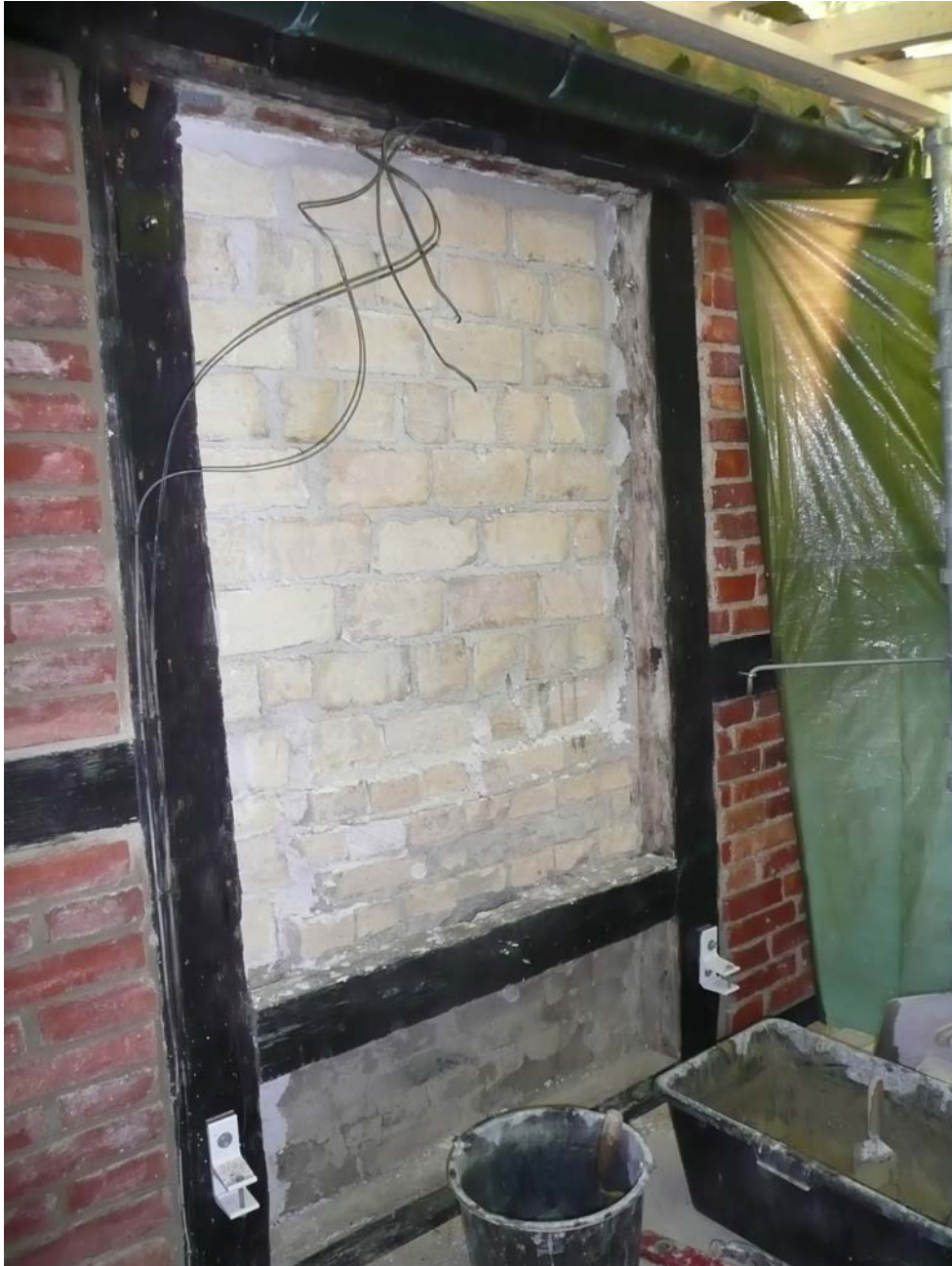
Till vänster i bild har fack 1 och 3 murats upp på nytt. Det gula teglet mitt i bilden är den nyuppmurade innerväggen av det återanvända modernare gula lättbränt teglet innanför fack 2 och 4.
