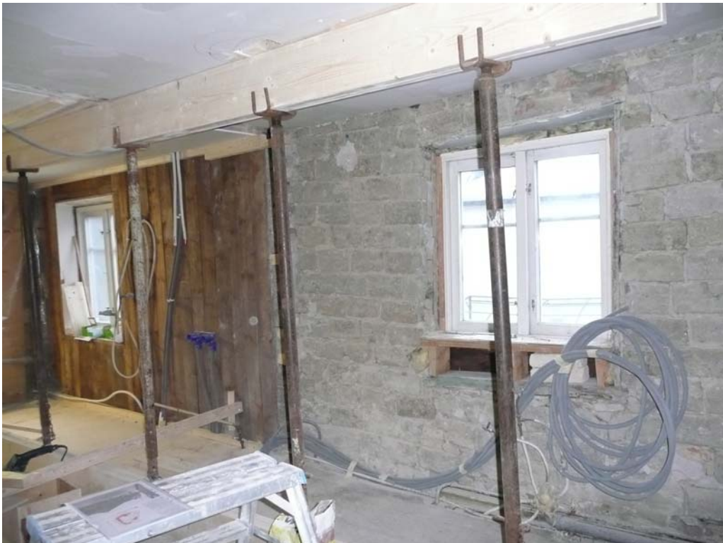
Före åtgärd. Samma lerstensvägg som på bilden ovan. Bakom vägghälsan finns gult modernare tegel. Dessa två fönster byttes ut under renoveringen.
