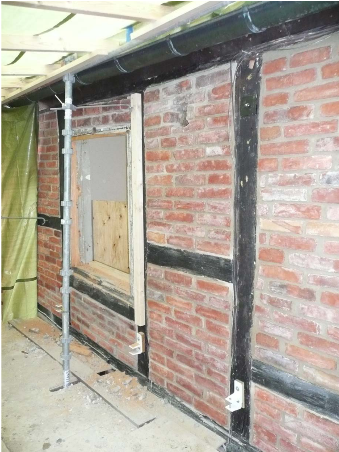
Nyuppmurade tegelfyllningar. Tegelstenarna har placerats på samma plats som före åtgärden.
