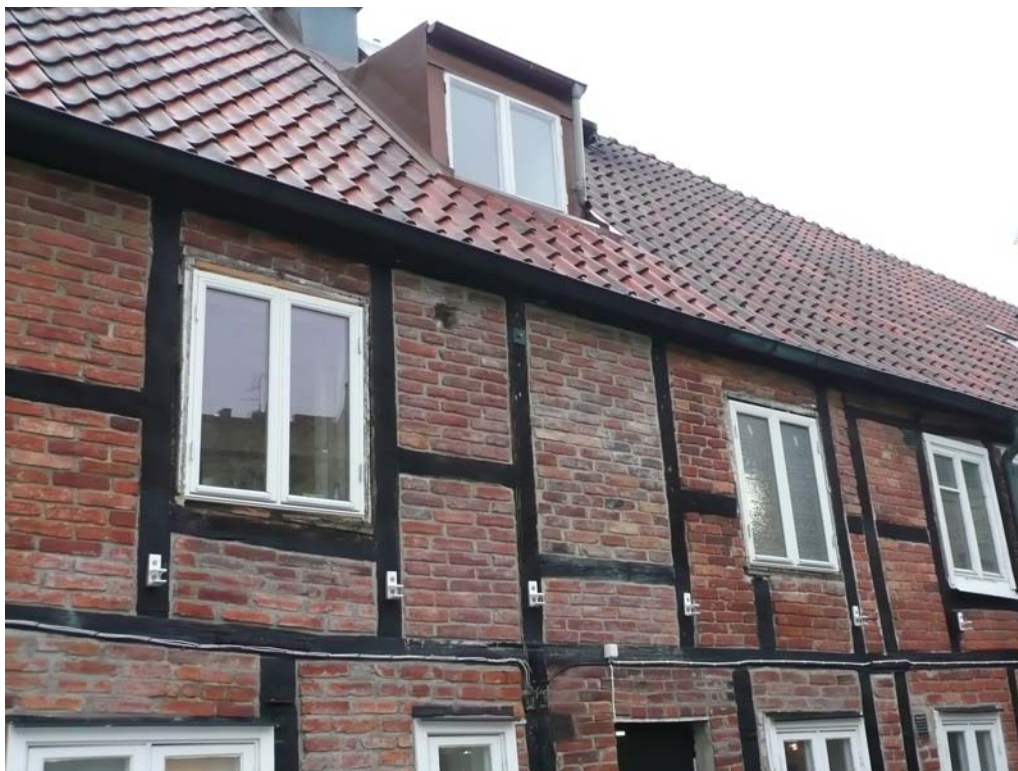
Här har de nya fönstren monterats in men fogbruk saknas ännu mellan karm och stolpe samt fönsterfoder och fönsterbleck.
