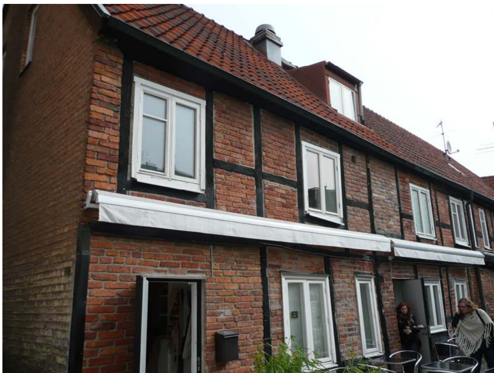
Efter åtgärd. De aktuella fönstren är fönster två och tre från vänster räknat samt fack sex och sju från vänster räknat.
