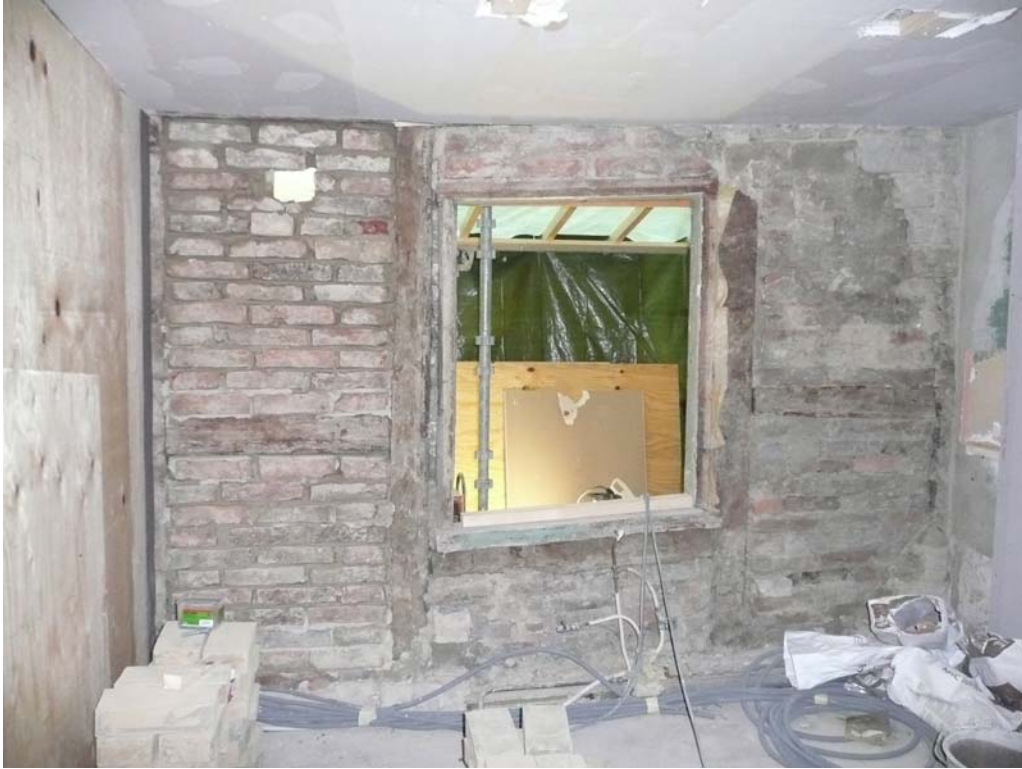
Här ser man fasadteglet från insidan. Till vänster i bild, tegelfyllningarna i fack 1 och 3 är nyuppmurade. En ventilationsglugg har öppnats upp i väggen i fack 1.
