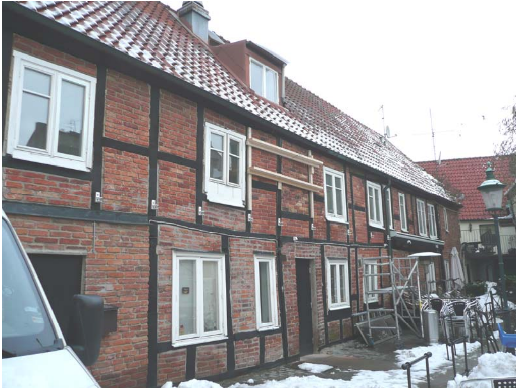
Vy från sydväst, gårdsfasaden före åtgärd. De aktuella facken i övre våningen hade stabiliserats.
