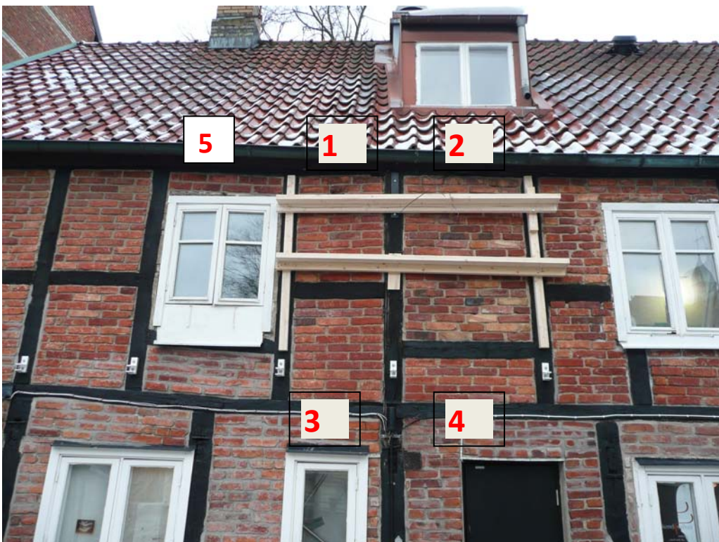
Före åtgärd, den södra fasaden. De skadade korsviksfacken hade provisoriskt stabiliserats innan inledande besiktning. I fack 2 finns spår i stolparna av att löshulten tidigare suttit i nivå med löshulten i facken bredvid. Löshulten är idag inte itappad i stolparna, vilket kan bidra till instabilitet i facket. Äldre fotografi visar att det i fack 2 har funnits ett fönster. Stolpen är fäst med plattjärn i lejden.
