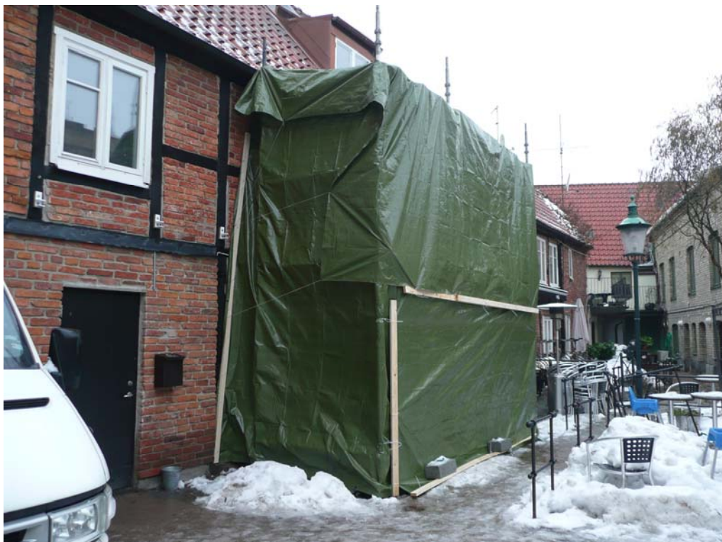
Under arbetets gång skyddades fasaden med presenningar.
