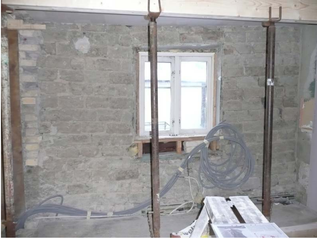
Före åtgärd. Den invändiga lerstensväggen bakom fack 1 och 3 samt det mindre fönstret. Lerstensväggen var mest skadad till böger i bild (mot väster). Till vänster i bild ser man spår i teglet där en mellanvägg tagits bort.
