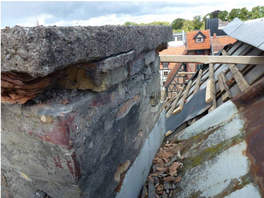
Under arbete. Skorstenen.
