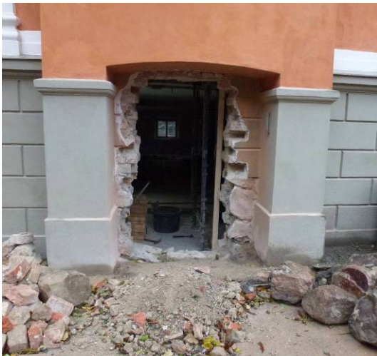
Under arbete. Vänster: Ny öppning i norr. Höger: Söder om trappan skador i sockeln.
