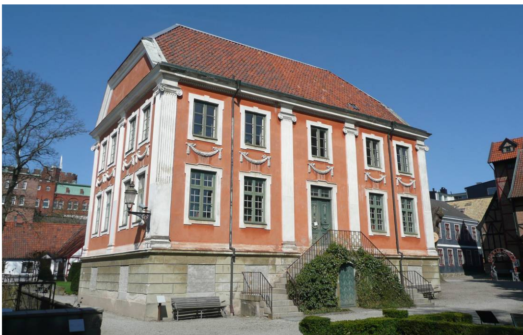
Före åtgärder. Södra och östra fasaderna.
