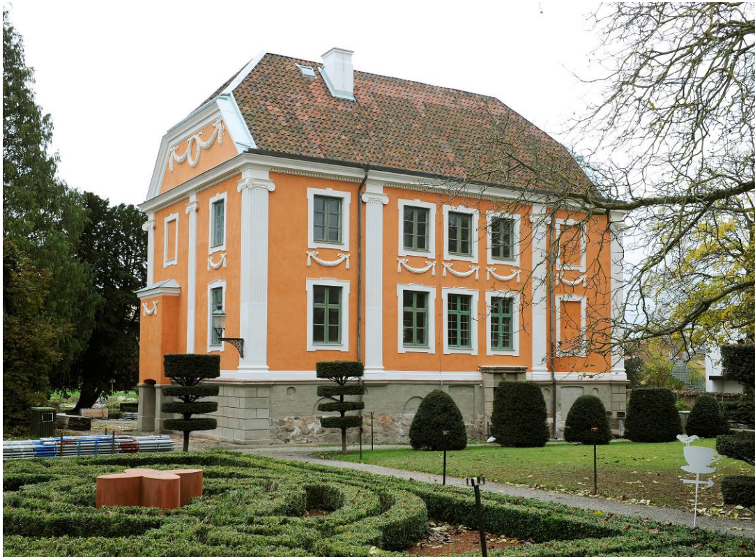
Efter åtgärder. Norra och västra fasaderna. Fönstren är ännu inte målade.
