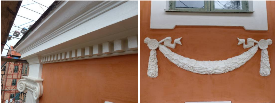
Efter åtgärder. Vänster: takfotslist i nordvästra hörnet. Höger: Festong och fönsteromfattning.
