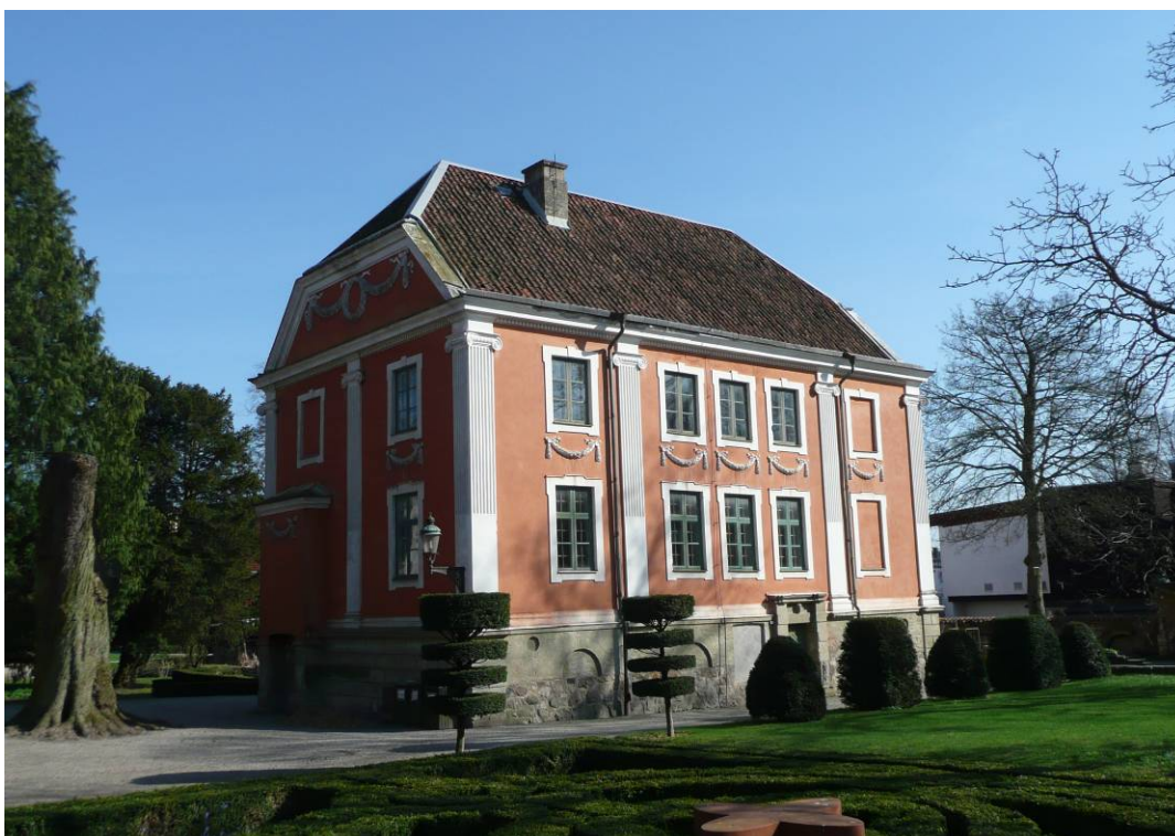
Före åtgärder. Norra och västra fasaderna.
