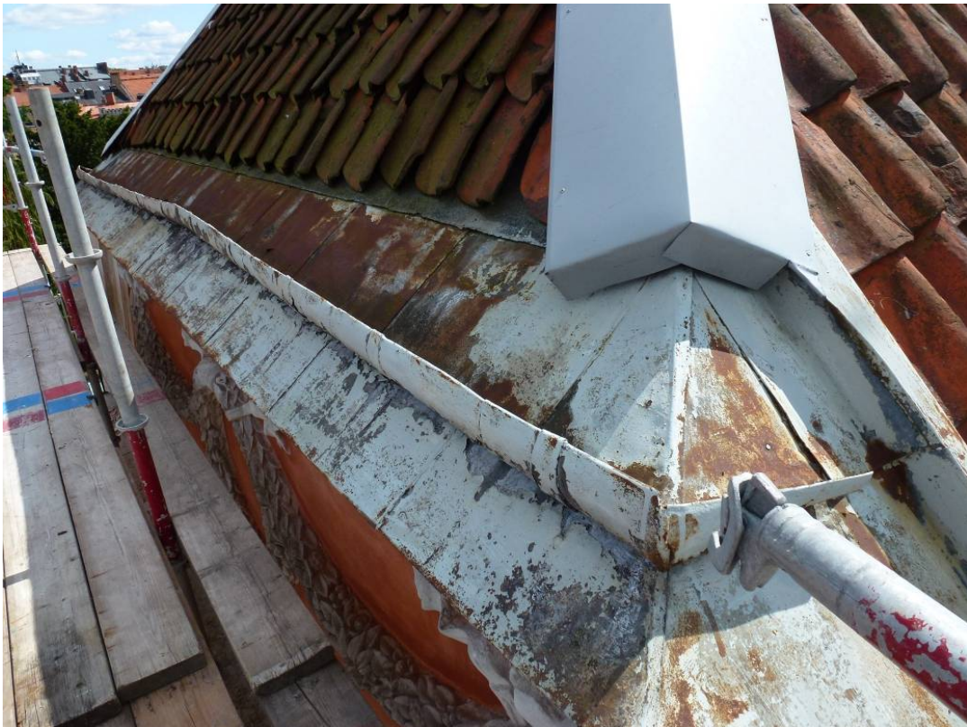
Före åtgärder: Den gamla fotrännan i norr.
