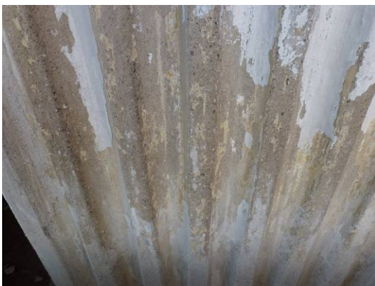
Under arbete. Exempel på underliggande gula färgskikt pilaster och fasad och festong.
