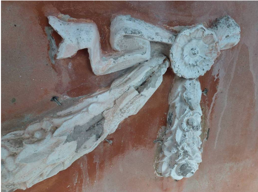
Under arbete. Ny infästning festonger.
