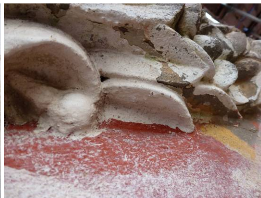
Under arbete. Exempel på underliggande gula färgskikt pilaster och fasad och festong.
