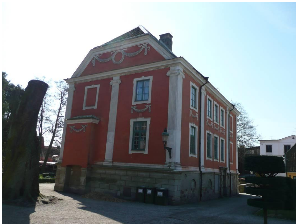
Herrehuset 2011. De rundade fönstren mot väster öppnas inte upp. Ett rektangulärt fönster höger (söder) om dörren öppnas upp.
