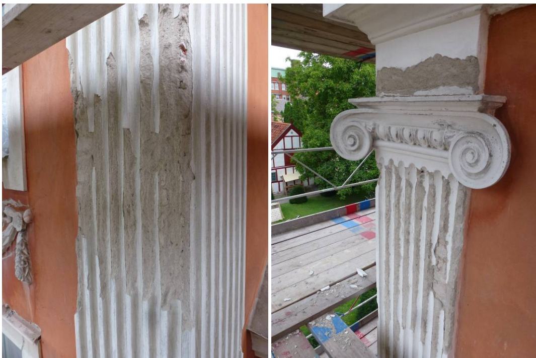
Under arbete. Vänster: Pilaster i nordöstra hörnet. Höger: Pilaster i sydvästra hörnet.
