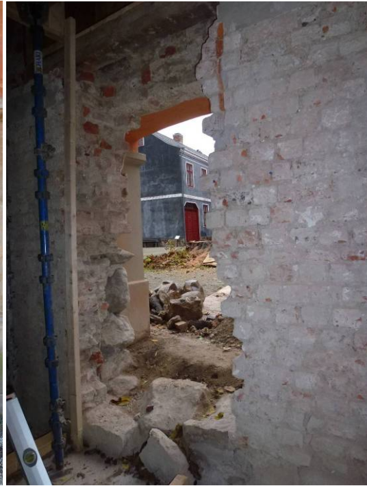
Under arbete. Ny dörrupptagning i norr. Höger: Det nya dörrhålet i norr sett inifrån.
