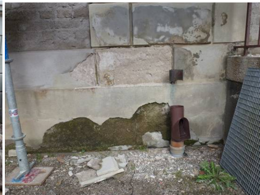
Under arbete. Vänster: Ny öppning i norr. Höger: Söder om trappan skador i sockeln.
